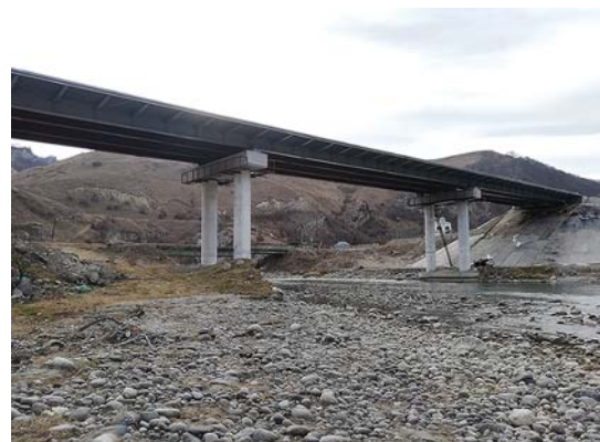
Мост через р.Бакса. Система ТН-АНТИКОР Ультра
