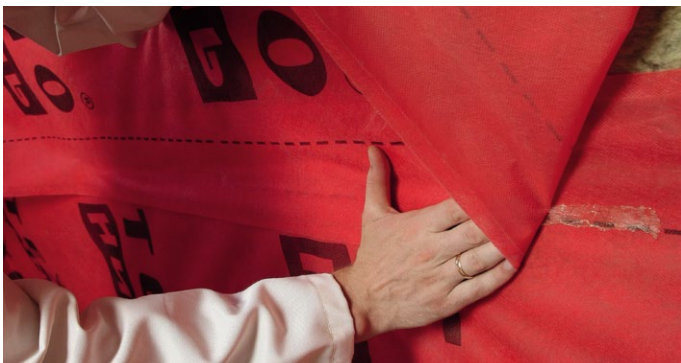
Рис. 6. Проклейка стыков пароизоляционной пленки
