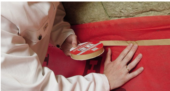
Рис. 5. Укладка и фиксация пароизоляционной пленки
