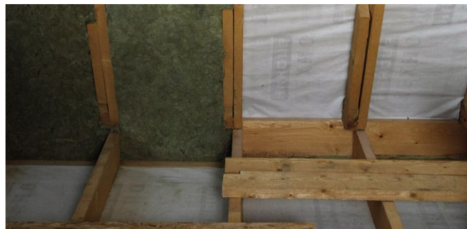
Рис. 2. Подготовленная система для дальнейшего монтажа теплоизоляции
