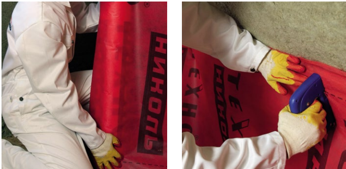
Рис. 5. Укладка и фиксация пароизоляционной пленки
