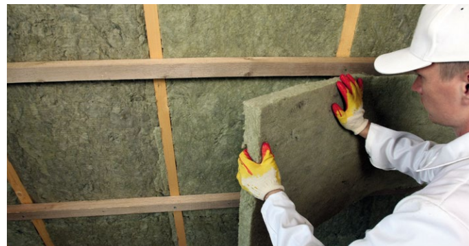
Рис. 4. Укладка второго слоя теплоизоляции
