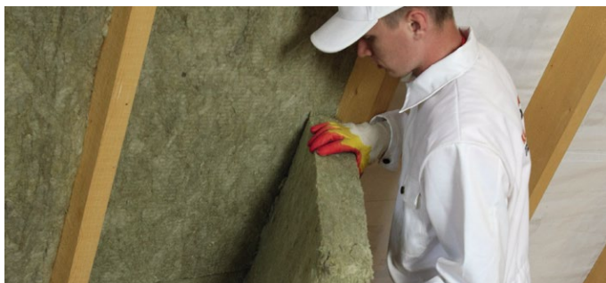
Рис. 3. Монтаж теплоизоляции враспор между стропилами
