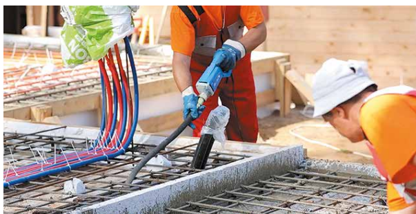
Вибрация бетонной смеси в ребрах жесткости.
