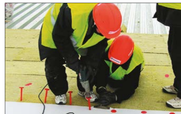
Рис. 5.4.5 Натяжение мембраны
