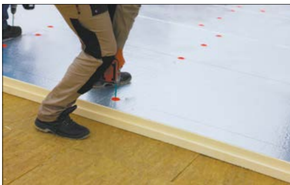
Рис. 2.4.1 Монтаж системы ТН-КРОВЛЯ СМАРТ PIR
