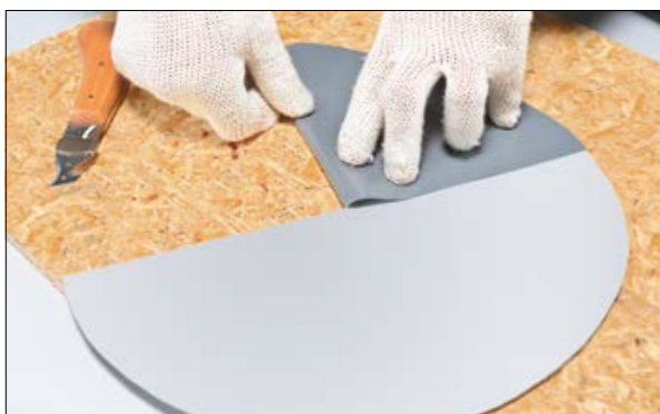
15. Загните получившийся сегмент и прикатайте его валиком.
