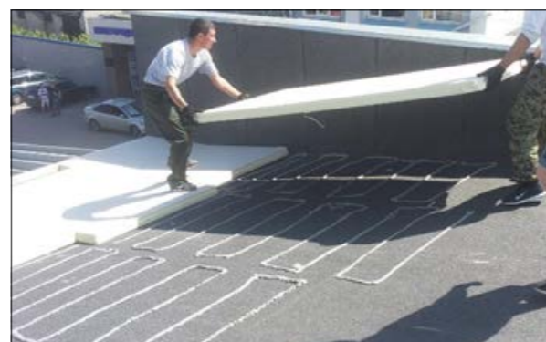
Рис. 2.9.4 Приклеивание плит LOGICPIR на Клей-пену LOGICPIR
