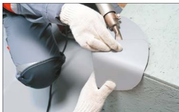
18. Соедините радиусы окружности, так чтобы получилась воронка с перехлестом на величину сварного шва (20 мм). Приложите деталь к углу и, притянув пальцами обе части окружности, точно прихватите их друг к другу феном.
