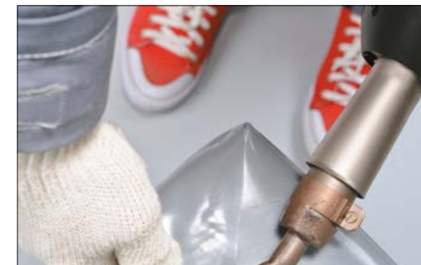
20. Выверните деталь наизнанку и проварите шов с внутренней стороны. Проверьте качество сварного шва пробником.
