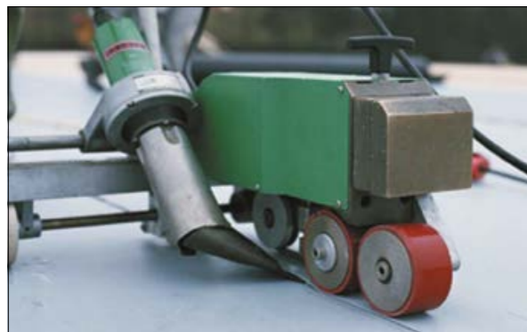
Рис. 5.2.1 Процесс автоматической сварки
