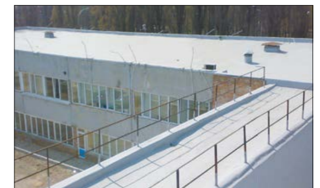
Рис. 2.9.2 Вид кровли после ремонта полимерными мембранами с доутеплением
