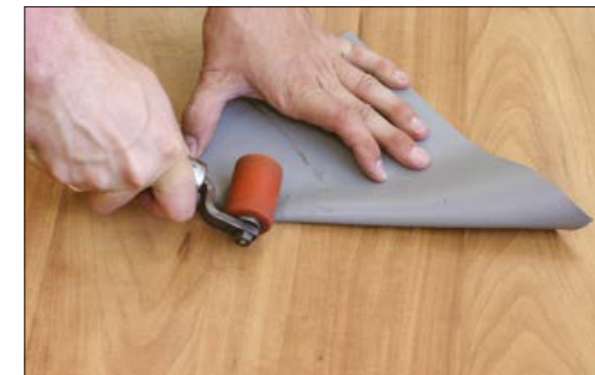
2. Прикатывая валиком складки по диагоналям, находим середину квадрата и отмечаем маркером.
