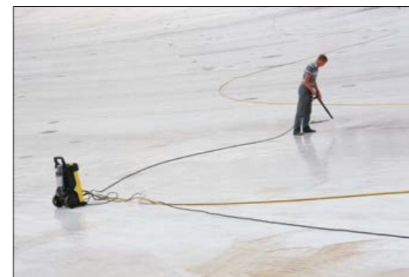
Рис. 2.9.5 – Рис. 2.9.6 Подготовьте старое основание: очистите, обеспыльте, просушите
