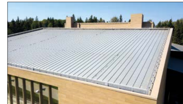
Рис. 4.8.2 Вид мембранной кровли с имитацией фальца
