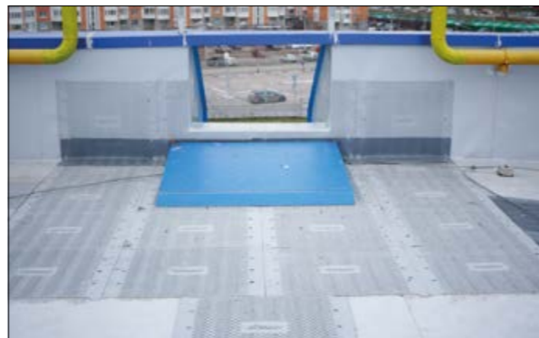
Рис. 4.8.18 Устройство зоны выхода на кровлю и пешеходных зон от нее с помощью пешеходной дорожки LOGICROOF Walkway Puzzle
