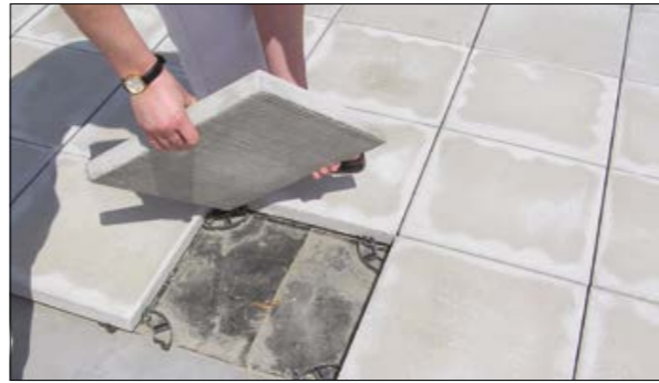
Рис. 2.7.3 Применение в качестве балласта тротуарной плитки
