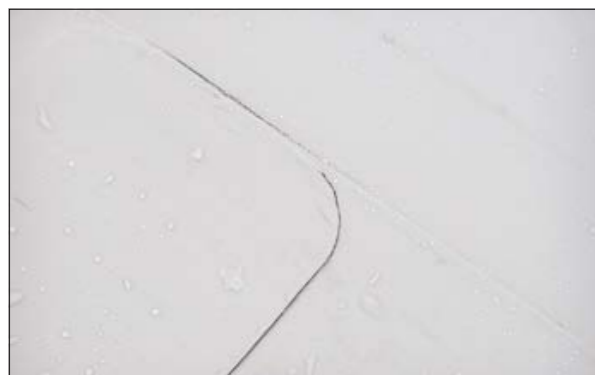
Рис. 5.4.1 Скругление углов мембраны
