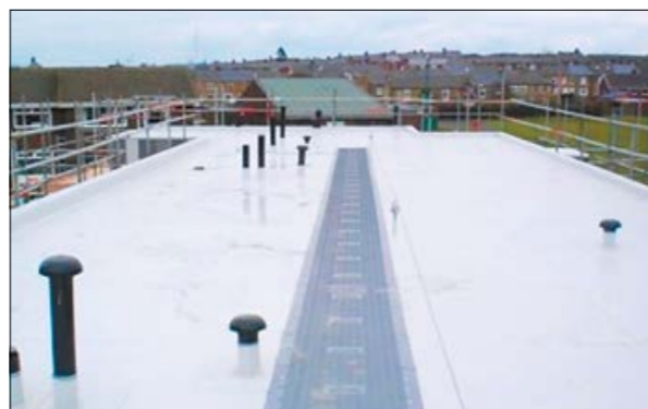
Рис. 4.8.16 Пешеходная дорожка LOGICROOF Walkway Puzzle на кровле
