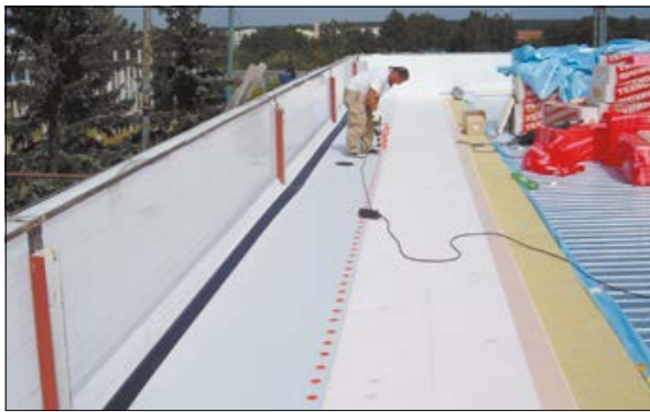
Рис. 3.5.17 Монтаж метровых рулонов ТЕХНОНИКОЛЬ
