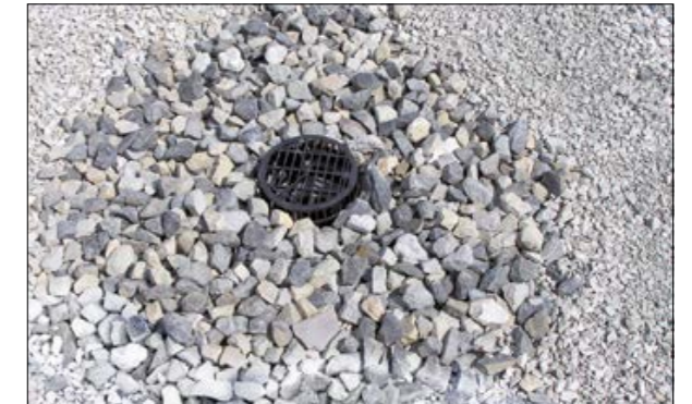
Рис. 2.7.5 Увеличение фракции балласта вокруг воронки
