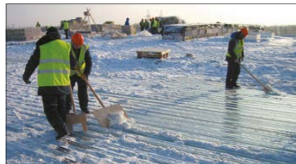
Рис. 3.1.2 Удаления снега и воды из гофр профилированного листа специальной лопатой
