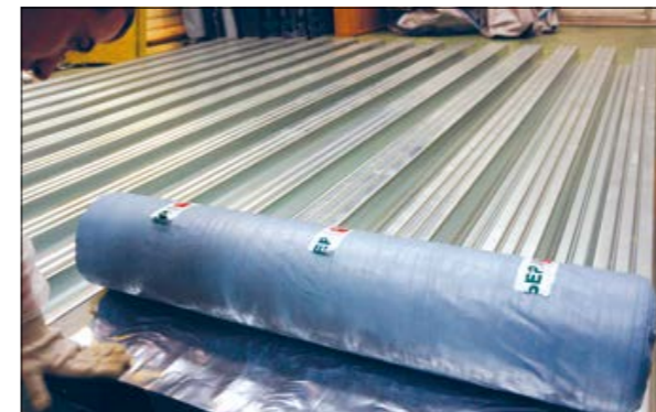
Рис. 3.1.10 Пароизоляция Паробарьер С укладывается вдоль верхних полок профнастила, снимается защитная пленка и материал приклеивается к основанию
