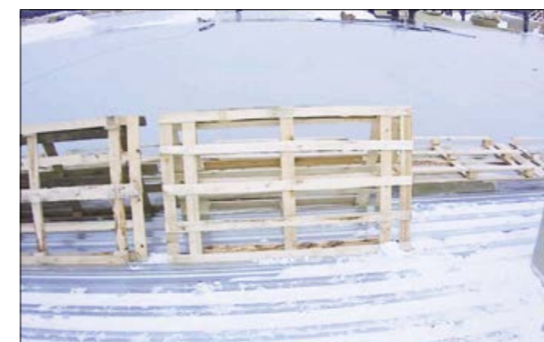
Рис. 3.1.9 Защита края кровельного пирога от хождения
