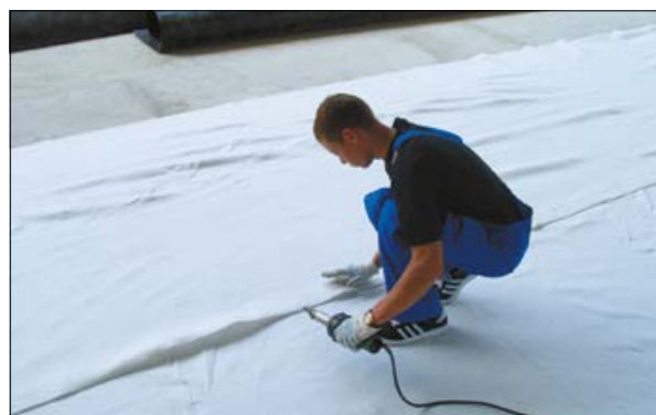
Рис. 3.3.1 Сварка полотнищ геотекстиля между собой
