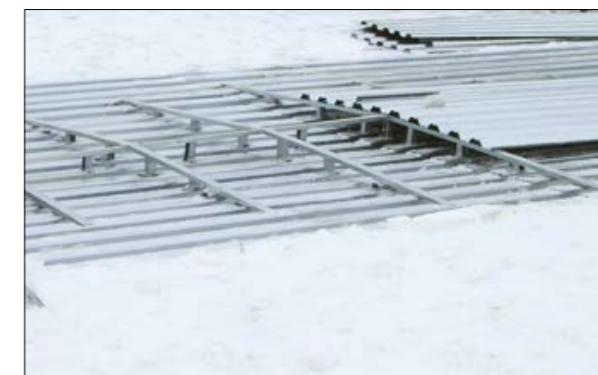
Рис. 3.3.4 Вариант устройства разуклонок
