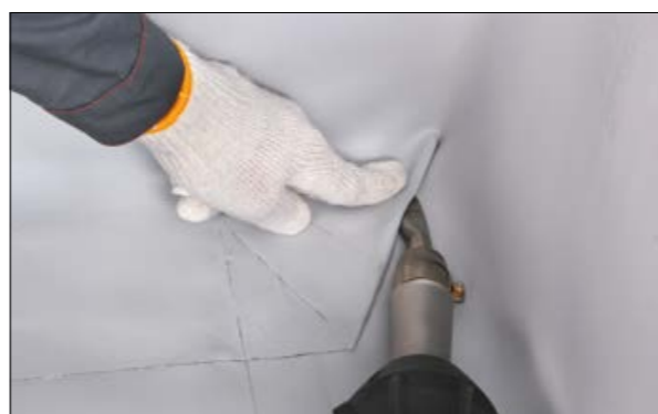
16. Прихватите свободную часть «конверта» с помощью фена.
