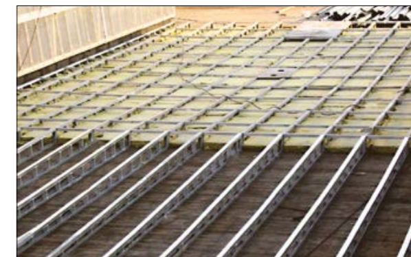
Рис. 3.3.3 Вариант устройства разуклонок
