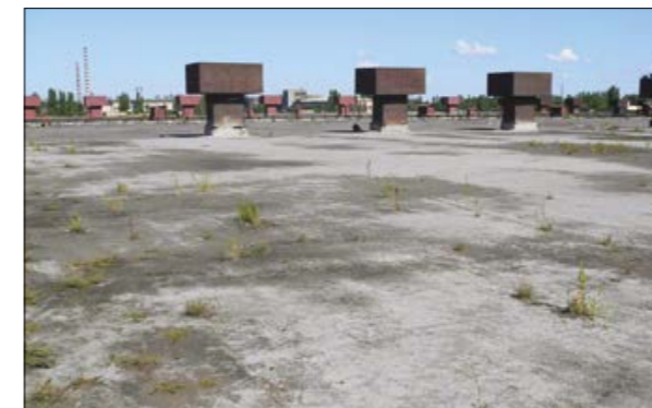
Рис. 2.9.1 Старая битумная кровля
