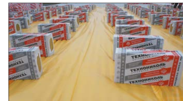
Рис. 3.1.4 Укладка пароизоляционной пленки ТЕХНОНИКОЛЬ
