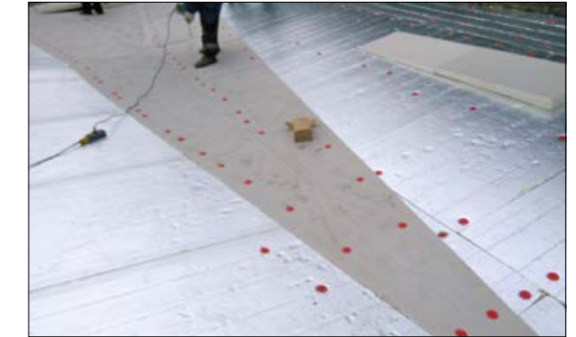
Рис. 3.3.16 Изображение разуклонки в ендове между воронками
