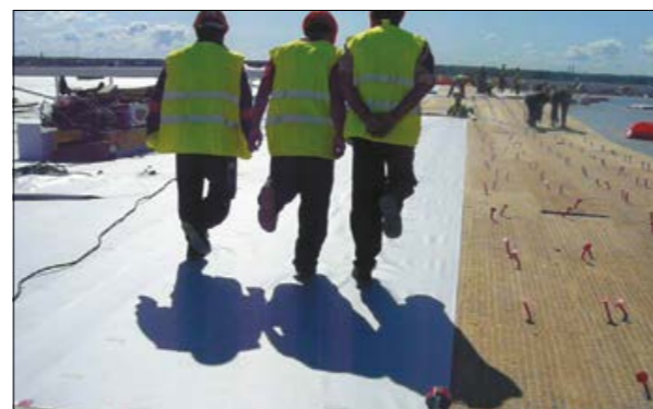
Рис. 5.4.3 Натягивание рулона
