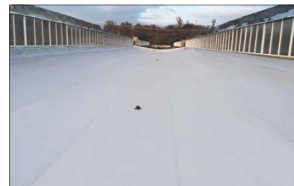
Рис. 2.10.4 а, б Вид кровли после реконструкции полимерными мембранами с доутеплением
