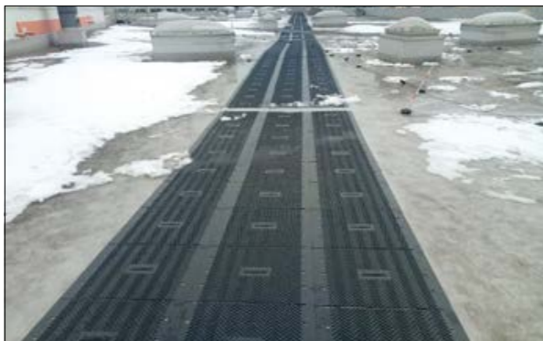
Рис. 4.8.17 Широкая пешеходная дорожка с укладкой плит LOGICROOF Walkway Puzzle в несколько рядов
