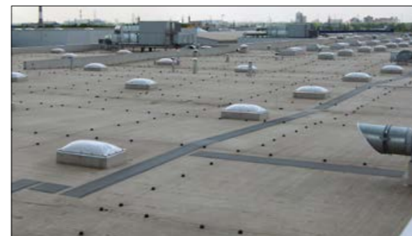
Рис. 3.6.4 Вид кровли с применением пешеходной дорожки ТЕХНОНИКОЛЬ
