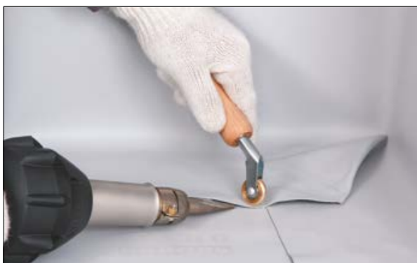
13. Особенно тщательно приварите границу стыков и начало сварного шва между нахлестом и основным кровельным ковром.
