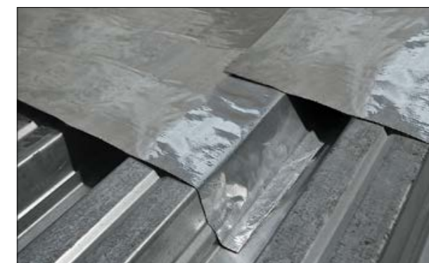
Рис. 3.1.12 Формирование продольного нахлеста пароизоляции на профлисте
