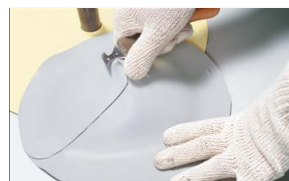
23. Сделайте надрез кровельным ножом на вершине конуса.
