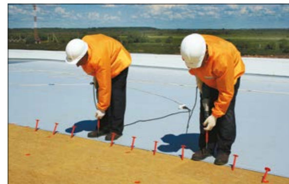
Рис. 5.4.4 Механическое крепление мембраны
