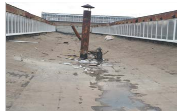
Рис. 2.10.3 а, б Старая битумная кровля
