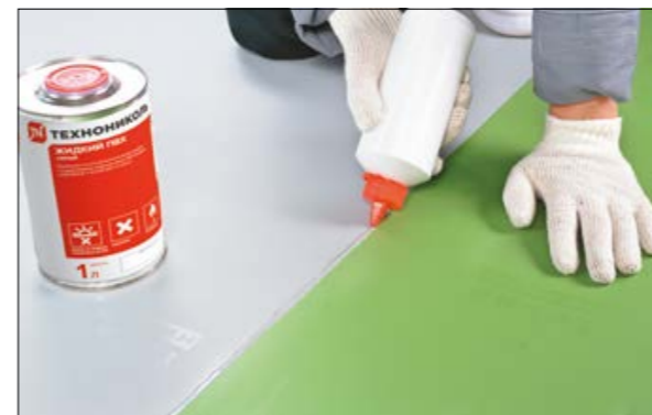
Рис. 3.4.2 Обработка стыка жидким ПВХ
