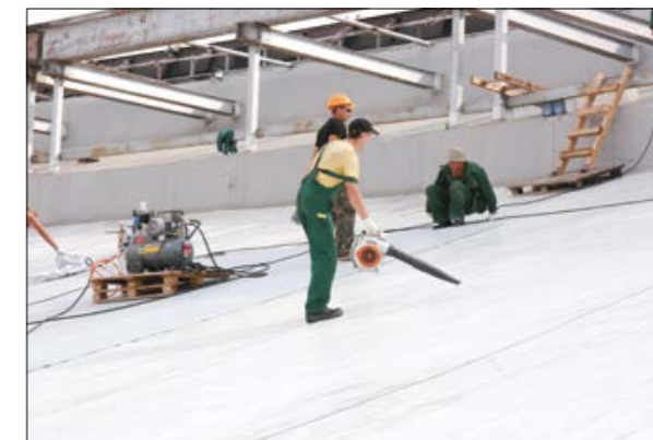
Рис. 2.9.5 – Рис. 2.9.6 Подготовьте старое основание: очистите, обеспыльте, просушите
