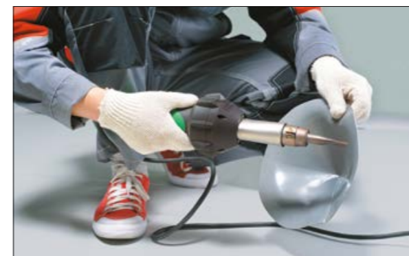
21. Затем прогревайте небольшой участок нижней части заготовки, двигая соплом фена вдоль него, до тех пока мембрана не станет пластичной.
