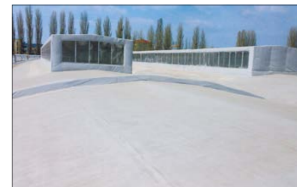
Рис. 2.10.4 а, б Вид кровли после реконструкции полимерными мембранами с доутеплением
