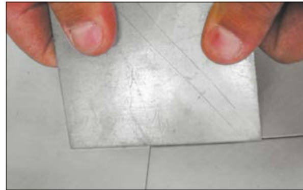
Рис. 5.2.15 Фиксация Т-образного шва металлической пластиной
