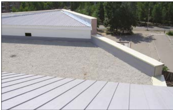
Рис. 2.7.1 Вид балластной кровли
