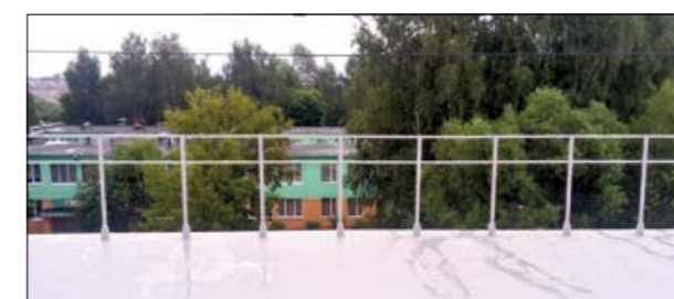
Рис. 4.8.20 Смонтированное кровельное ограждение ТЕХНОНИКОЛЬ
