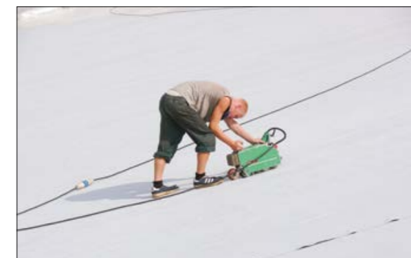
Рис. 2.9.8 После приклейки к основанию — мембрана сваривается обычным образом
