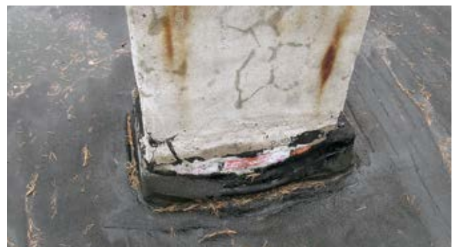
Рис. 4.10. Сползание кровельного материала с вертикальной поверхности
