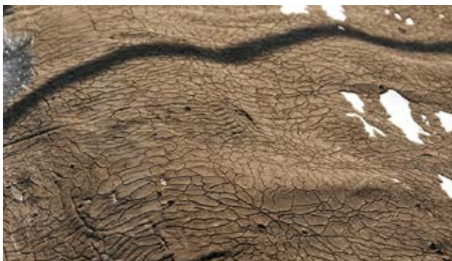
Рис. 4.8. Растрескивание кровли
