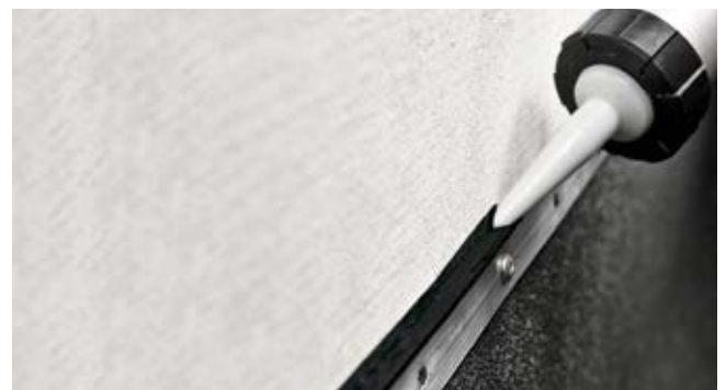
Рис. 7.24. Герметизация края краевой рейки
