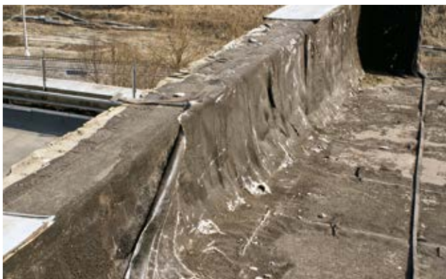
Рис. 4.13. Отсутствие элементов из оцинкованной стали
