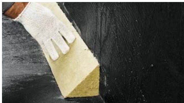
Рис. 7.13. Устройство наклонного бортика
