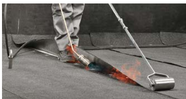
Рис. 7.48. Сварка шва с использованием газовой горелки
