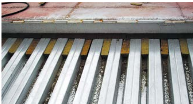
Рис. 7.1. Заполнение пустот ребер профнастила минераловатым утеплителем в местах примыкания.
