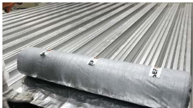
Рис. 7.5. Укладка пароизоляционного материала по профлисту
