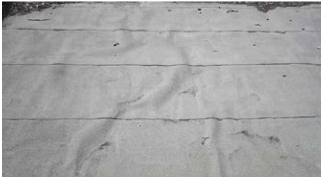
Рис. 4.7. Вздутия кровли
