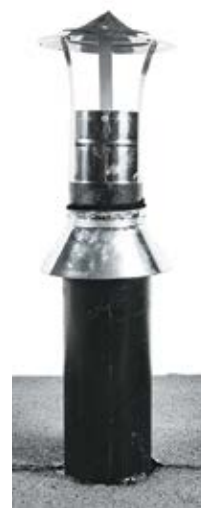
Рис. 7.34. Устройство защитного фартука на трубе
