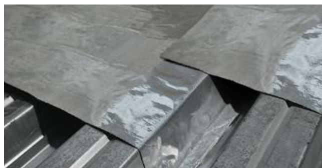
Рис. 7.6. Формирование продольного нахлеста пароизоляции на профлисте
