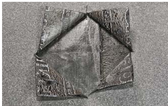
Рис. 8.2 Устранение вздутия водоизоляционного ковра
