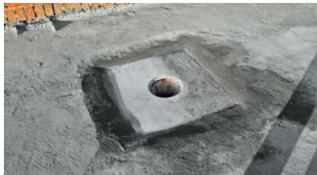
Рис. 7.12. Локальное понижение в месте установки воронки
