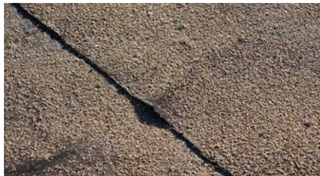
Рис. 4.5. Расслоение полотнищ материала
