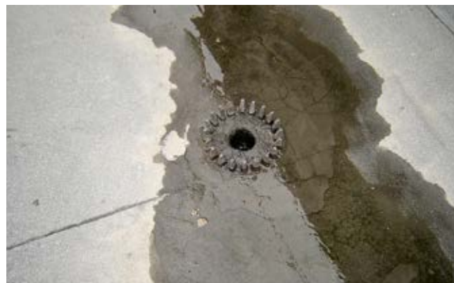
Рис. 4.15. Образование застойных зон
