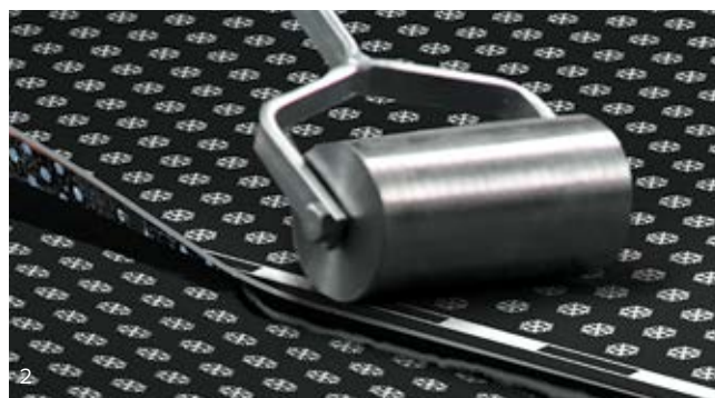
Рис. Д.1. 1 – Сварка бокового шва; 2 – Прикатка бокового шва
