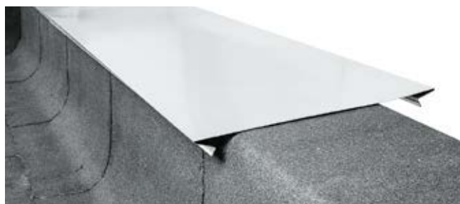
Рис. 7.29. Установка парапетной крышки
