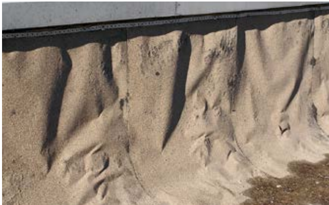
Рис. 4.12. Отслоение верхней кромки кровельного материала
