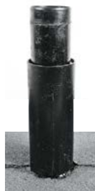
Рис. 7.33. Примыкание кровли к трубе
