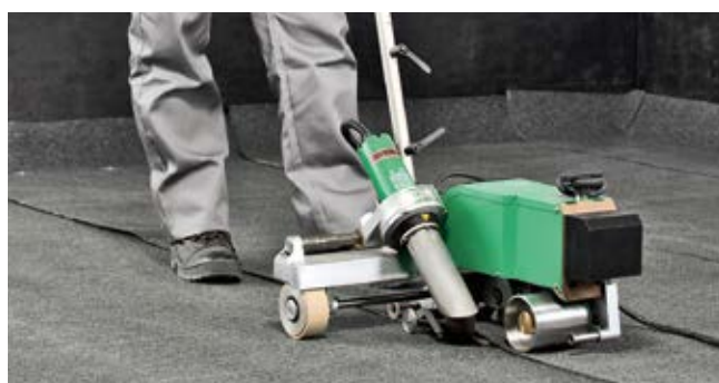
Рис. 7.47. Сварка шва автоматическим оборудованием
