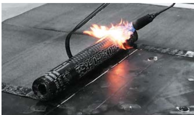
Рис. Д.1. Наплавление по теплоизоляционным плитам
