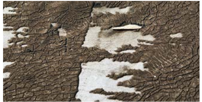
Рис. 4.9. Разрушение верхнего покровного слоя материала до основы
