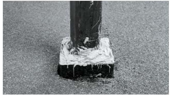
Рис. 7.37. Примыкание кровли к трубам малого диаметра
