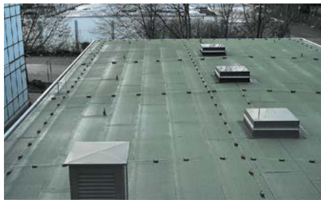
Рис. 7.56. Устройство молниеприемной сетки на кровле
