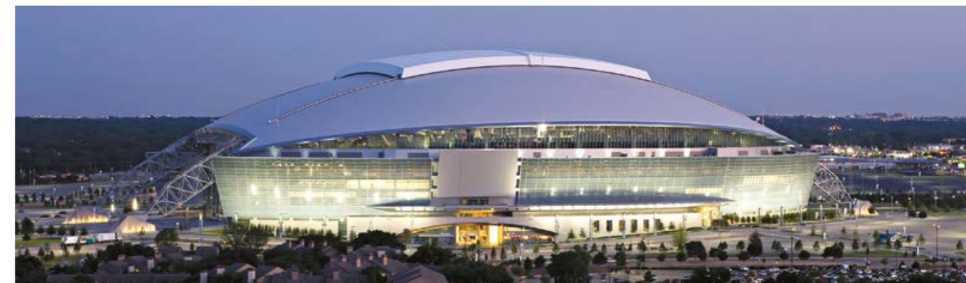
Cowboys Stadium Arlington, Texas, площадь кровли 55 800 м 2
