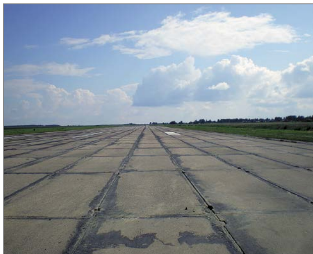
Герметизация деформационных швов аэродромных покрытий
