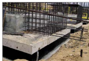
Гидроизоляция фундаментов
