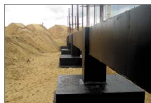
Гидроизоляция сваи
