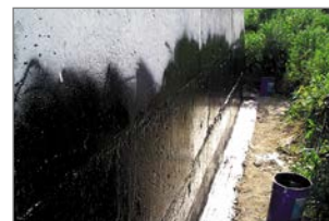
Гидроизоляция методом напыления
