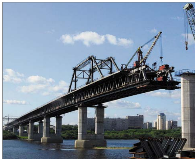
Гидроизоляция мостовых сооружений. Метромост, Н. Новгород
