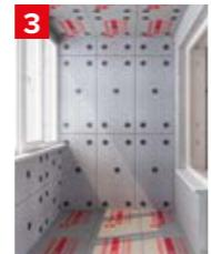
Через 24 часа после приклеивания плит теплоизоляции на стену и потолок необходимо дополнительно провести крепление плит фасадными дюбелями. Проверьте, чтобы их было не меньше 4 шт на одну полную плиту теплоизоляции.
