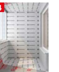
После того, как швы запенены, а излишки клей-пены удалены, необходимо смонтировать герметичный пароизоляционный слой. Швы пароизоляционной пленки должны быть проклеены с помощью специальной двухсторонней клейкой ленты.
