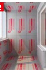
Перед приклеиванием гладких плит экструзионного пенополистирола на стены необходимо равномерно отфрезеровать их с помощью ножовки или металлической щетки.
