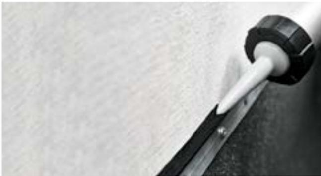
Рис. 3.9. Герметизация края краевой рейки
