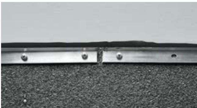
Рис. 3.6. Зазор между краевыми рейками
