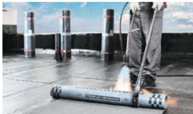
**5.1.3.** Нагрев производят плавными движениями горелки так, чтобы обеспечивался равномерный нагрев материала и поверхности основания. Хорошей практикой является движение горелки буквой «Г» с дополнительным нагревом той области материала, которая идет внахлест.
