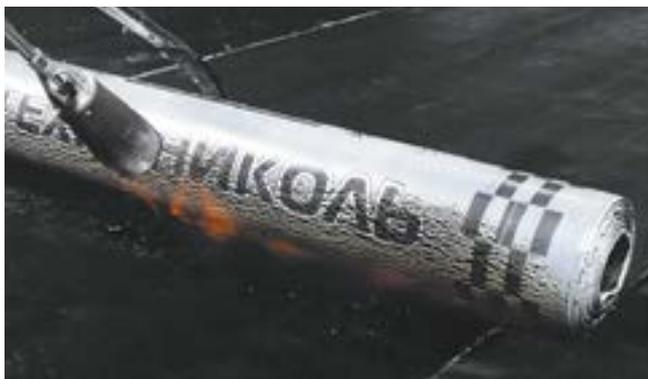
**5.1.6.** Признаком качественного наплавления материала является вытекание битумного или битумно-полимерного вяжущего из-под боковой кромки материала примерно на 10–25 мм.
