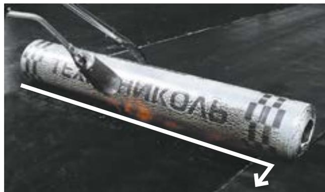
**5.1.4.** На битумных и битумно-полимерных материалах с нижней стороны используется индикаторная пленка с рисунком. Деформация рисунка при воздействии пламени горелки свидетельствует о правильном разогреве битумного (битумно-полимерного) вяжущего с нижней стороны рулонного материала.
