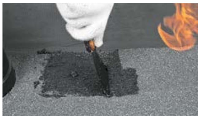
**5.1.11.** При выполнении боковых швов на коньке, в местах где материал наплавляется на слой с защитной посыпкой, подготовка участка шва перед наплавлением аналогична подготовке торцевого шва.
