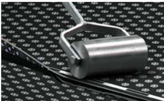
Рис. 5.3. 1 – Сварка бокового шва; 2 – Прикатка бокового шва
