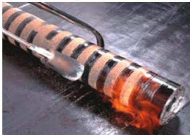
**5.1.8.** Приемы наплавления верхнего слоя аналогичны приемам наплавления материала нижнего слоя.
