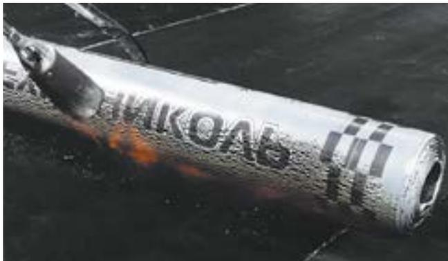
**5.1.5.** Для качественного наплавления материала на основание необходимо добиться небольшого валика битумного вяжущего в месте соприкосновения материала с поверхностью.
