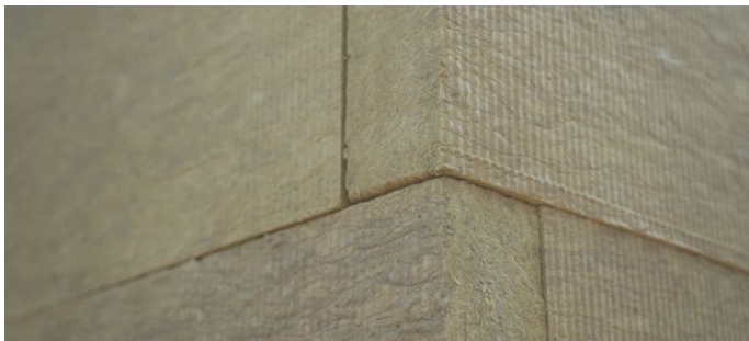
Рис. 30. Зубчатая перевязка плит
