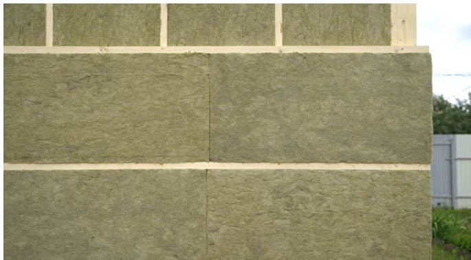
Рис. 4. Монтаж теплоизоляционных плит в горизонтальный каркас
