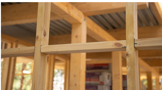
Рис. 18. Установка деревянного каркаса
