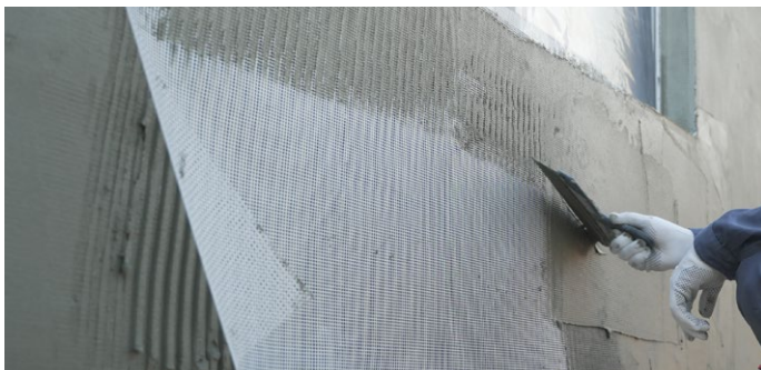
Рис. 37. Армирование базового штукатурного слоя стеклосеткой
