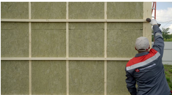
Рис. 3. Установка горизонтального каркаса
