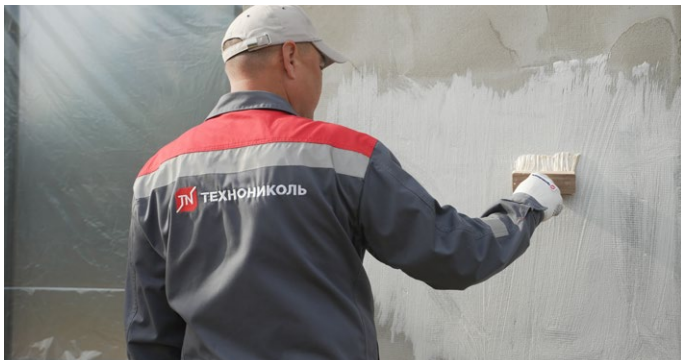
Рис. 38. Нанесение кварцевой грунтовки на поверхность базового штукатурного слоя
