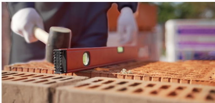
Рис. 10. Монтаж внутренней версты
