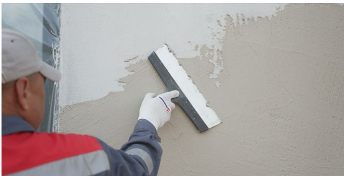
Рис. 39. Нанесение декоративного слоя штукатурки
