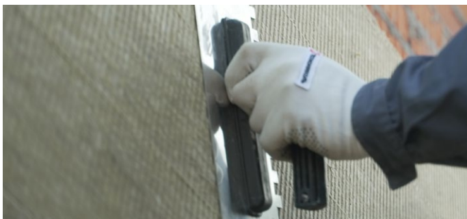
Рис. 32. Шлифовка стыков плит теплоизоляции
