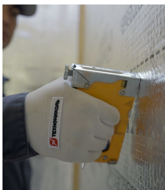
Рис. 19. Монтаж пароизоляционной пленки
