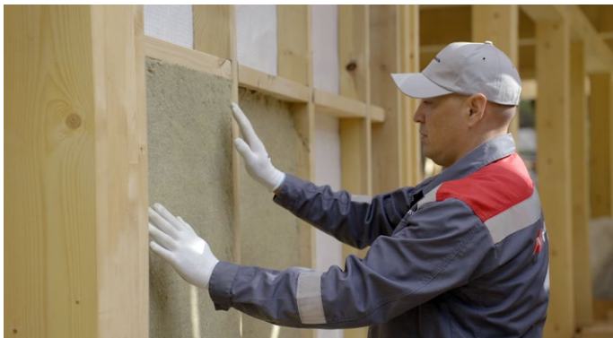
Рис. 20. Монтаж теплоизоляционных плит
