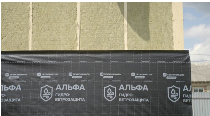
Рис. 5 а. Монтаж ветро-, влагозащитной мембраны
