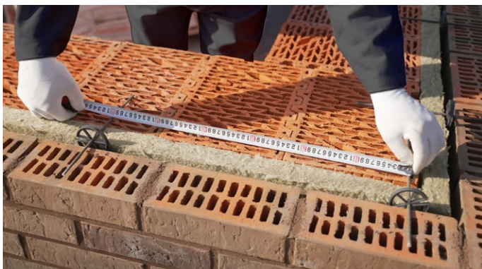
Рис. 13. Установка гибких связей
