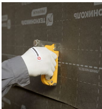
Рис. 21. Монтаж ветро-, влагозащитной мембраны
