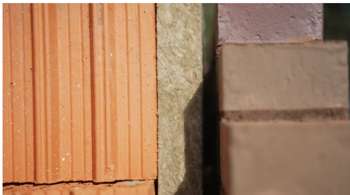
Рис. 11. Монтаж плит теплоизоляции
