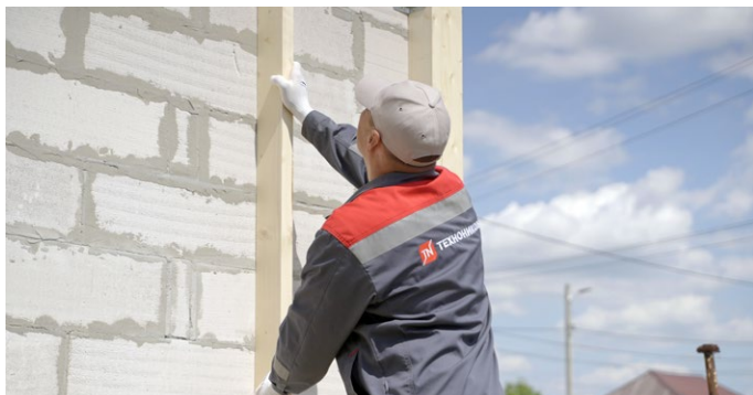
Рис. 1. Крепление вертикальных стоек деревянного каркаса
