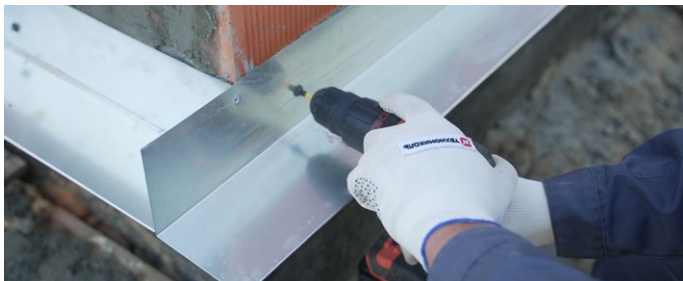
Рис. 25. Установка стартового профиля
