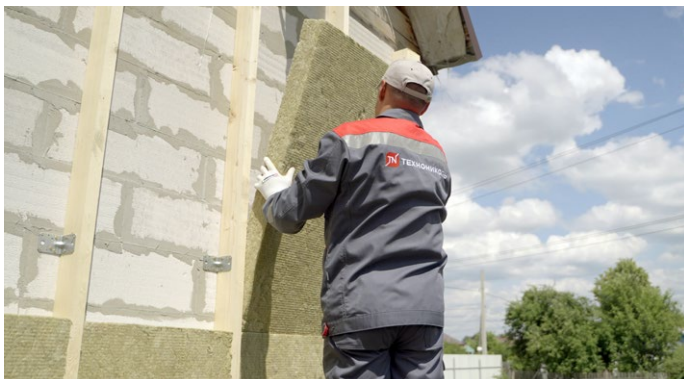
Рис. 2. Монтаж теплоизоляционных плит в вертикальный каркас
