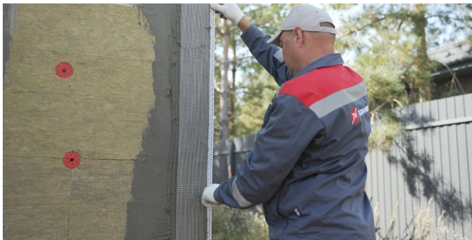
Рис. 35. Установка усиливающих профилей на углах здания
