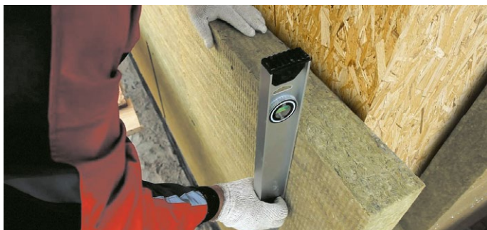
Рис. 29. Приклейка плиты тепло-, звукоизоляции к стене
