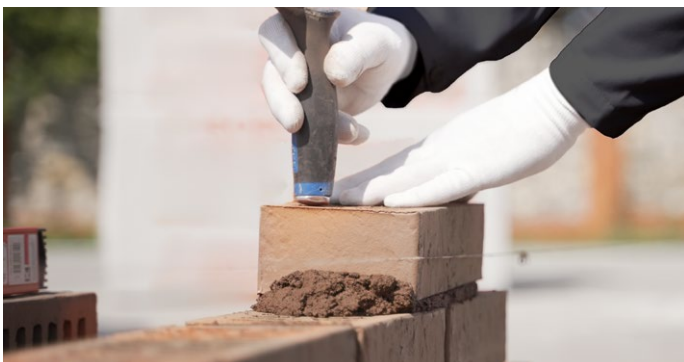
Рис. 9. Монтаж внешней версты
