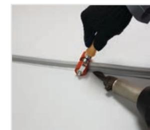
6. Производим окончательную сварку.
