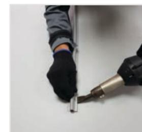
3. Выставляем А-профиль по ранее размеченным меткам, производим точечные прихватки одной из сторон с целью избежание сдвига А-профиля в момент сварки (на фото прихватываем правую часть).
