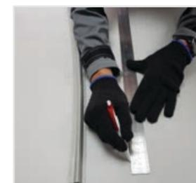
2. Производим предварительную разметку для последующего монтажа А-профиля.
