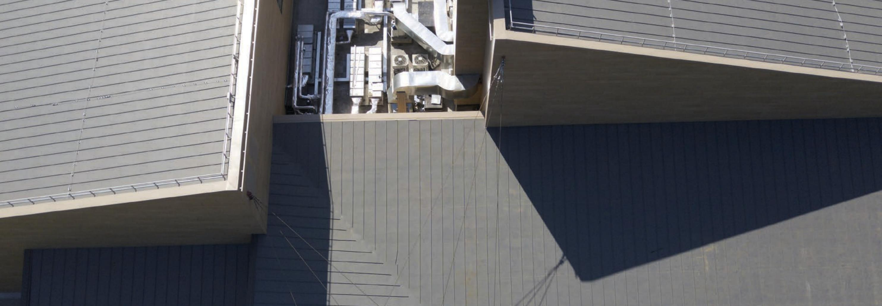
Полимерная мембрана с А-профилем используется в качестве имитации классической фальцевой кровли. Такое решение позволяет сократить риск попадания влаги снаружи (например, в случае сильного дождя) до минимума, защитить кровлю на долгие годы и сэкономить средства.
