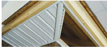
**2.2.2** Установка H-профиля, предназначенного для соединения панелей в угловых зонах. Панели в данном случае подрезаем с учетом этого угла «елочкой». Фиксируем саморезами к обрешетке и стыкуем.
