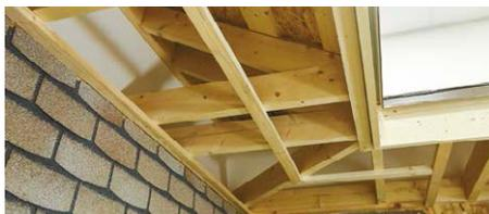
**1.1.2** На соединяющие бруски смонтировать обрешетку. В качестве обрешетки нужно использовать такие же бруски по сечению, как и тот брусок, который смонтирован к фасаду. По краям свеса монтируется направляющий профиль (J-профиль).
