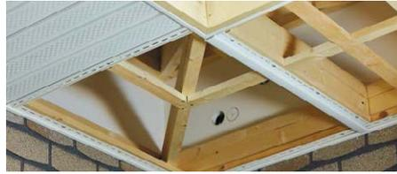
**2.2.3** Прямое соединение выполняется с помощью H-профиля. Его монтируем от внутреннего угла перпендикулярно одному из свесов карниза.
