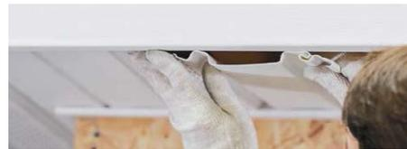
**3.3** Далее производится установка панелей софитов, которые должны быть подрезаны таким образом, чтобы их ширина была примерно на 1 см меньше, чем расстояние между внешними краями J-профиля и J-фаски.
