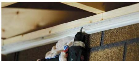
**1.1.3** К обрешетке и брускам фиксируются направляющие профили (J-профиль) саморезами с шагом 300 мм. В месте соединения профилей подрезать одну из частей профиля на 3–5 см таким образом, чтобы можно было завести один профиль в другой для лучшего сопряжения.
