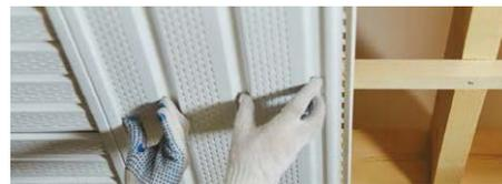
**2.2.5** Далее производится установка панелей софитов, которые должны быть подрезаны таким образом, чтобы их ширина была примерно на 1 см меньше, чем расстояние между внешними краями J-профилей.
