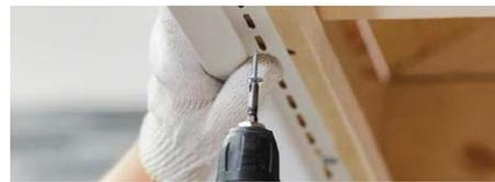
**3.2** После монтажа финишного профиля монтируется J-фаска. Она должна быть подрезана по высоте лобовой доски. Затем в ее верхней части необходимо сделать засечки для фиксации в финишном профиле. После этого J-фаска фиксируется саморезами к нижней части лобовой доски. В случае оформления лобовой доски при помощи J-фаски, J-профиль устанавливается только со стороны фасада.
