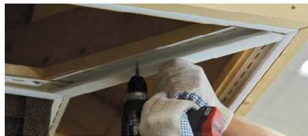
**2.2.1** Для углового соединения панелей используется H-профиль.
