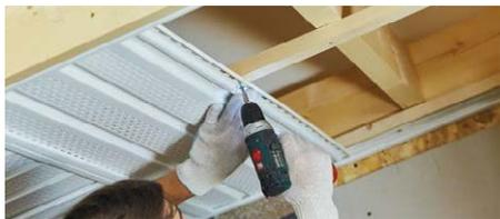
**1.1.4** В направляющие профили вставляются панели и фиксируются при помощи саморезов к обрешетке. Количество саморезов зависит от ширины свеса.
