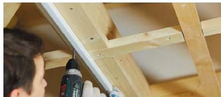
**2.2.4** Второй вариант прямого соединения – при помощи J-профиля. Его устанавливаем от угла перпендикулярно одному из свесов карниза. Фиксируем саморезами к обрешетке и стыкуем друг с другом.
