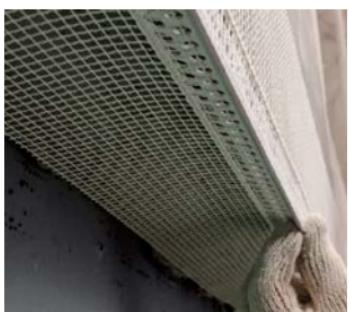
При применении композиции снаружи зданий и сооружений необходимо защитить плиты из каменной ваты «Плита ТЕХНО ОЗМ» от воздействия атмосферных осадков. В качестве декоративно-защитного слоя может быть применено покрытие из минеральной штукатурки (по стеклосетке) или обшивка плитами ГКЛ,
