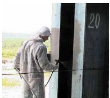
Стальная поверхность должна быть сухой и очищенной от загрязнений, масла и других компонентов, препятствующих плотному прилеганию огнезащитной плиты и адгезии клеевого состава. При необходимости поверхность требуется обезжирить спиртом или другим растворителем и огрунтовать анткоррозийным грунтом. Грунт наносится ручным или механическим способом.
