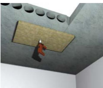
Плита из каменной ваты ТЕХНО ОЗБ прикладывается к защищаемой железобетонной поверхности. При помощи перфоратора проделываются отверстия в основании сквозь плиты ТЕХНО ОЗБ. Диаметр отверстий 8 мм, а глубина — 40–50 мм.
