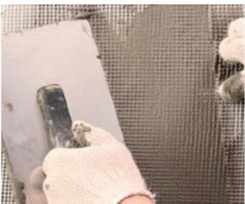
На свежий kleевой раствор нужно приложить подготовленный отрезок сетки, прижимая ее в нескольких местах к kleю краем терки или пальцами. Гладкой стороной терки необходимо утопить сетку в kleевом растворе. Полотна стеклосетки соединяются внахлест 100 мм.
