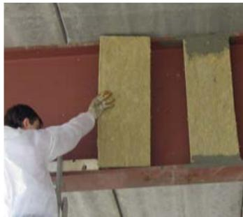
Для монтажа огнезащитной композиции на металлоконструкции сложной геометрической конструкции необходимо подготовить вставки из минеральной ваты размером не менее 100 мм по ширине и 30 мм по толщине. Вставки устанавливаются таким образом, чтобыстыки основных плит приходились на вставки,
