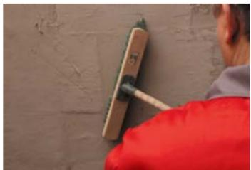
Рекомендуется очистить поверхность железобетонной плиты от загрязнений и прочих неровностей, мешающих плотному прилеганию плиты ТЕХНО ОЗБ 80 или плиты ТЕХНО ОЗБ 110 к плоскости перекрытия.
