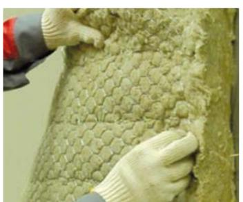
На приваренные штифты навешиваются заранее раскроенные маты таким образом, чтобы не погнуть штифты. Мат навешивается таким образом, чтобы траверса воздуховода находилась под ним, а фланцевые соединения воздуховодов были укрыты матом.
