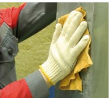
Корпус воздуховода должен быть изготовлен из стали толщиной не менее 0,8 мм, иметь правильные геометрические размеры и иметь надежное крепление к несущим элементам здания или сооружения. Фланцевые соединения необходимо уплотнить негорючим материалом (жаростойкий герметик, базальтовая лента,
