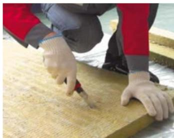
При помощи рулетки необходимо произвести замеры стальной конструкции и раскроить плиты ножом либо на циркулярной пиле отрезными или алмазными кругами (без зубьев).
