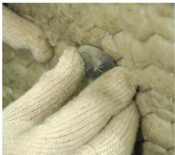
После того как маты навешены, они фиксируются шайбами. Острые концы шпилек обрезаются кусачками, оставляя запас в 2-3 мм для фиксации шайбы. Или на них надеваются защитные колпачки. Шайбы укрываются куском минераловатного мата и фиксируются при помощи алюминиевого скотча.
