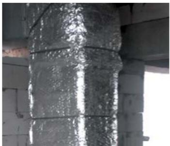
Для крепления огнезащитного покрытия также могут использоваться бандажи. В качестве бандажа может быть применена металлическая оцинкованная или гальванизированная лента толщиной не менее 0,8 мм и шириной 15–20 мм (ГОСТ 3560) или проволока диаметром 1–2 мм.
