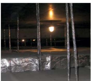
Огнезащита осуществляется тем же материалом, что и поверхность воздуховодов. Подвески не требуют каких-либо приспособлений для крепления огнезащитного покрытия. Предварительно нарезанные куски мата должны обматываться вокруг подвеса и закрепляться с помощью проволоки.
