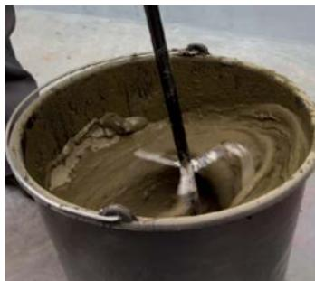
Заворить kleевую смесь водой в соответствии с рекомендациями производителя. Перед нанесением клей следует тщательно перемешивать до однородной массы в течение 2–3 минут. Температура применения клея должна быть выше + 5 °C. Время высыхания клея в зависимости от температуры воздуха и уровня влажности может составлять от 3 до 12 часов.
