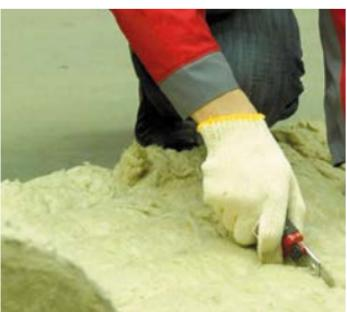
Резку мата рекомендуется осуществлять при помощи ножа и ножниц по металлу. Маты должны быть нарезаны таким образом, чтобы при монтаже они целиком закрывали воздуховод по внешнему периметру. Для воздуховодов с пределом огнестойкости EI 150 и более маты устанавливаются с нахлестом минимум 100 мм.
