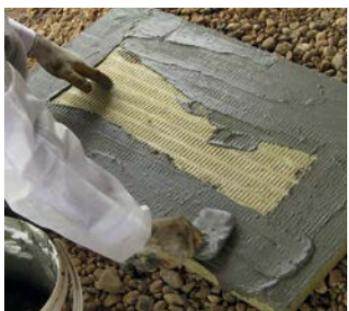
После высыхания клея между вставками из минеральной ваты и металлом к ним крепится основной слой огнезащитного покрытия с помощью клеевой смеси и гвоздей. Клей наносится на плиту при помощи шпателя в местах, где будет происходить контакт плиты с поверхностью металлоконструкции,
