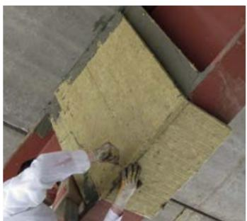
Плиты дополнительно фиксируются гвоздями для предотвращения сползания плиты во время высыхания клея. Длина гвоздя должна быть в два раза больше толщины применяемого материала. Гвозди устанавливаются с шагом 200 мм, но не менее 3 шт. на вставку. После полного высыхания клея
