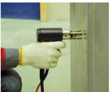
При помощи аппарата контактной или импульсной конденсаторной сварки штифты привариваются к воздуховоду. Точки приварки штифтов намечаются исходя из конструктивных особенностей воздуховода (размер, конфигурация сечения и т.д.). При размещении приварных штифтов на стенках воздухо-
