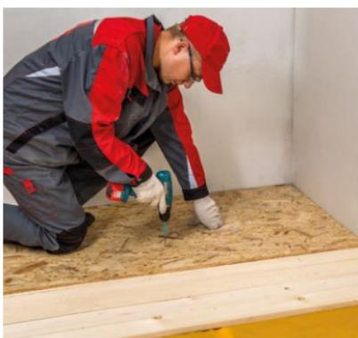
Рис. 4. Монтаж чернового пола
