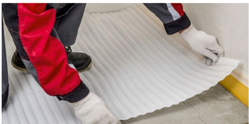
Рис. 12. Укладка подложки под финишное покрытие пола
