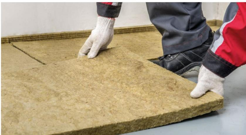
Рис. 7. Укладка плит ТЕХНОФЛОР СТАНДАРТ
