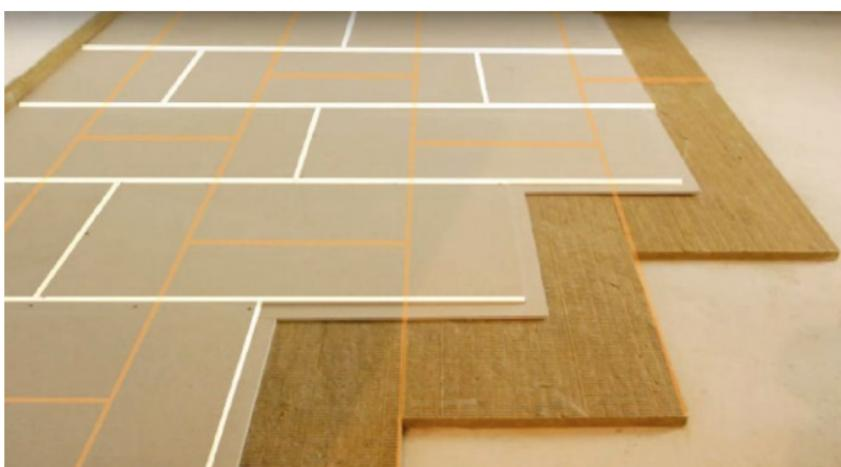
Рис. 10. Разбежка швов сухой стяжки и звукоизоляционных плит
