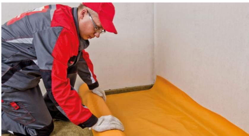
Рис. 8. Укладка гидроизоляции
