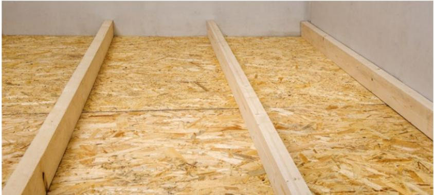
Рис. 1. Подшивка лаг снизу
