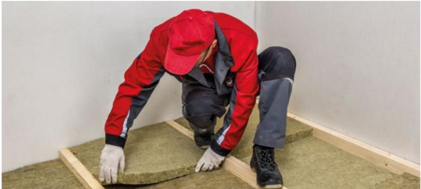
Рис. 2. Монтаж теплоизоляции враспор между лагами
