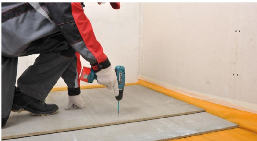
Рис. 9. Устройство сборной стяжки
