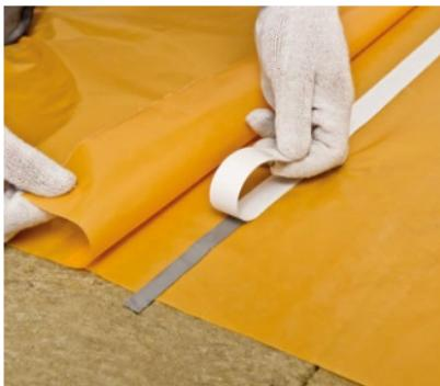
Рис. 3. Монтаж и проклейка нахлестов пароизоляционной пленки
