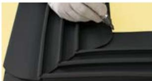
Снимите фаску по краю гидрошпонки от поставленной отметки до торца среза шпонки.
