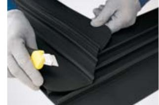
Разметьте, а затем подрежьте ребра гидрошпонки под углом 45°.
