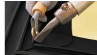
После того как плоские части гидрошпонок сварены между собой и приварены к гидроизоляционной мембране, выполните сварку ребер гидрошпонок.
