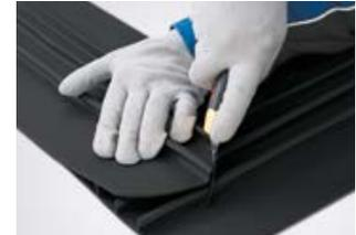
**ВАЖНО!** Не разрезайте плоскую часть гидрошпонки, а только ее ребра.
