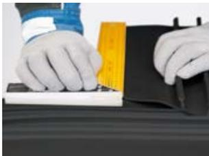
**ВАЖНО!** Между заготовками должен быть угол  $90^\circ$ .
