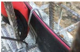
Рекомендуемый шаг установки крепежных элементов 25-30 см.
