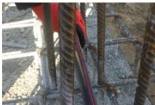
Установите крепежный элемент поставляемый в комплекте и закрепите его с помощью вязальной проволоки и крючка для вязки арматуры.
