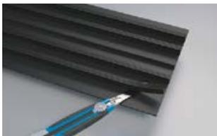
На одной из соединяемых шпонок срежьте анкерные ребра на длину не менее **6–8 см**.
