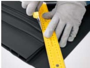
Подрежьте вначале только ребра гидрошпонки, а для резки плоской части уложите шпонку на ровную и прочную поверхность.
