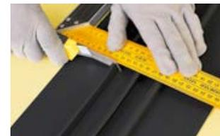
В месте каждого реза сформируйте «галочки» по ширине, равной высоте ребра гидрошпонки.
