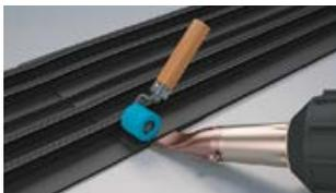
Ведите фен поперек гидрошпонки вдоль сварного шва.
