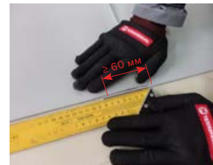
Рисунок 5.11. Варианты раскладка рулонов полимерных мембран
