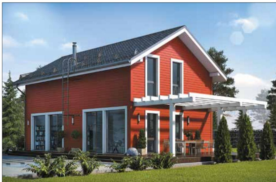
плоизоляции»: стены — с 25-сантиметровым слоем каменной ваты, а кровля — с 30-сантиметровым. Роли материалов здесь максимально распределены: деревянный каркас обеспечивает механическую устойчивость, а негорючая каменная вата, которая в пять раз эффективнее дерева сохраняет тепло и при этом во столько же раз дешевле дерева, создает комфортный микроклимат.
