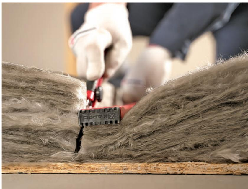
**2.2** Нарезку рулона осуществляем ножом для минеральной изоляции на жестком основании.
