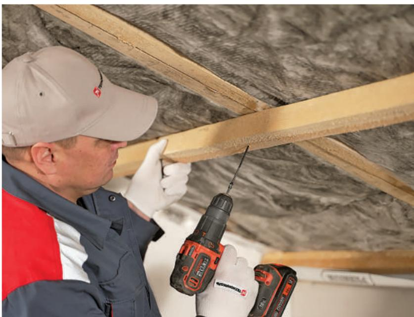
**3.1** В случае применения двухслойной схемы утепления необходимо обеспечить смещение стыков между нарезанными плитами на 50% от их общей длины.
