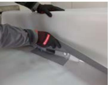
**5.4.15.** После чего, осуществить его подрезку и последующую сварку на горизонтальной части фланца с шириной сварного шва не менее 30 мм.
