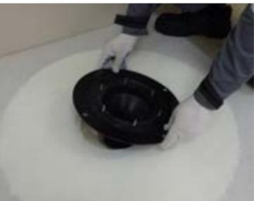
**ВАЖНО!** Надставной элемент необходимо устанавливать строго вертикально оси нижней воронки, в противном случае уплотнительное кольцо не сможет обеспечить полную герметичность соединения и приведет к попаданию воды с кровли внутрь кровельного пирога.
