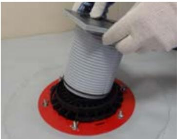
Данное решение позволяет эффективно отводить воду с балластных и инверсионных кровель, так как в данном случае основная часть воды с данного типа кровли отводиться с гидроизоляционного слоя в водосточную систему через дренажное кольцо, оставшаяся часть попадает в водосточную систему непосредственно с финишного слоя в виде балласта, который может быть представлен как гравийной засыпкой, так и декоративным слоем из террасной доски и пр.
