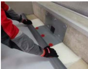
**5.4.11.** Осуществить его механическую фиксацию в зоне перехода с горизонта на вертикаль с помощью прижимных реек.
