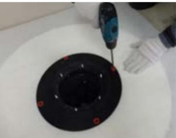
**5.2.15.** Для механического крепления рекомендуется использовать телескопический крепеж с уменьшенным диаметром фланца и кровельные саморезы.
