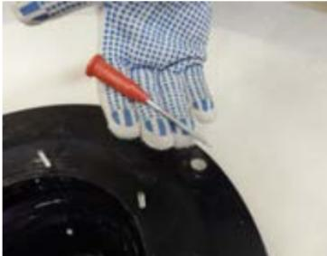
\* При необходимости крепление можно осуществить с использованием стандартного телескопического крепежа и кровельных саморезов.
