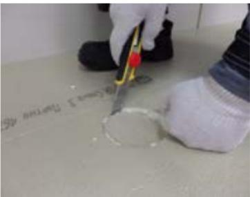
**ВАЖНО!** в случае использования в качестве основного теплоизоляционного слоя минераловатной теплоизоляции, для снижения рисков образования застойных зон в области устройства воронки на участке не менее 1000x1000 мм в качестве основания под установку рекомендуется использовать плиты из полимерного теплоизоляционного материала (PIR, XPS), которые имеют необходимые высокие прочностные характеристики и низкое влагопоглощение.
