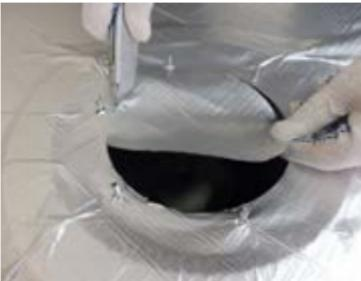
**ВАЖНО!** Для увеличения герметичности соединения рекомендуется предварительно нанести ПУ-герметик на фланец.
