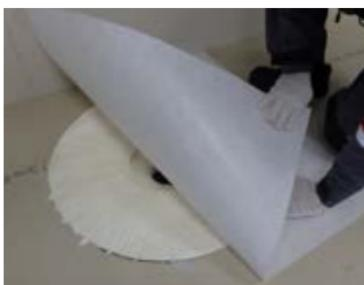
**5.2.12.** В разделительном слое произвести вырез отверстия, соответствующий посадочному диаметру надставного элемента.
