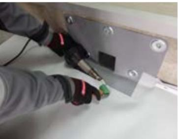
**5.4.14.** Далее, произвести устройство усиливающего слоя водоизоляционного ковра на парапетной части.
