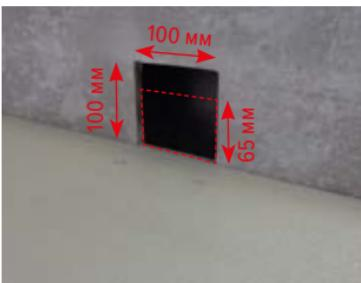
**5.4.2.** В теплоизоляционном слое требуется формировать местное водопонижение.
