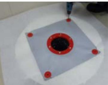
**5.2.20.** После монтажа основного гидроизоляционного слоя поверх фланца усиления, произвести разметку отверстия диаметром 300 мм. Для удобства разметки можно использовать хлястик мембранны длиной 150 мм.
