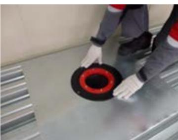
**5.2.2.** Произвести механическую фиксацию чаши воронки к несущему основанию (фартуку усиления) с помощью кровельных саморезов.
