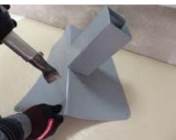
**5.4.8.** Далее, произвести механическое крепление горизонтальной и вертикальной части фланца.
