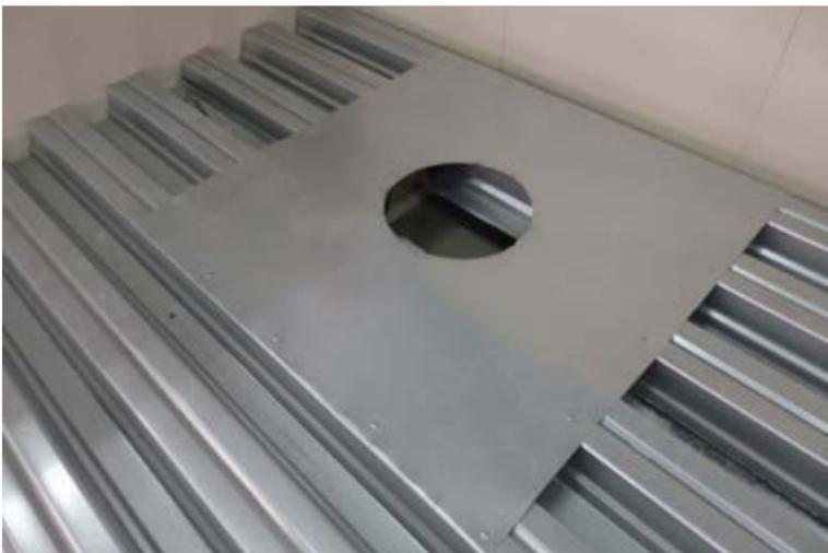
В случае устройства двухуровневой водосточной воронки, посадочный диаметр нижнего яруса воронки для установки в несущее основание составляет 280 мм, при устройстве одноровневой воронки – 110 мм.
