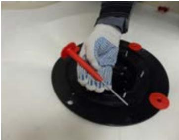
**5.2.16.** После механического крепления надставного элемента в основание нужно произвести устройство готового фартука из полимерной -мембранны размером не менее 500x500 мм.
