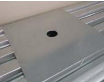
**5.3.2.** В случае использования пароизоляционной пленки для обеспечения герметичности необходимо осуществить её дополнительную приклейку к основанию (фартуку усиления) в области установки воронки с помощью двустороннего скотча с последующим прорезанием отверстия диаметром на 10 мм меньше диаметра отвода водосточной воронки.
