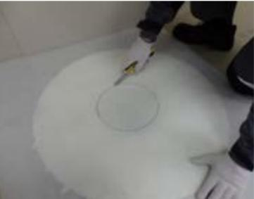
**5.2.13.** Установить надставной элемент. При этом, необходимо, чтобы фланец надставного элемента плотно прилегал к поверхности теплоизоляционного слоя без образования зазоров.
