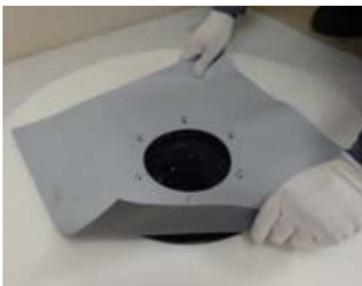
**ВАЖНО!** В случае необходимости аналогичный фартук можно изготовить самостоятельно из армированной полимерной мембранны, например, LOGICROOF V-RP.
