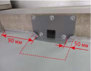
**ВАЖНО!** Нахлест ПВХ-мембранны на горизонтальную часть фланца должен составлять не менее 50 мм, отступ от парапетной части не менее 90 мм.
