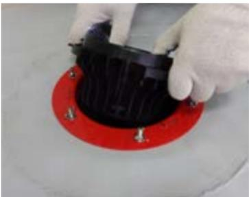
2. Далее, произвести установку трапа для эксплуатирующей кровли на дренажное кольцо
