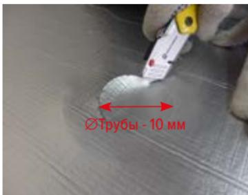
**ВАЖНО!** В случае монтажа одноуровневой водосточной воронки на основание из профилированного настила необходимо произвести заведение пароизоляционного слоя на фартук усиления из оцинкованного металла с вырезанным отверстием, посадочный диаметр отверстия под одноуровневые водосточные воронки Ø 110 мм – 110 мм, водосточные воронки ТЕХНОНИКОЛЬ Ø 160 мм – 160 мм.
