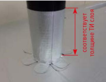
**ВАЖНО!** С целью устройства герметичного примыкания пароизоляционного слоя из пароизоляционной пленки требуется использовать двухсторонний скотч и последующую прилейку к нему дополнительного слоя пароизоляционного материала.
