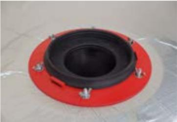
**5.2.7.** После монтажа теплоизоляционного слоя необходимо произвести в нём вырез отверстия под соответствующий диаметр отвода водосточной воронки, который составляет 110 или 160 мм.
