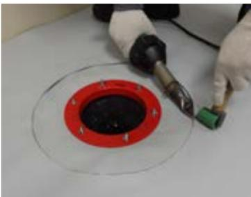
**5.2.22.** Для дополнительной герметизации и исключения капиллярного подсоса влаги рекомендуется сварной шов обработать жидким ПВХ.
