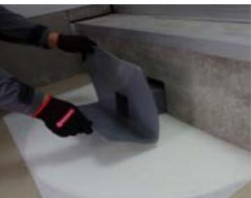
**ВАЖНО!** В случае неплотного прилегания фланцев воронки к горизонтальной или вертикальной части конструкции, необходимо произвести предварительный подогрев угла перехода «горизонталь-вертикаль» фланца парапетной воронки для придания ей необходимой формы.
