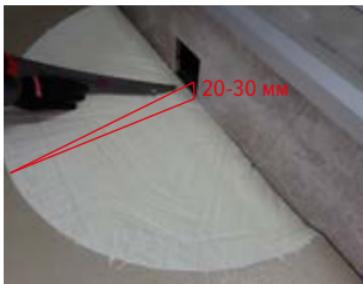
**5.4.5.** Перед установкой парапетной воронки произвести подрезку водоотводящей части до необходимой длины, исходя из толщины парапетной части здания.
