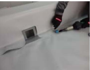
**5.4.16.** Аналогичным образом произвести подрезку усиливающего слоя водоизоляционного ковра и его сварку с горизонтальной и вертикальной частью фланца парапетной воронки.
