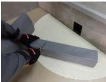
**ВАЖНО!** Воронка имеет в составе короб из оцинкованной стали. Короб необходимо подрезать под требуемую длину аналогично с водоотводящей частью парапетной воронки.
