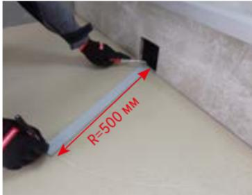
**5.4.4.** После чего сформировать с помощью ножовки или полотна для ножовки по металлу местное водо-понижение с перепадом высот 20-30 мм относительно уровня кровли (уклон до 5%) на расстоянии минимум 500 мм от оси установки воронки.
