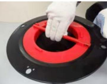
**5.2.18** В случае использования в качестве надставного элемента водосточной воронки с ПВХ фланцем\* требуется осуществить приварку фартука из полимерной мембраны к фланцу водосточной воронки.
