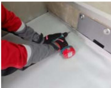
**5.4.12.** Далее, выполнить подрезку водоизоляционного ковра на горизонтальной части фланца парапетной воронки.
