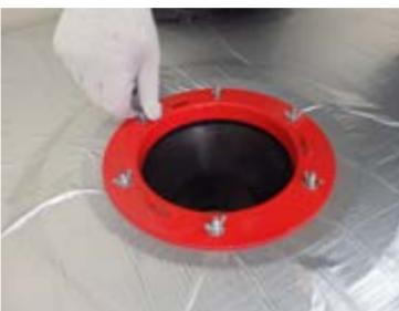
**5.2.5.** В смонтированный фланец установить уплотнительное кольцо для надставного элемента, которое обеспечивает герметичность соединения между собой верхней и нижней воронок.
