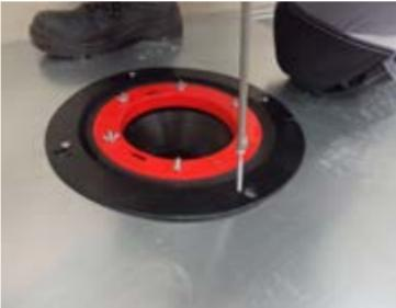
**5.2.3.** Осуществить укладку пароизоляционного слоя в область прижимного фланца воронки с последующей подрезкой отверстия по диаметру водоприемной чаши.
