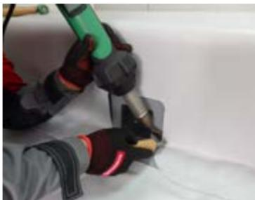
**ВАЖНО!** При вырезании отверстия в водоизоляционном ковре необходимо скруглять углы, чтобы снизить риски непроваров на данных участках.
