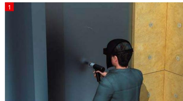
К конструкции палубы или переборки привариваются шпильки диаметром 3 мм и длиной не менее чем на 10 мм больше толщины изоляции. Шпильки устанавливаются по плоскости конструкции между ребер жесткости и по ребру.
