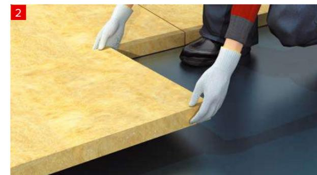
На палубу укладываются плиты ТЕХНО Флор Судовые 140 толщиной 50 мм в один слой. Плиты должны плотно примыкать друг к другу, не допускается образование воздушных зазоров в местах стыков.
