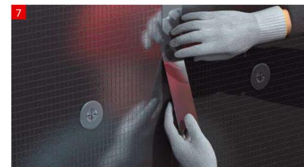
**ВАЖНО!** При применении изоляции с кашировкой стыки необходимо герметизировать при помощи самоклеящейся алюминиевой ленты.
