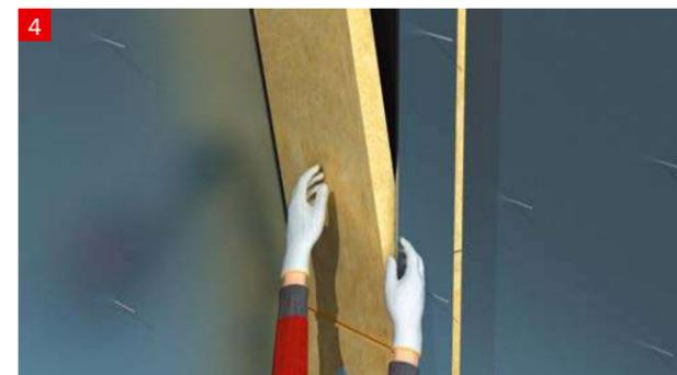
Монтаж следует начинать с изоляции набора (ребер жесткости). Сначала следует плотно заполнить пространство под ребром, затем установить изоляцию необходимой толщины на шпильки по всей длине ребра.
