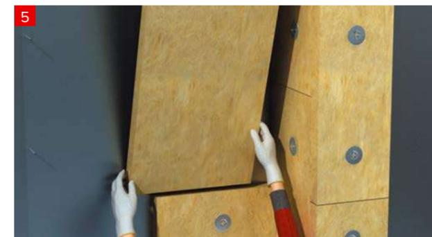
При укладке изоляции между ребрами недопустимо оставлять зазоры. При двухслойной изоляции рекомендуется перекрывать стыки нижнего слоя с разбежкой не менее 150 мм.
