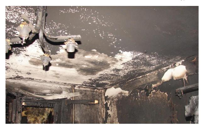
Рисунок 3. Железобетонные конструкции после пожара. Участки выгорания копоти свидетельствуют о нагреве поверхности конструкции выше 600 °C
