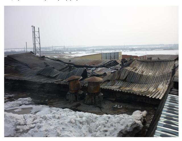
Рисунок 2. Нависание профилированных стальных конструкций над производственно-складскими помещениями после пожара
