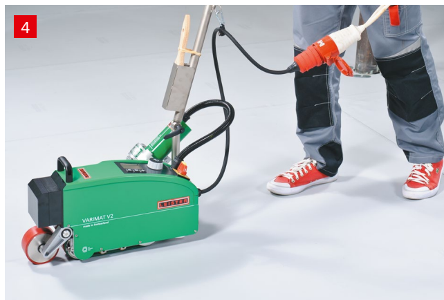
Укладка гидроизоляционного ковра
