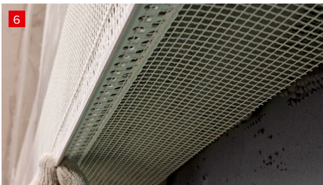
Устройство защитно-декоративного слоя
