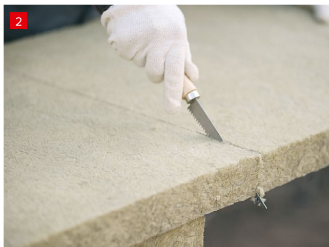
Резка плит ТЕХНО ОЗБ
