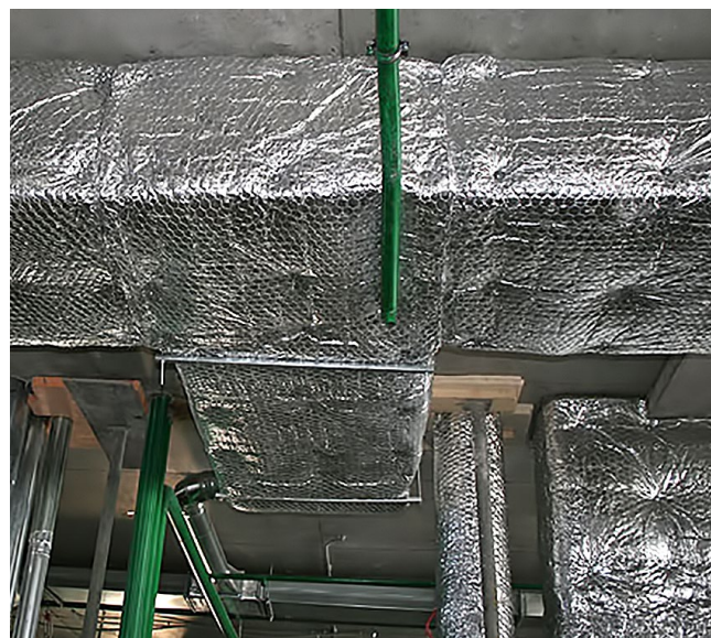
Рис. 4.2. Огнезащита воздуховода
