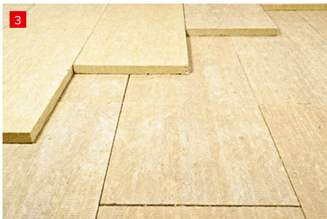
Укладка верхнего теплоизоляционного слоя
