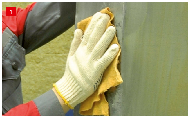
1 Подготовка наружной поверхности воздуховода
