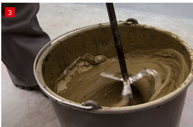
Затворение клеящей смеси
