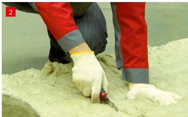
2 Выкройка огнезащитных матов
