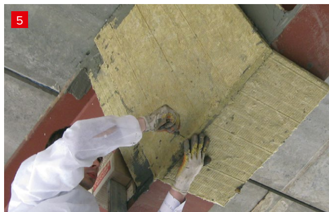
Монтаж огнезащитных плит ТЕХНО ОЗМ
