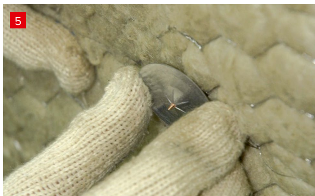
5 Установка прижимных шайб
