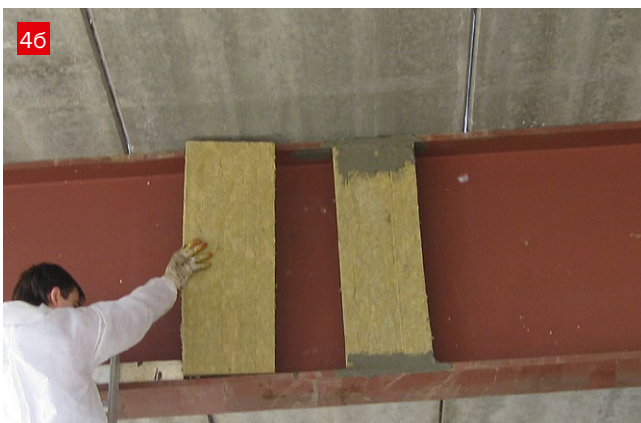
Монтаж дополнительных монтажных элементов (вставок)
