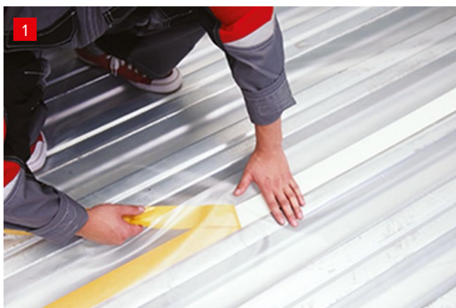
Укладка пароизоляции
