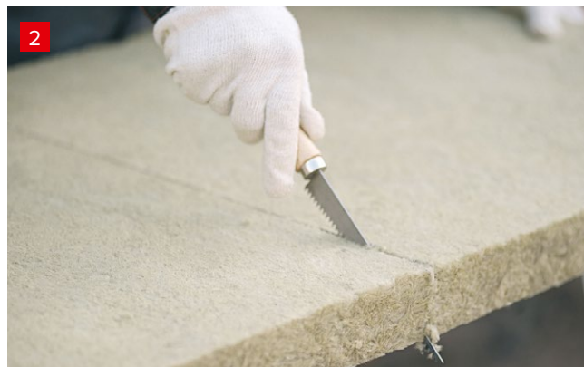
Резка плит ТЕХНО ОЗМ
