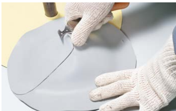
23. Сделайте надрез кровельным ножом на вершине конуса.
