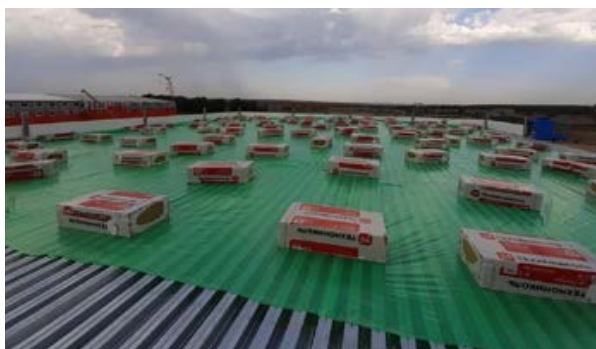
Рис. 3.1.5. Укладка пароизоляционной пленки ТЕХНОНИКОЛЬ.
