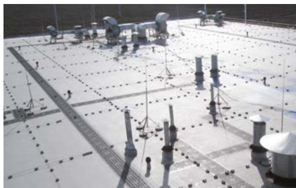
Устройство зоны выхода на кровлю и пешеходных путей от нее с помощью LOGICROOF Walkway Puzzle.
