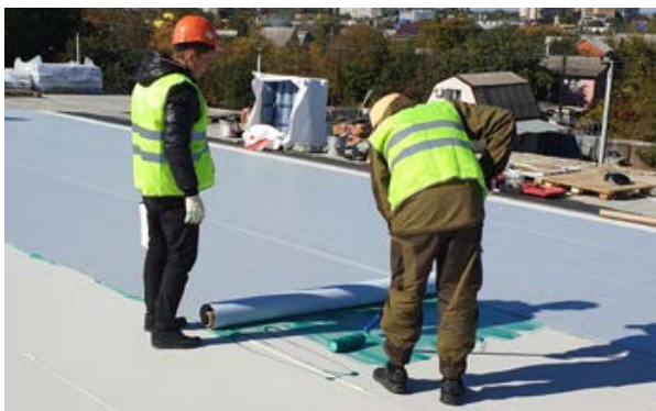
Рис. 2.4.10. Процесс нанесения клея на основание под приклейку ПВХ-мембраны LOGICROOF V-GR FB с флисовой подложкой.
