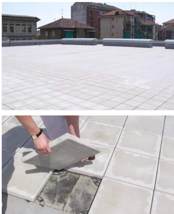
Рис. 2.5.2. Применение в качестве балласта тротуарной плитки.
