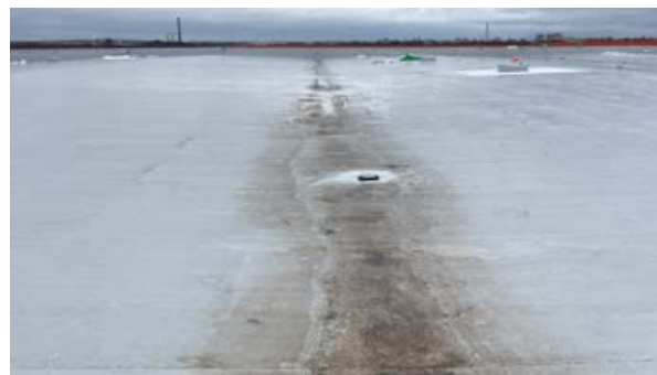
5.4.7. Зоны застоя воды на поверхности ПВХ-мембраны
