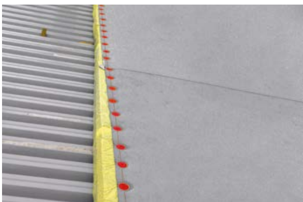
Рис. 3.1.7. Защита теплоизоляции от намокания.
