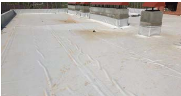
Рис. 5.4.6. Появление волнистости на поверхности смонтированной ПВХ-мембраны.
