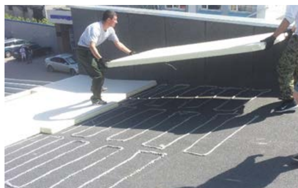
Рис. 2.4.8. Приклеивание плит LOGICPIR на клей-пену LOGICPIR.
