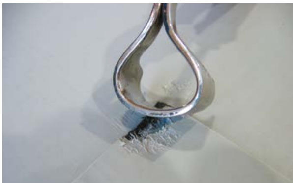
Рис. 5.2.14. Инструмент для подрезки нижнего полотна мембраны.
