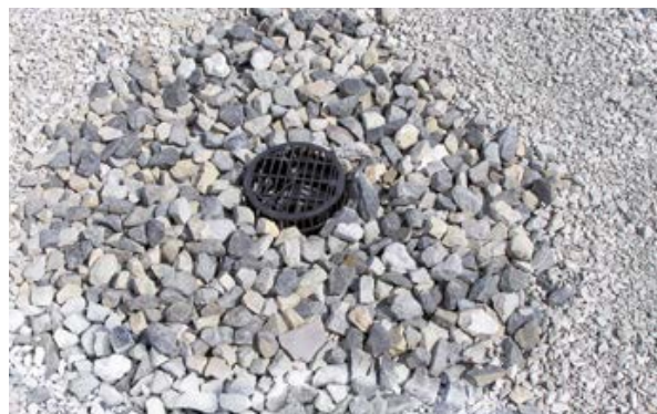
Рис. 2.5.6. Увеличение фракции балласта вокруг воронки.
