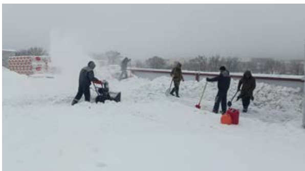
Рис. 3.1.2. Удаление снега и воды из гофр профилированного листа специальной лопатой и автоматизированной снегоуборочной техникой.
