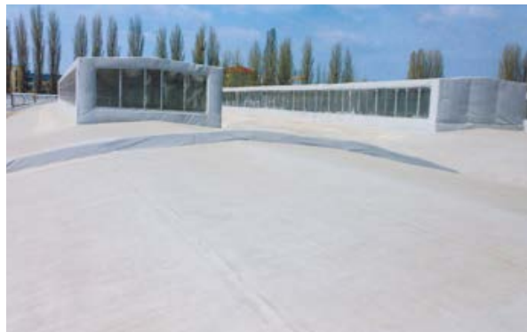
Рис. 2.4.4. Вид кровли после ремонта с применением ПВХ-мембраны ТЕХНОНИКОЛЬ и доутеплением термо-плитами LOGICPIR PROF.
