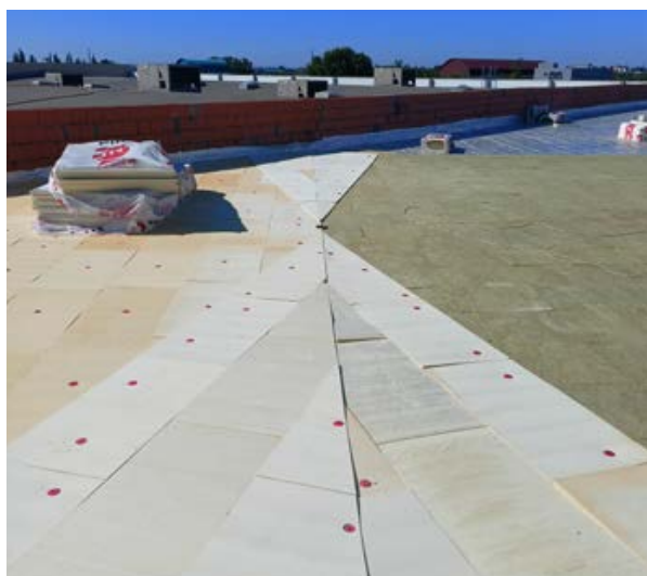
Рис. 3.4.18. Разуклонка в ендове между воронками.
