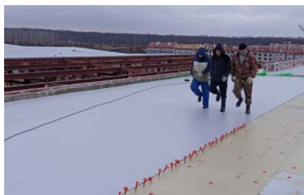
Рис. 5.4.2. Натяжение мембраны шаркающим движением ног.
