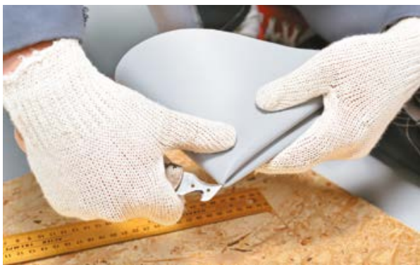
13. Сделайте отверстие с помощью кровельного ножа, чтобы найти центр окружности.
