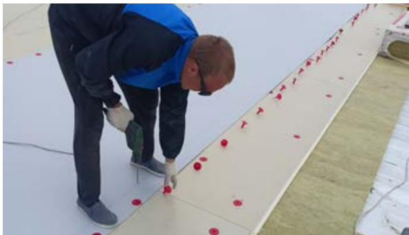
Рис. 5.4.4. Механическое крепление мембраны.
