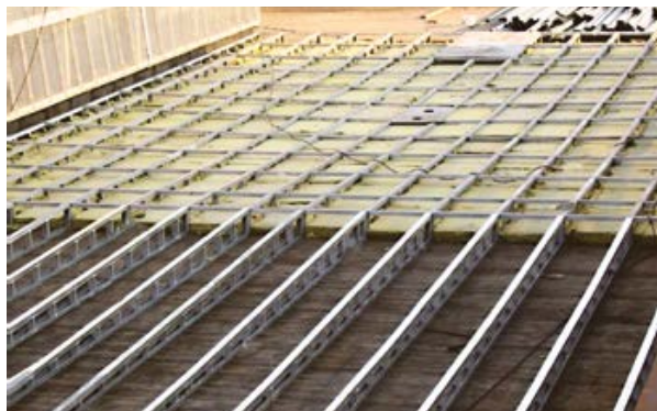
Рис. 3.4.6. Вариант устройства разуклонок.
