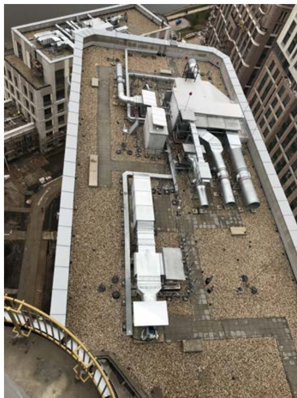
Рис. 2.5.1. Вид кровли с насыпным балластом.
