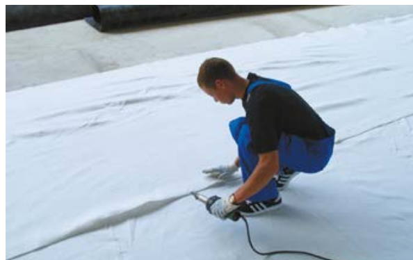
Рис. 3.4.1. Сварка полотнищ геотекстиля между собой.
