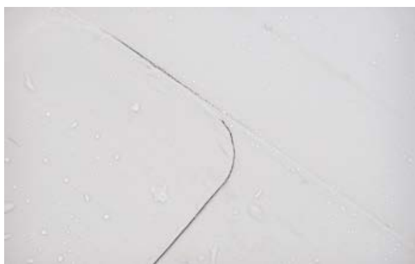
Рис. 5.4.1. Скругление углов мембраны.
