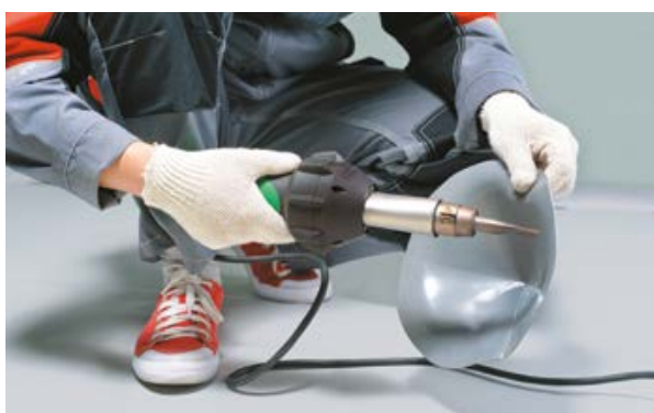
21. Затем прогревайте небольшой участок нижней части заготовки, двигая соплом фена вдоль него, пока мембрана не станет пластичной.
