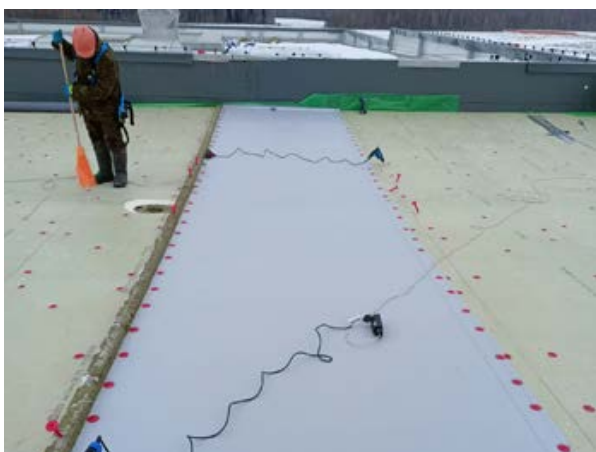
Рис. 2.6.1. Процесс ремонта кровельной сэндвич-панели с применением термоплит LOGICPIR и ПВХ-мембраны ТЕХНОНИКОЛЬ.
