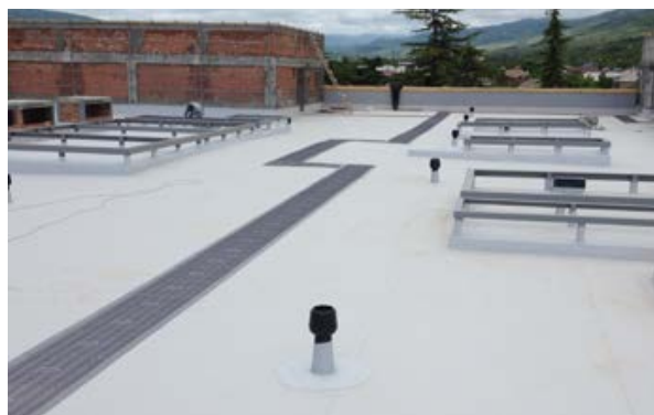
Устройство защиты кровли с помощью дорожек LOGICROOF Walkway Puzzle.
