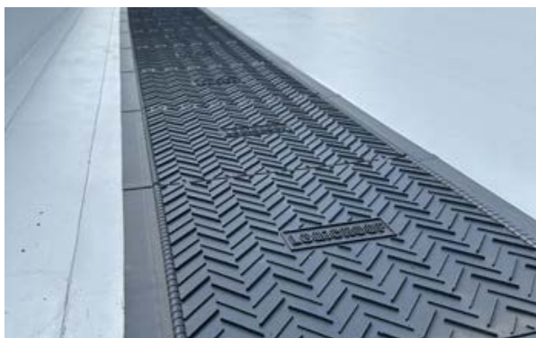
Пешеходная дорожка LOGICROOF Walkway Puzzle на кровле.
