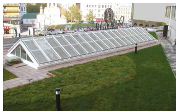
Рис. 2.5.4. Вид озелененной балластной кровли.
