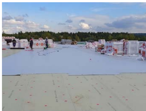
Рис. 2.6.1. Процесс ремонта кровельной сэндвич-панели с применением термоплит LOGICPIR и ПВХ-мембраны ТЕХНОНИКОЛЬ.
