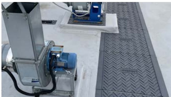
Рис. 3.7.5. Вид кровли с выполненной пешеходной дорожкой из готовых элементов на основе ПВХ LOGICROOF Walkway Puzzle.
