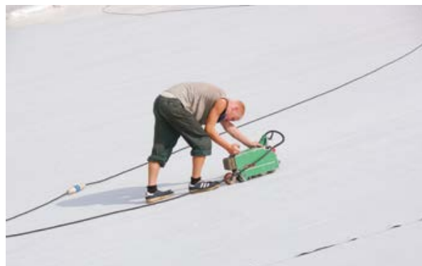
Рис. 2.4.11. Сварка полотен ПВХ-мембраны горячим воздухом после ее сплошной приклейки к существующему основанию.
