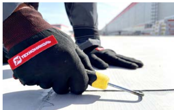
Рис. 5.2.10. Контроль при помощи специального пробника
