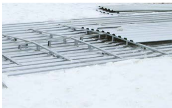
Рис. 3.4.7. Вариант устройства разуклонок.
