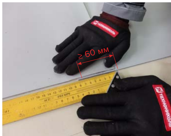
Минимальный нахлест полотен ПВХ-мембраны в зоне сварки.
