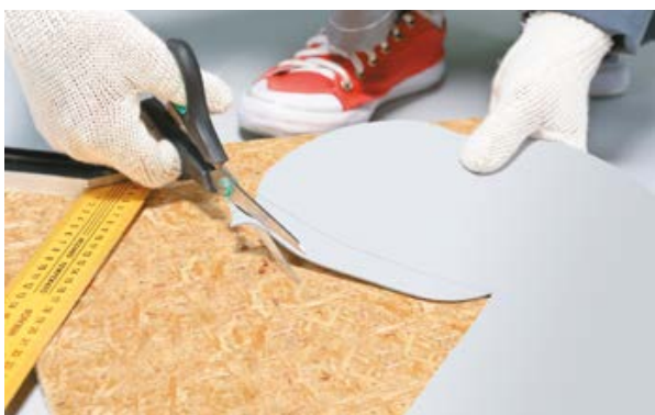
17. Закруглите углы с помощью ножниц.
