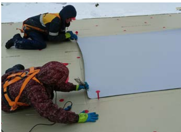
Рис. 5.4.5. Натяжение мембраны.
