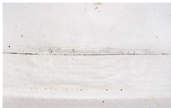
Рис. 4.5.8. Дефект сварного шва «вафля» — давление сварочного автомата на нагретую поверхность мембраны в летний день может привести к истончению слоя полимера над армирующей сеткой. Появление такого дефекта исключается при использовании мембраны толщиной более 1,2 мм.
