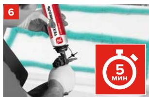
Рабочее положение баллона — ДНОМ ВВЕРХ. Нанести клей на поверхность и подождать 5 минут, это способствует полному расширению клея и облегчит корректировку панели.
