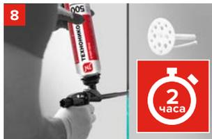
Отверстия, швы и зазоры заполнить клеем. Спустя 2 часа необходимо закрепить механическим крепежом. Высохший клей должен быть защищен от УФ-лучей.
