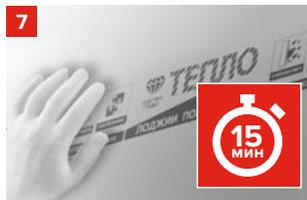
Приложить панель к стене и надавить до момента схватывания. В течение 15 минут можно корректировать положение, плавно двигая.
