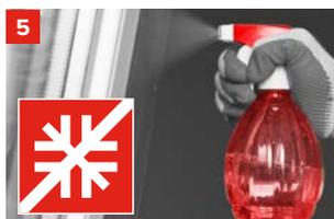
Поверхность перед нанесением увлажнить при помощи мелко-дисперсного пульверизатора. Не наносить клей на поверхность, покрытую инеем или льдом!
