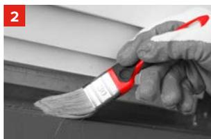
Очистите поверхность при помощи мягкой щетки или кисти. Для удаления жировых загрязнений используйте ветошь, смоченную очистителем монтажной пены ТЕХНИКОЛЬ.
