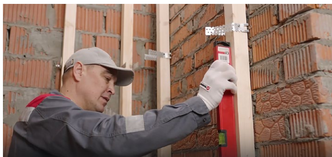
Рис. 1.1. Установка каркаса под теплоизоляцию
