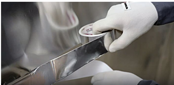
Рис. 3.2. Проклейка стыков пароизоляции
