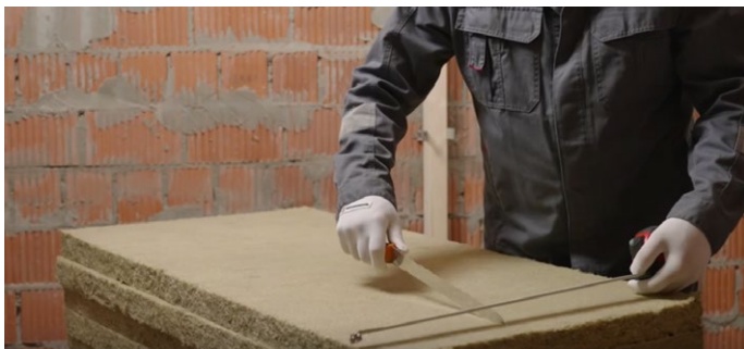
Рис. 2.1. Укладка плит теплоизоляции
