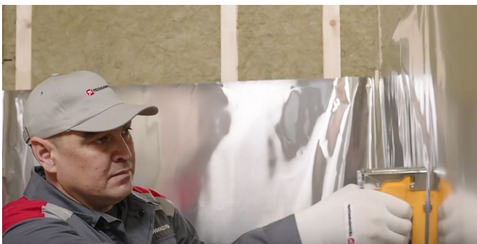
Рис. 3.1. Монтаж пароизоляции
