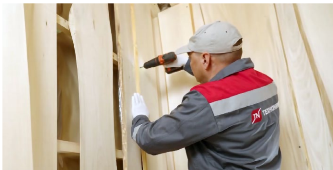
Рис. 4.1. Устройство внутренней обшивки
