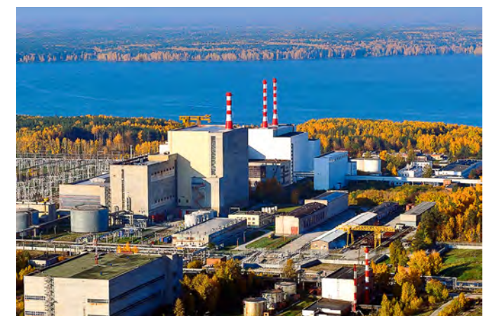
Белоярская АЭС, Свердловская область
