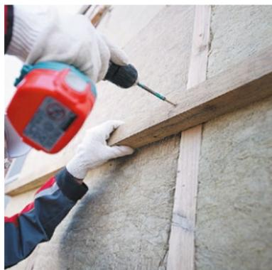
Рис. 7.3. Установка горизонтального каркаса
