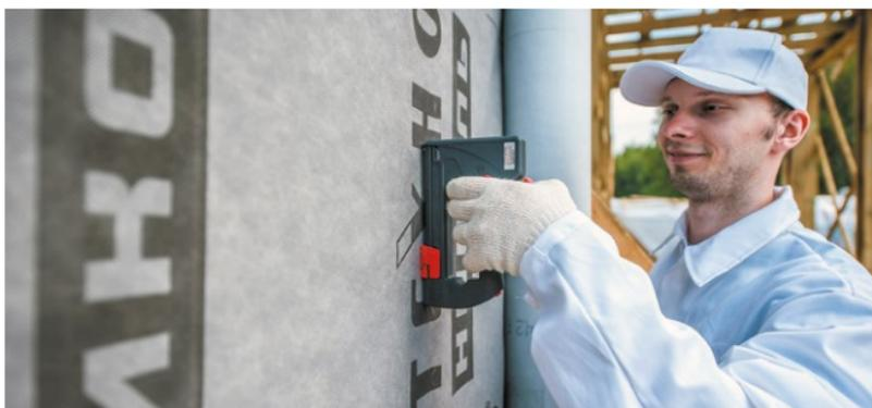
Рис. 7.22. Монтаж ветро-, влагозащитной мембраны
