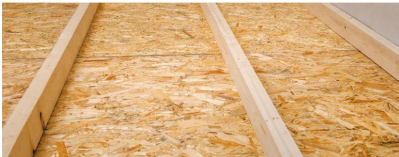
Рис. 5.1. Подшивка лаг снизу
