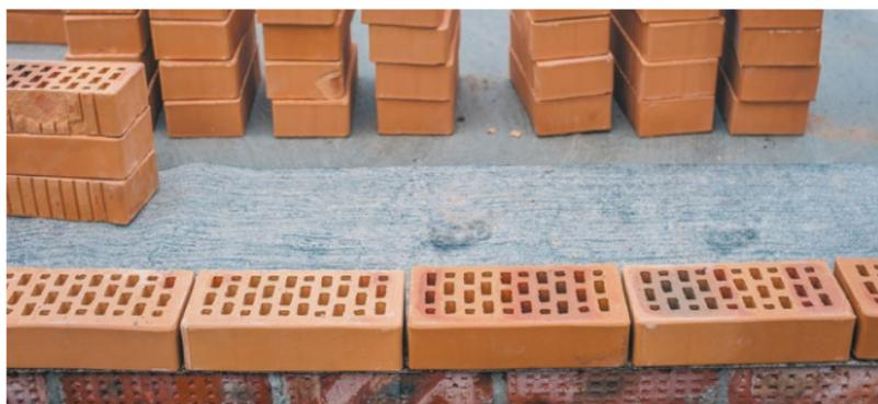
Рис. 7.8. Гидроизоляционная отсечка
