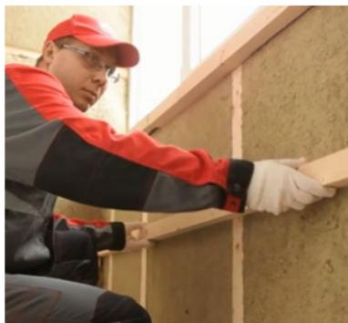
Рис. 7.44. Установка горизонтального каркаса под теплоизоляцию
