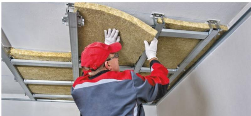
Рис. 5.24. Укладка плит ТЕХНОАКУСТИК
