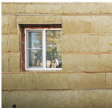
Рис. 7.4. Монтаж теплоизоляционных плит в горизонтальный каркас
