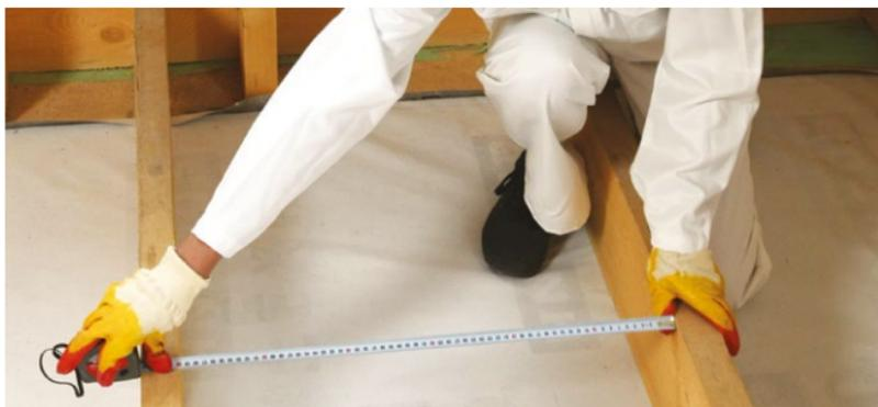
Рис. 4.9. Смонтированная пароизоляционная пленка
