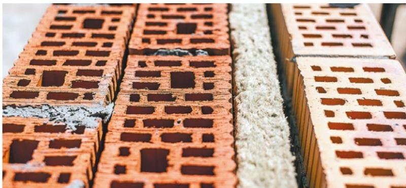
Рис. 7.12. Монтаж плит теплоизоляции
