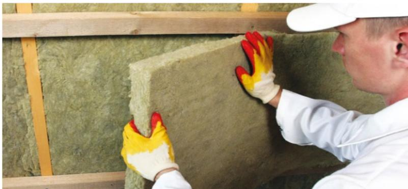
Рис. 4.4.б. Укладка второго слоя теплоизоляции
