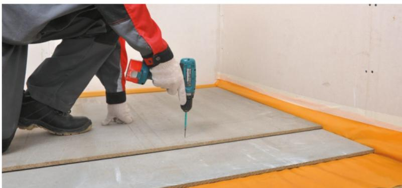
Рис. 5.11. Устройство сборной стяжки
