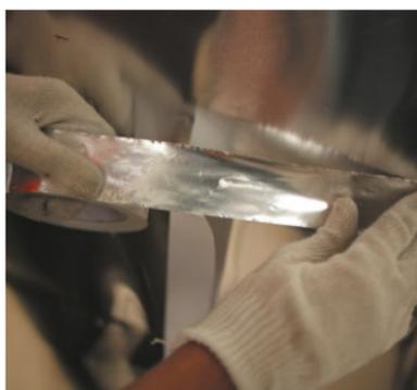
Рис. 6.16. Проклейка стыков пароизоляции
