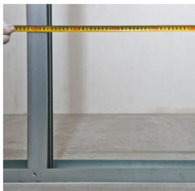
Рис. 6.4. Установка стоечного профиля.
