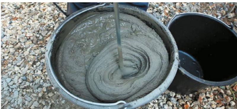
Рис. 7.27. Замешивание клея для приклейки теплоизоляции
