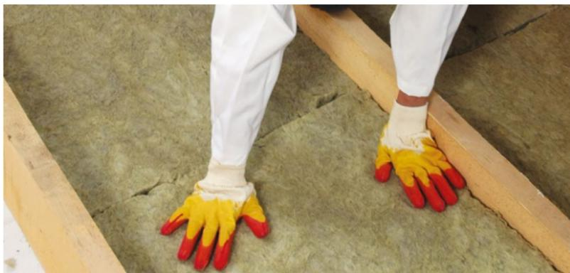
Рис. 4.11. Монтаж теплоизоляции между балками
