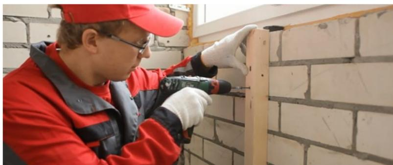
Рис. 7.42. Установка вертикального каркаса под теплоизоляцию
