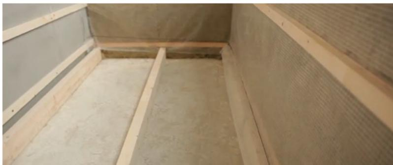
Рис. 7.49. Монтаж деревянных лаг на пол
