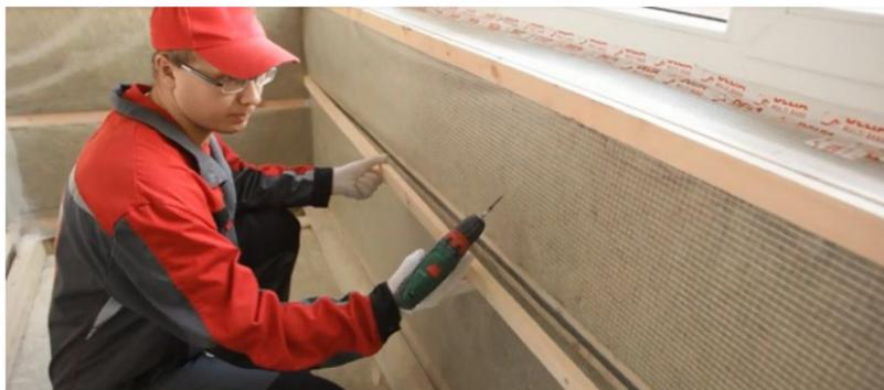
Рис. 7.47. Монтаж контррейки
