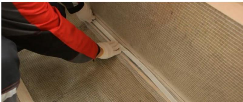
Рис. 7.52. Проклейка нахлестов пароизоляции
