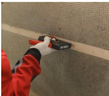
Рис. 7.46. Монтаж пароизоляции
