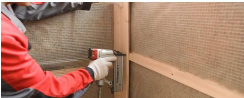
Рис. 7.48. Устройство внутренней обшивки
