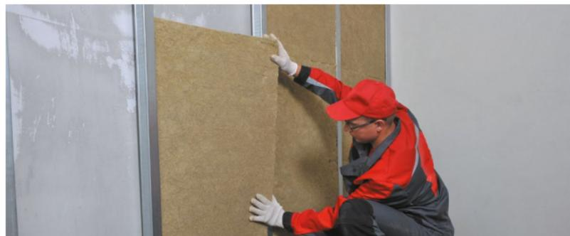
Рис. 6.11. Монтаж тепло-, звукоизоляционных плит
