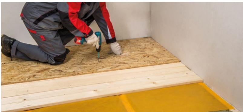
Рис. 5.4.б. Монтаж чернового пола
