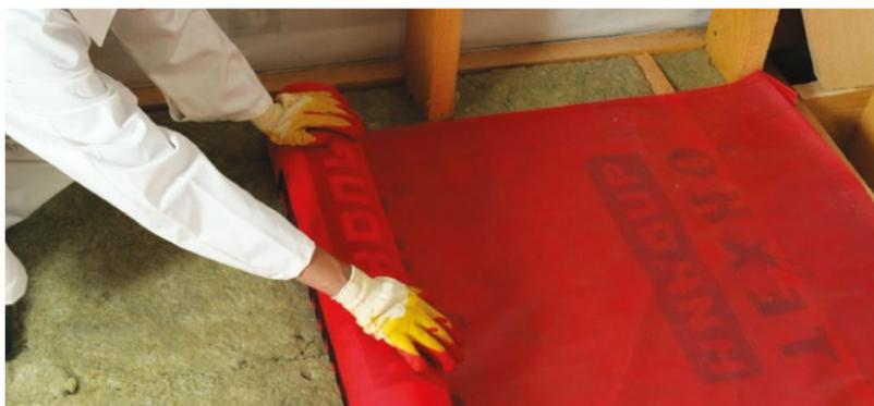
Рис. 4.12. Монтаж ветро-, влагозащитной мембраны
