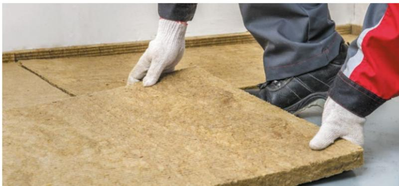
Рис. 5.8. Укладка плит ТЕХНОФЛОР СТАНДАРТ
