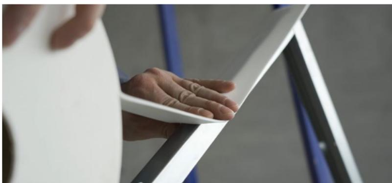
Рис. 5.22. Приклеивание виброизоляционной ленты
