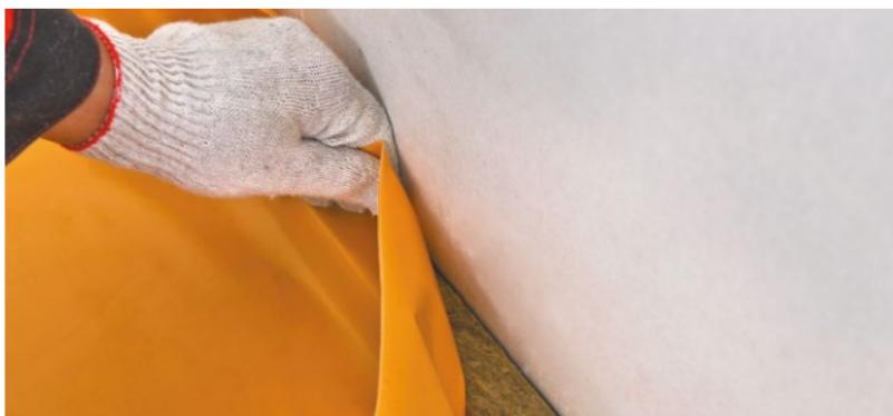
Рис. 5.9. Укладка гидроизоляции
