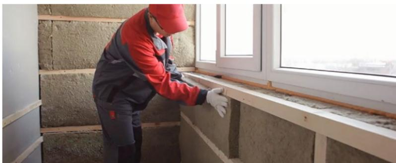
Рис. 7.45. Укладка плит теплоизоляции второго слоя
