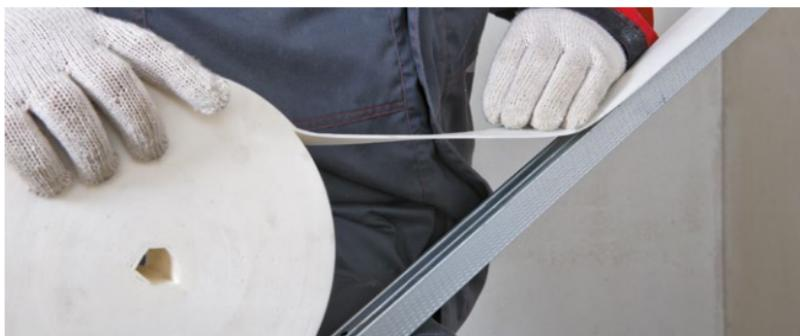
Рис. 6.9. Приклейка уплотнительной ленты к профилям
