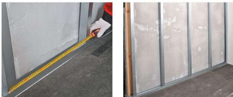
Рис. 6.10. Установка направляющего и стоечного профилей
