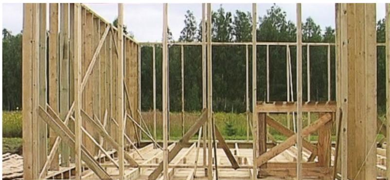
Рис. 7.19. Установка деревянного каркаса
