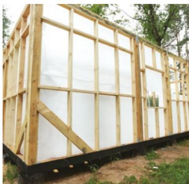
Рис. 7.20. Монтаж пароизоляционной пленки
