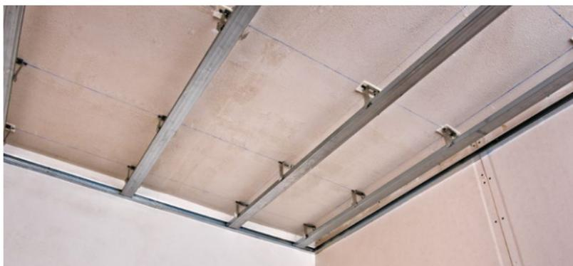
Рис. 5.23. Установка подвесов и потолочного профиля
