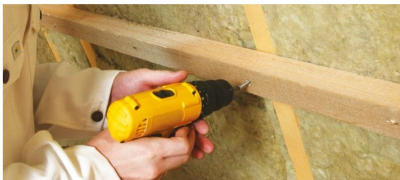
Рис. 4.4.а. Укладка второго слоя теплоизоляции
