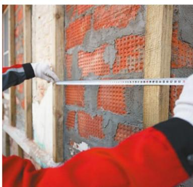
Рис. 71. Крепление вертикальных стоек деревянного каркаса
