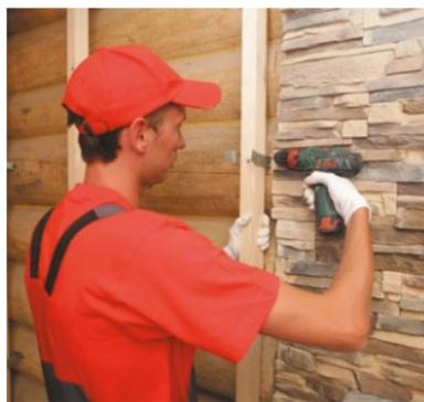
Рис. 6.13. Установка каркаса под теплоизоляцию
