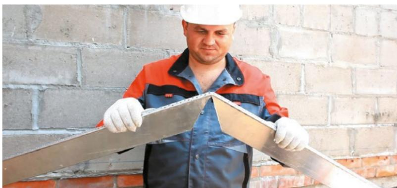
Рис. 7.26.а. Установка опорного профиля для первого ряда теплоизоляции с применением алюминиевого стартового профиля
