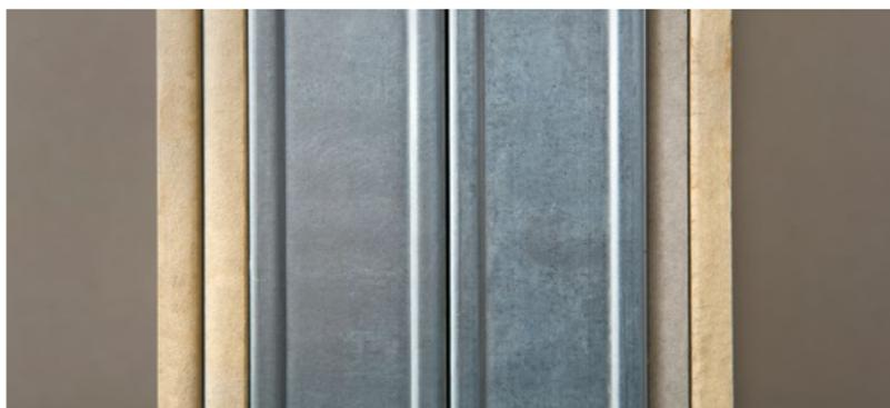
Рис. 6.7. Обшивка второй стороны перегородки листами ГКЛ
