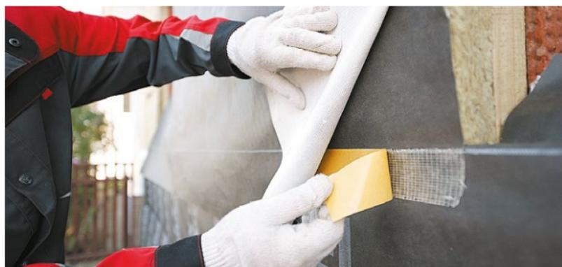
Рис. 7.5. Монтаж и проклейка стыков полотен ветро-, влагозащитной мембраны
