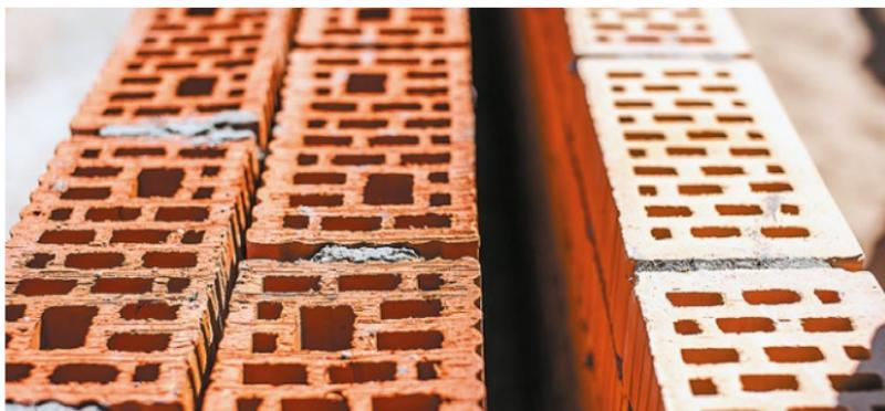
Рис. 7.11. Монтаж внутренней версты
