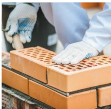
Рис. 7.10. Монтаж внешней версты
