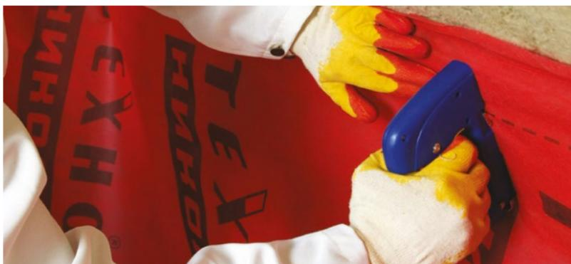
Рис. 4.5. Укладка и фиксация пароизоляционной пленки
