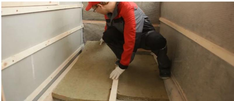
Рис. 7.50. Укладка теплоизоляционных плит
