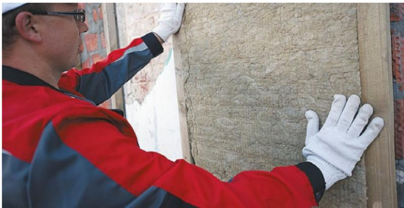
Рис. 7.2. Монтаж теплоизоляционных плит в вертикальный каркас
