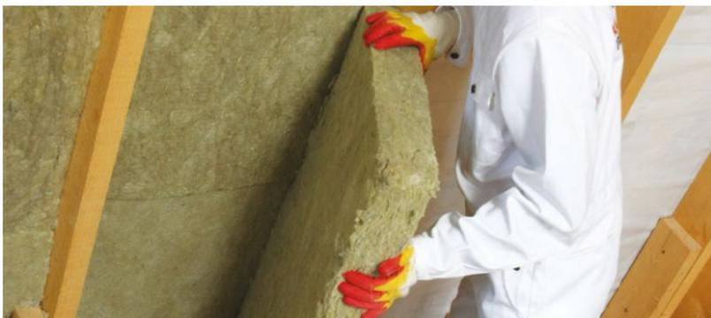
Рис. 4.3.а. Монтаж теплоизоляции враспор между стропилами
