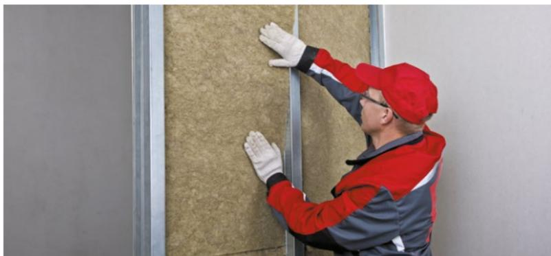
Рис. 6.6. Укладка плит ТЕХНОАКУСТИК
