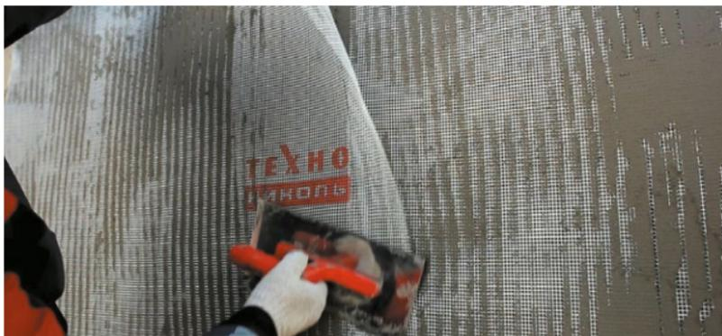
Рис. 7.39. Армирование базового штукатурного слоя стеклосеткой
