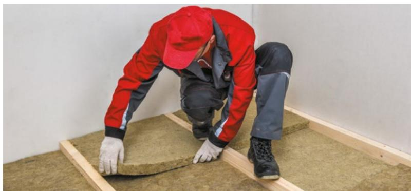
Рис. 5.2. Монтаж теплоизоляции враспор между лагами
