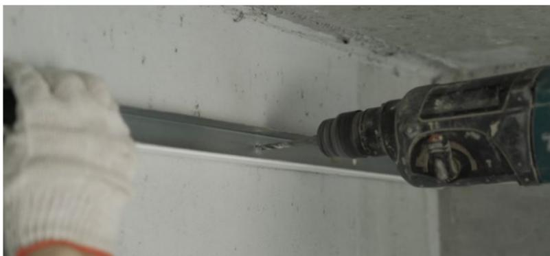
Рис. 5.21. Крепление направляющего профиля
