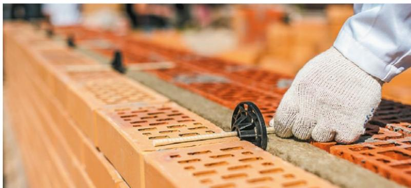
Рис. 7.14. Установка гибких связей
