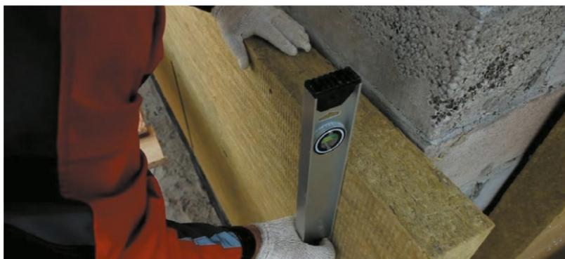
Рис. 7.31. Приклейка плиты тепло-, звукоизоляции к стене
