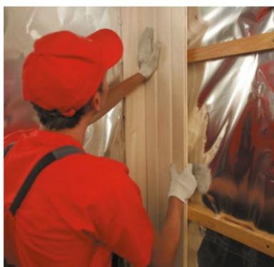
Рис. 6.17. Устройство внутренней обшивки
