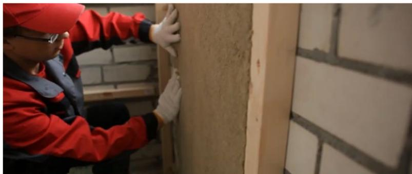
Рис. 7.43. Укладка плит теплоизоляции первого слоя
