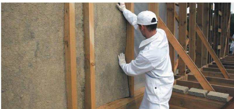
Рис. 7.21. Монтаж теплоизоляционных плит
