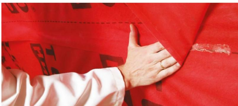
Рис. 4.6. Проклейка стыков пароизоляционной пленки
