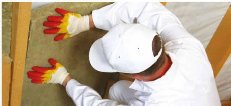
Рис. 4.3.6. Монтаж теплоизоляции враспор между стропилами
