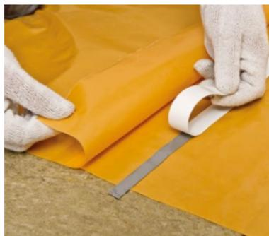
Рис. 5.3. Монтаж и проклейка нахлестов пароизоляционной пленки
