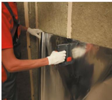
Рис. 6.15. Монтаж пароизоляции
