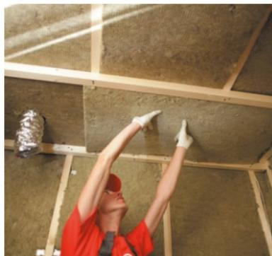
Рис. 6.14. Укладка плит теплоизоляции
