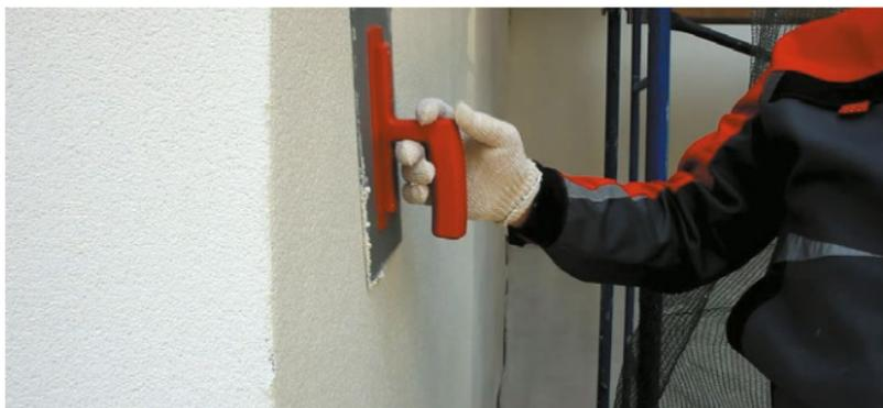
Рис. 7.41. Нанесение декоративного слоя штукатурки
