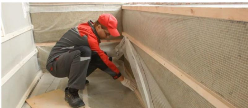
Рис. 7.51. Монтаж пароизоляционной пленки
