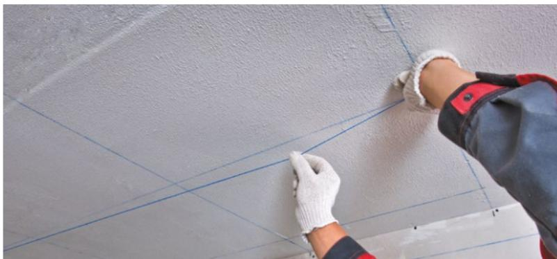
Рис. 5.20. Разметка стен и потолка для крепления направляющего профиля и подвесов
