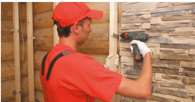
Рис. 1.1. Установка каркаса под теплоизоляцию
