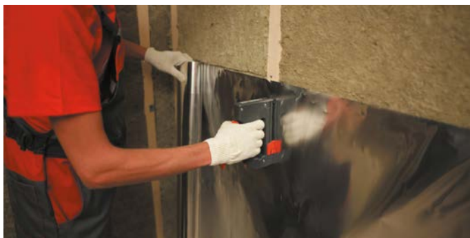
Рис. 3.1. Монтаж пароизоляции
