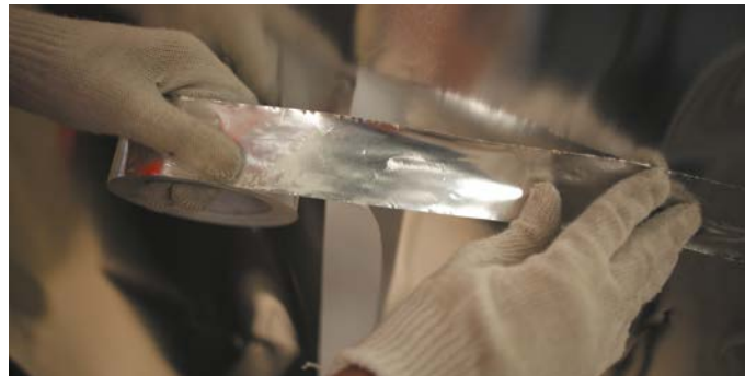
Рис. 3.2.б. Проклейка стыков пароизоляции
