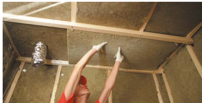
Рис. 2.1. Укладка плит теплоизоляции
