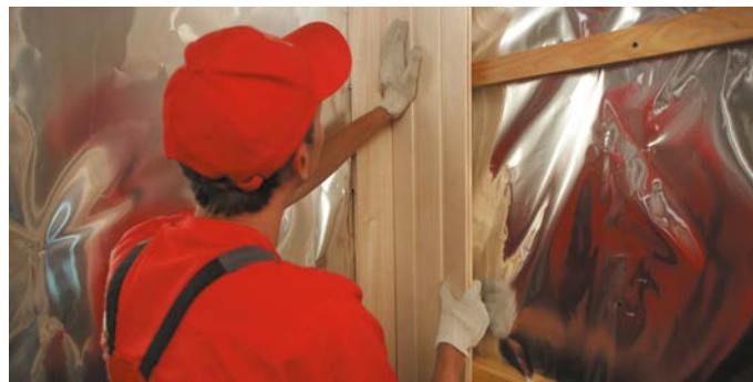
Рис. 4.1. Устройство внутренней обшивки
