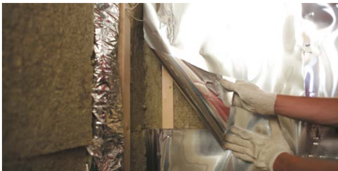
Рис. 3.2.а. Проклейка стыков пароизоляции
