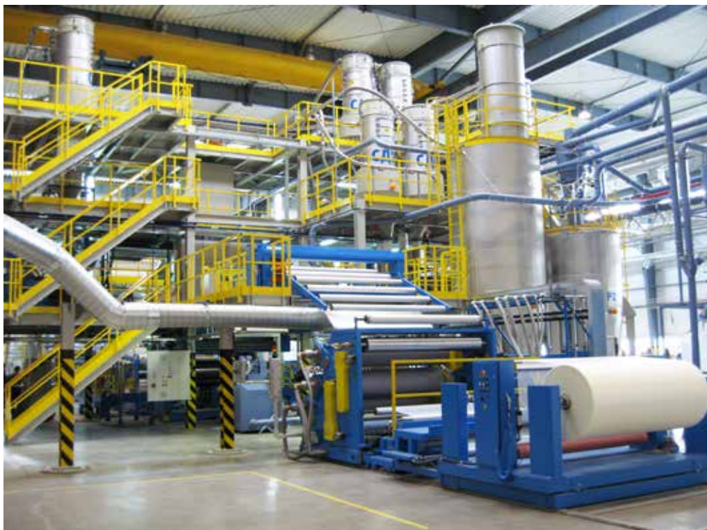
Производственная линия для изготовления полимерных мембран
