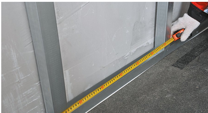
Рис. 11. Установка направляющего и стоечного профилей
