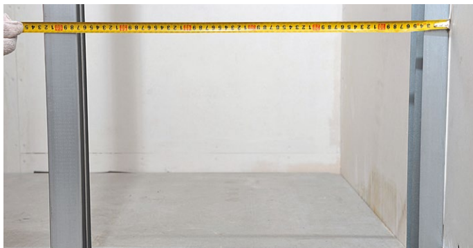
Рис. 4. Установка стоечного профиля
