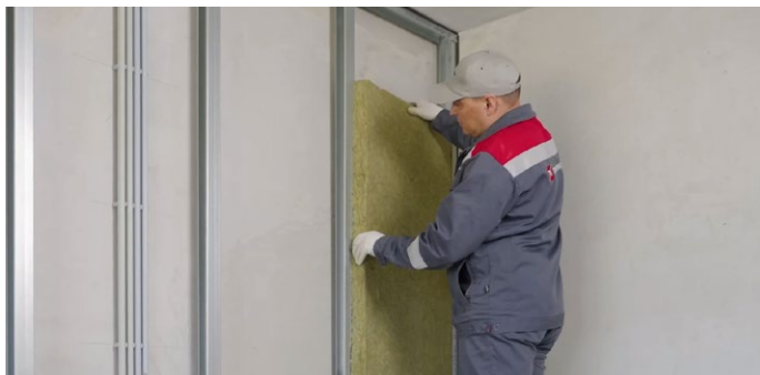
Рис. 12. Монтаж звукоизоляционных плит
