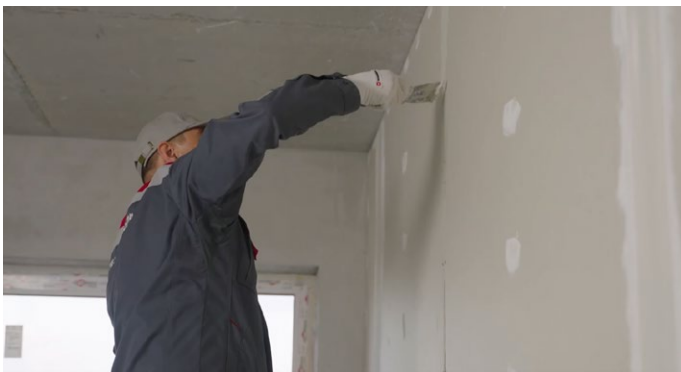
Рис. 8. Заделка швов
