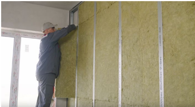
Рис. 6. Монтаж звукоизоляционных плит
