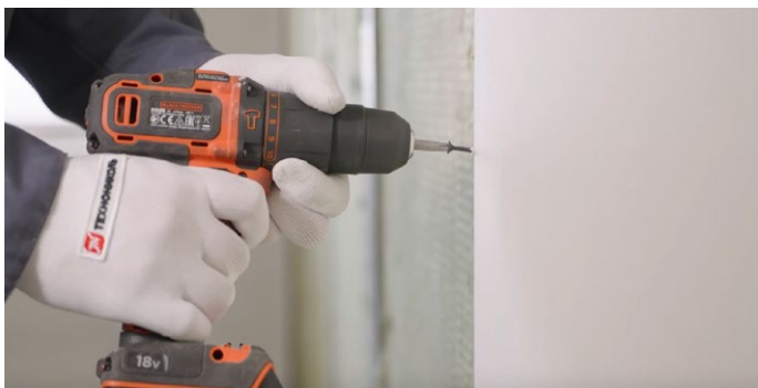
Рис. 13. Обшивка стен листами ГКЛ
