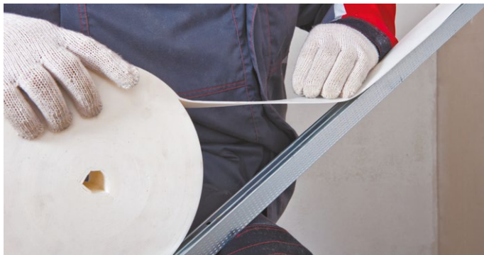
Рис. 10. Приклейка уплотнительной ленты к профилям и резка профиля
