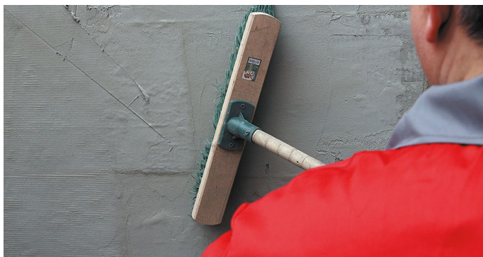
Рис. 9. Подготовка помещения к работе
