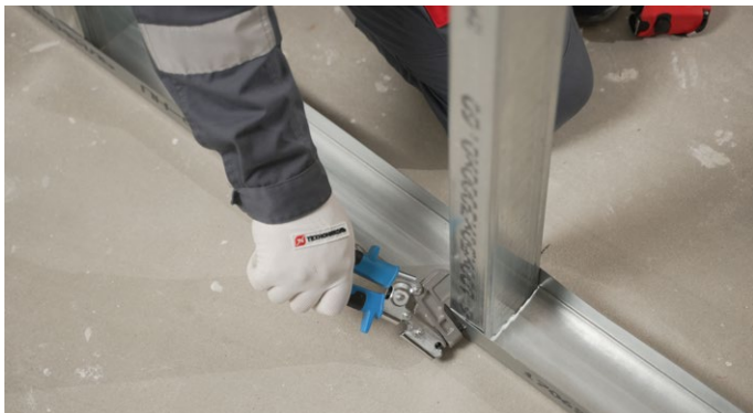
Рис. 4. Фиксация стоечного профиля
