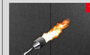
Оплавить защитную пленку на гидроизоляционном слое в местах установки крепежа.
