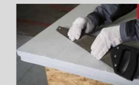
4 Перед началом монтажа плит XPS поверхность необходимо отфрезеровать. Фрезеровка может выполняться ножовкой по дереву или щеткой с металлическим ворсом. При использовании плит XPS ТЕХНОНИКОЛЬ CARBON ECO FAS фрезеровка не требуется.
