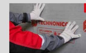
7 Приложить плиту с КЛЕЙ-ПЕНОЙ ТЕХНОНИКОЛЬ к стене и слегка надавить. Зафиксировать плиту до момента схватывания клея. Плиты следует крепить вплотную одна к другой. Зазор между плитами не должен превышать 2 мм.
