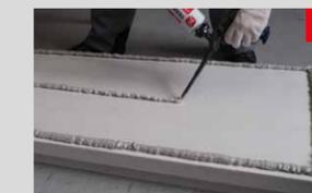
5 Нанести КЛЕЙ-ПЕНУ ТЕХНОНИКОЛЬ для пенополистирола по периметру плиты и одной полосой по центру.
