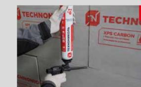
8 Для предотвращения образования мостиков холода зазоры более 2 мм между плитами необходимо плотно заполнить обрезками пенополистирола и КЛЕЙ-ПЕНОЙ ТЕХНОНИКОЛЬ для пенополистирола.
