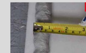
6 По периметру КЛЕЙ-ПЕНУ ТЕХНОНИКОЛЬ для пенополистирола следует наносить с отступом примерно 2 см от края. Ширина полос около 3 см.
