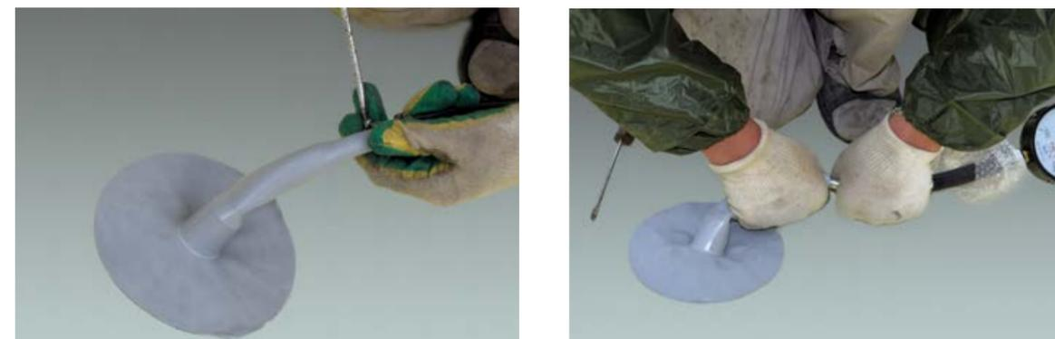
**Рис. 20.** Соединение прямого инъекционного штуцера и трубки
