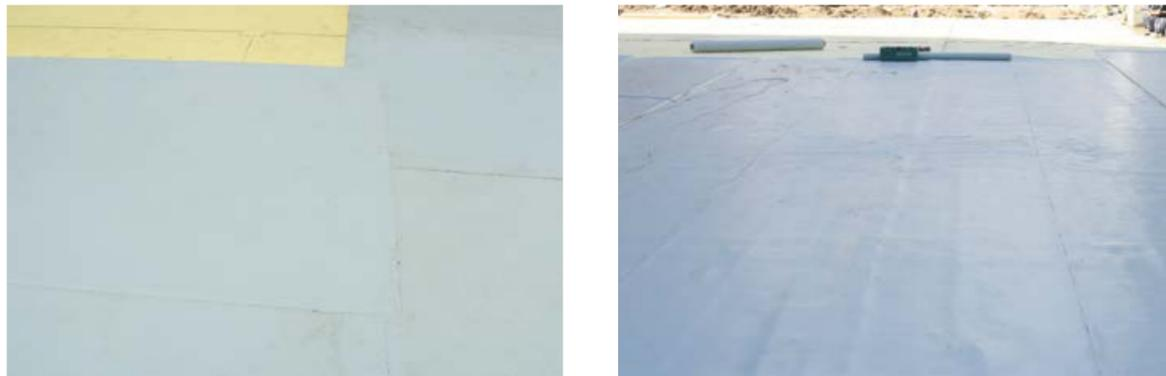
Рис. 15. Рекомендуемое смещение продольных швов 2-го слоя гидроизоляционного пирога на объекте
