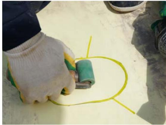
**Рис. 9.** Выполнение Т-образных пересечений полотен
