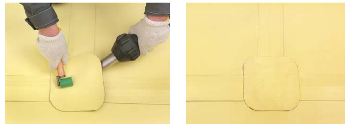
**Рис. 8.** Выполнение Т-образных пересечений полотен
