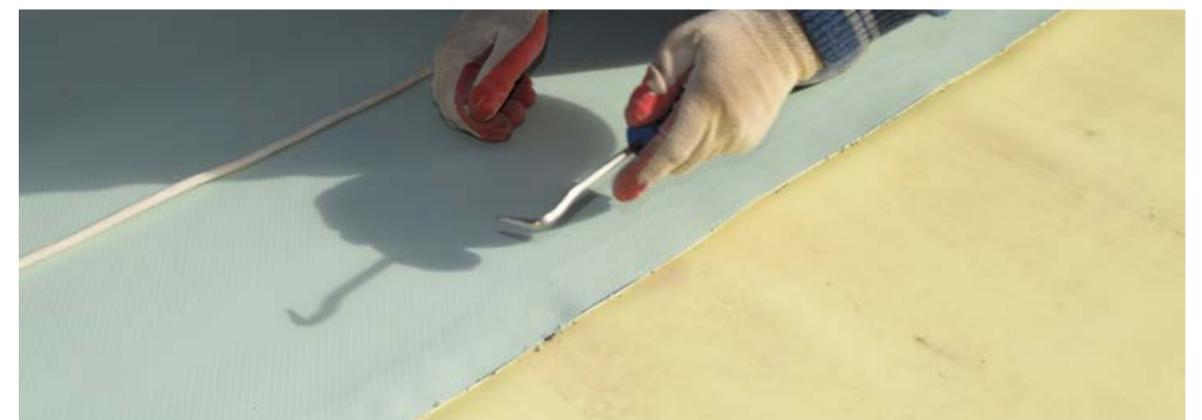
Рис. 19. Проверка качества сварного шва с помощью пробника
