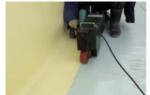
**Рис. 14.** Сварка автоматическим сварочным оборудованием LEISTER™ Varimat 1-го и 2-го слоев гидроизоляционных полимерных мембран
