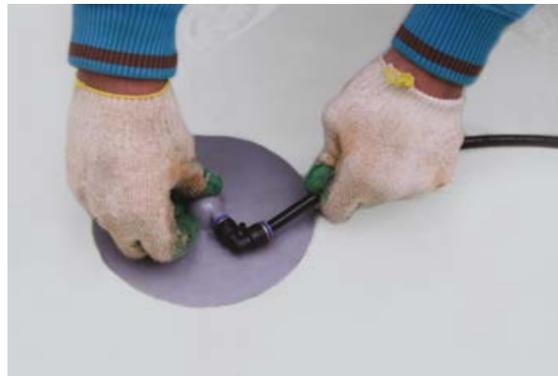
**Рис. 21.** Соединение углового инъекционного штуцера и трубки
