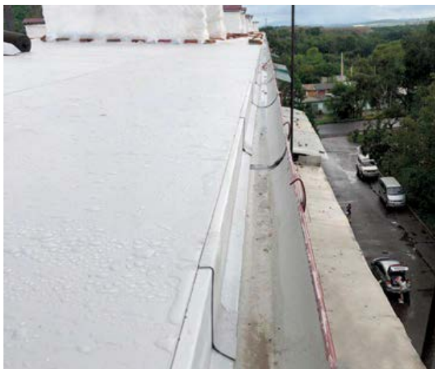
Устройство карнизного свеса
