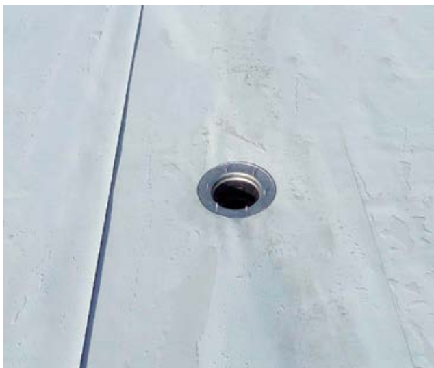
Устройство водоприемной воронки
