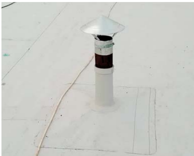
Примыкание к трубным проходкам
