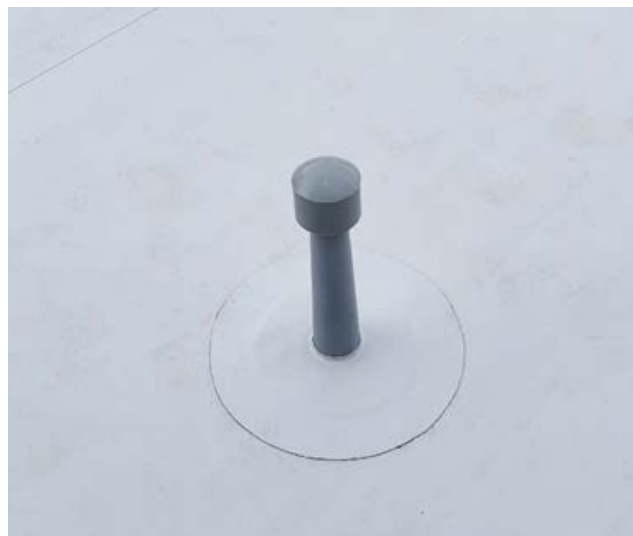
Примыкание к кровельному аэратору
