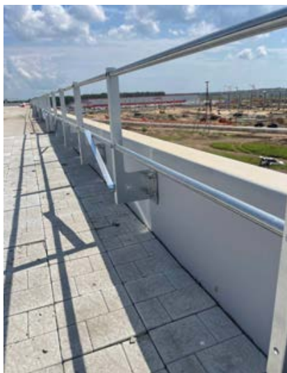
Установка ограждений ТН на парапет
