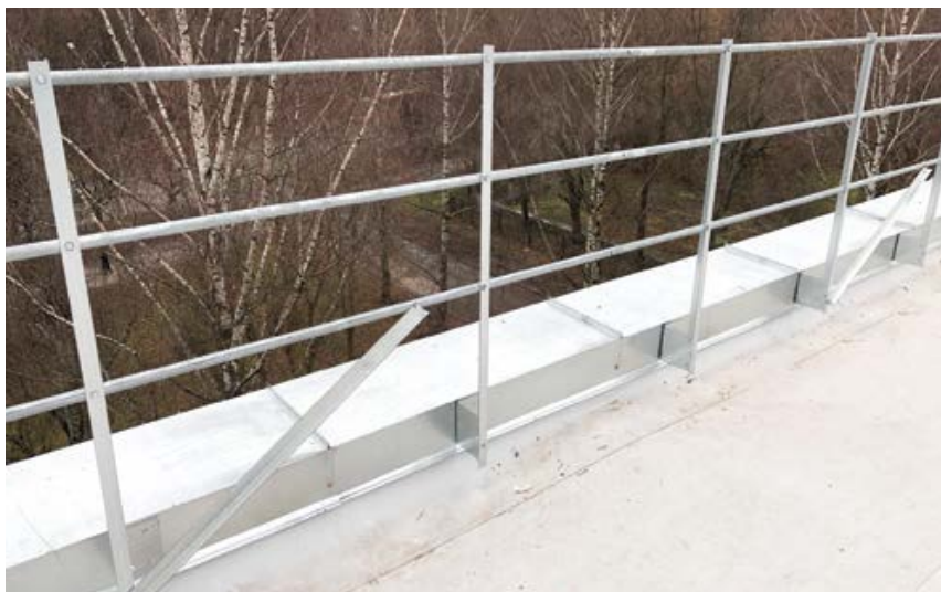
Установка ограждений ТН на парапет
