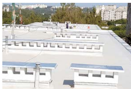
Примеры кровель, выполненных с использованием ПМ
