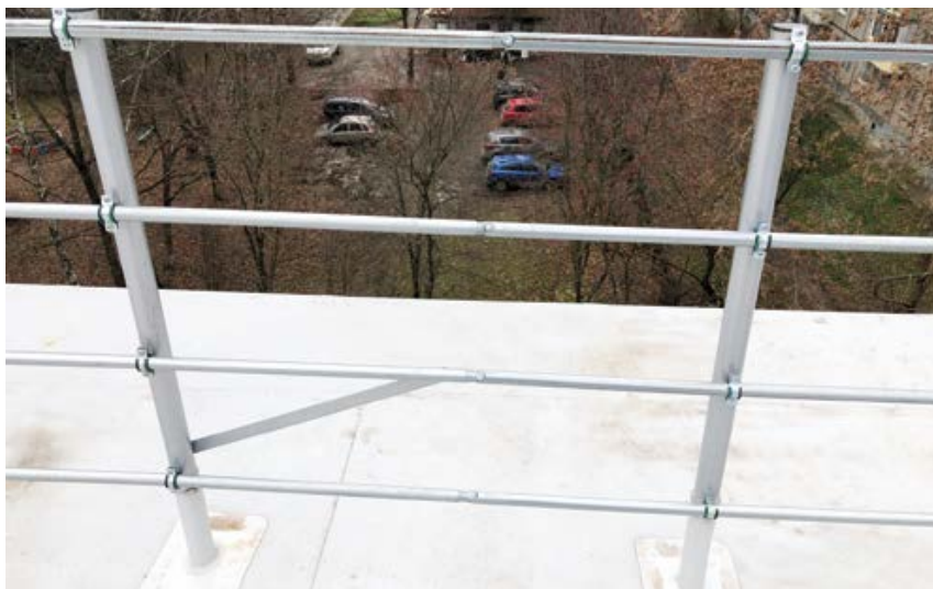
Установка ограждений (крепление в брус)
