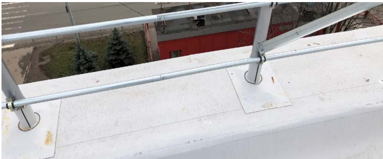
Установка ограждений ТН на парапет
