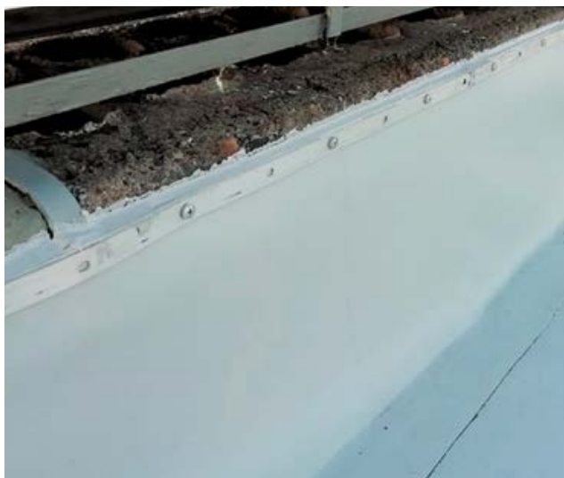
Примыкание к вертикальной поверхности
