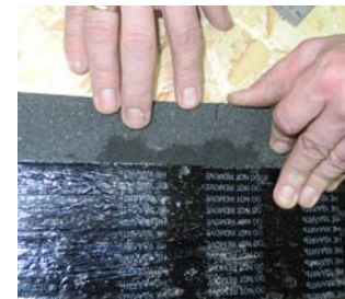
Рис. 74. Насечка для облегчения монтажа
