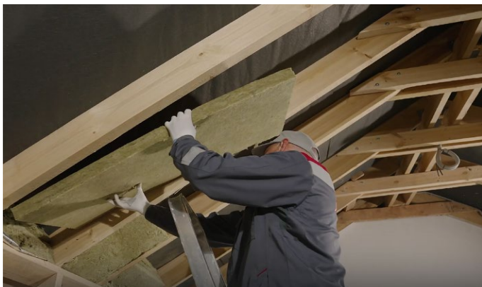
Рис. 3. Монтаж теплоизоляции враспор между стропилами
