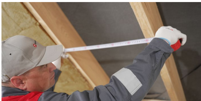
Рис. 2. Подготовленная система для дальнейшего монтажа теплоизоляции
