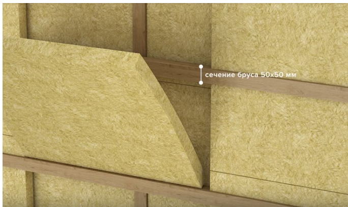
Рис. 4. Укладка второго слоя теплоизоляции
