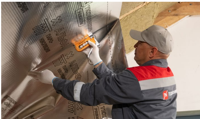
Рис. 5. Укладка и фиксация пароизоляционной пленки
