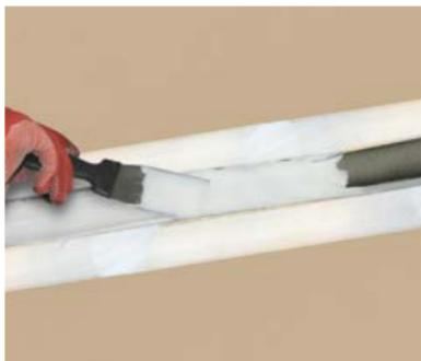
Герметик вводится в стык с помощью шпателя, не допуская разрывов, наплывов и вкраплений инородных тел.
