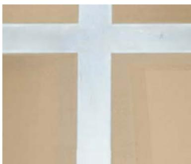
После нанесения герметика необходимо удалить малярный скотч. Готовый стык должен выглядеть следующим образом.
