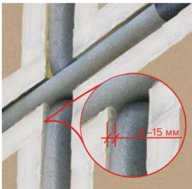
В местах пересечения горизонтальных и вертикальных стыков прокладки необходимо располагать следующим образом. Расстояние от наружной стороны прокладки до грани панели должно составлять не менее 5 мм и не более 15 мм.
