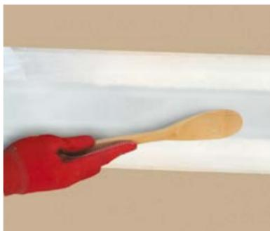
Форма шва двояковогнутая, создается изнутри уплотняющей прокладкой, а снаружи — с помощью деревянной лопатки, смоченной в мыльном растворе.
