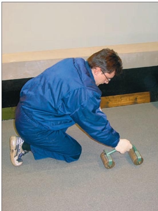
стве подкладочного ковра под гибкую черепицу и для устройства пароизоляции в различных строительных конструкциях. Благодаря малой толщине «Барьер ОС ГЧ» не заметен в комбинации с гибкой черепицей. Он обладает высокой эластичностью и прочностью, при деформации основания легко растягивается и не образует разрывов.
