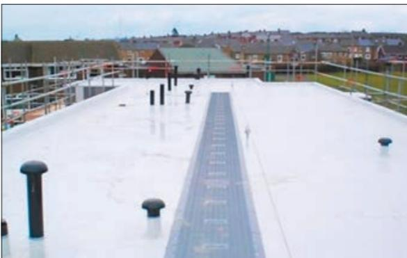
Рис. 4.8.16 Пешеходная дорожка LOGICROOF Walkway Puzzle на кровле
