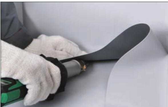
2. Для удобства работы прикатайте мембрану вдоль ребер угла латунным роликом и прихватите к основному кровельному ковру с помощью ручного фена.
