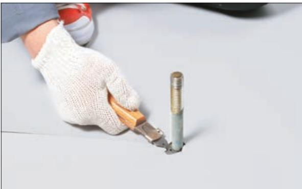
1. Сделайте разрез полотна мембранны, чтобы обойти проходку малого диаметра.
