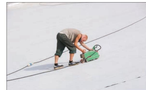
Рис. 2.9.8 После приклейки к основанию — мембранные свариваются обычным образом
