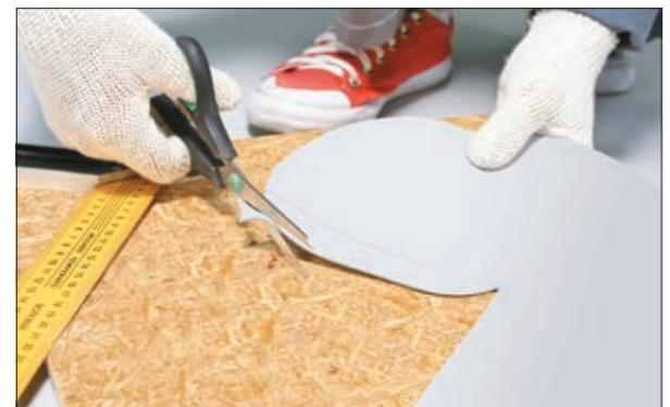
17. Закруглите углы с помощью ножниц.
