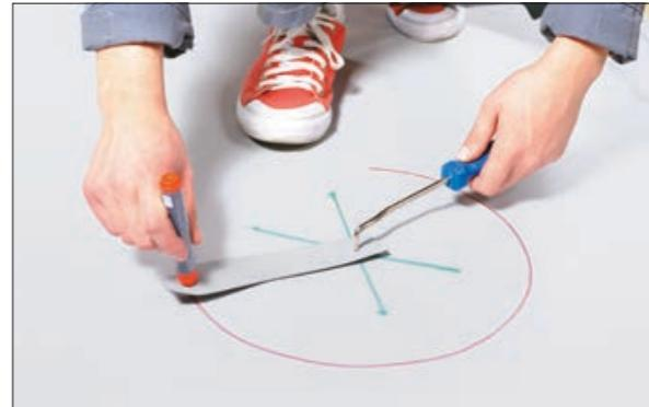
12. Продолжайте укладку мембранны в зоне установленной воронки обычным образом. После закрепления полотна найдите на мемbrane центр воронки как точку пересечения двух отрезков между гайками на фланце.
