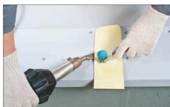
6. Точечно прихватите ПВХ мембрану к ПВХ металлу, а затем приварите неармированную ПВХ мембрану к капельнику с помощью ручного фена и прикаточного валика. Подрежьте нижнюю выступающую часть неармированной ПВХ мембранны кровельным ножом.
