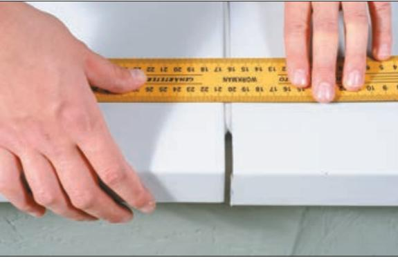
3. Оставляйте температурный зазор через каждые 3 м. Величина зазора должна составлять 3-5 мм. Выставив зазор, закрепите следующий капельник.
