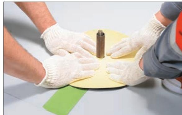
8. Затем быстро, пока мембрана не остыла, наденьте заготовку на проходку малого диаметра.
