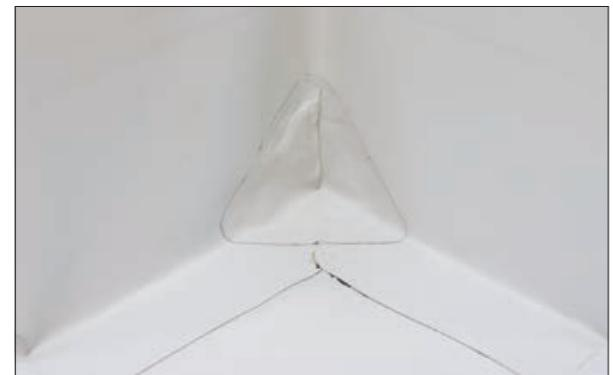
9. Привариваем полученный накладной угол по месту, располагая стык на вертикальном участке угла.
