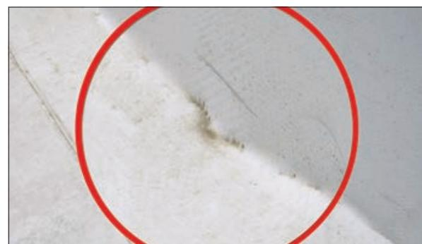
Рис. 3.6.8 Возможное повреждение мембранны при классическом способе крепления к вертикальной поверхности
