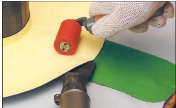
7. Окончательно приварите заготовку по внешнему краю. Проверьте качество сварки с помощью пробника.
