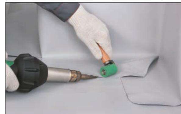
14. Далее приварите нахлест мембраны к основному кровельному ковру обычным образом с помощью силиконового ролика.
