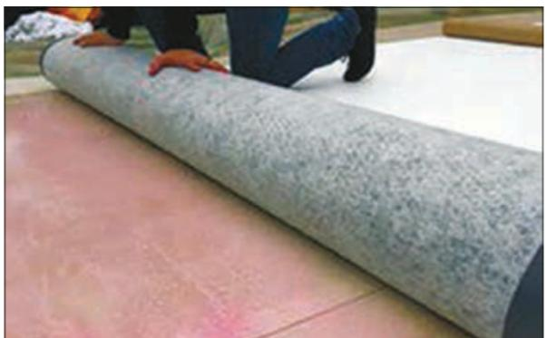
6. Закатывайте мембрану с флисом на участок с нанесенным клеем. Следите, чтобы клеевой состав не попадал в зону сварного шва.
