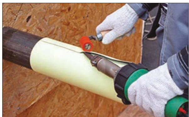
11. Проварите нахлест ручным феном, прикатывая тефлоновым или силиконовым роликом. Для облегчения работы (особенно в случае большого количества труб одинакового диаметра) можно использовать для сварки шва горизонтальную вспомогательную трубу. Снимите фаску с мембрани на нижней части заготовки.
