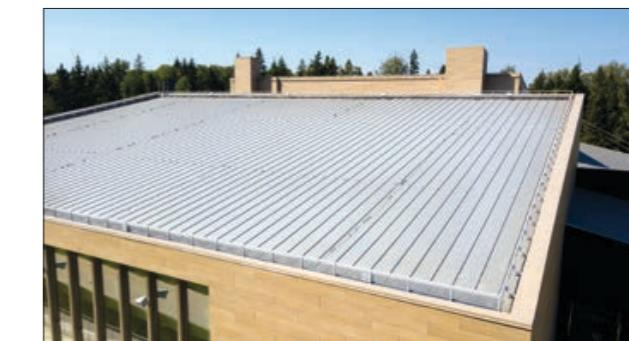
Рис. 4.8.2 Вид мембранный кровли с имитацией фальца
