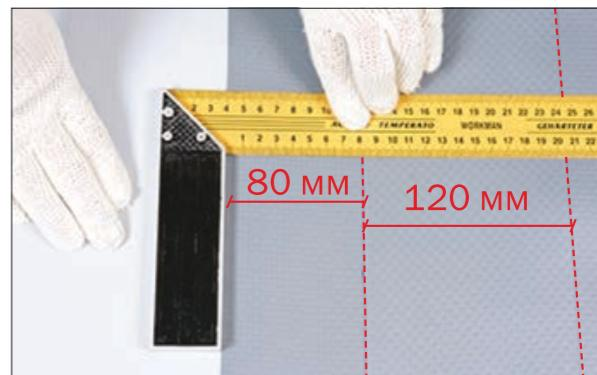
2. На изнаночной стороне полосы «парапетной» мембранны начертите линию на расстоянии 80 мм от нижнего края полотна и по ней выровняйте полоску для «кармана». Для получения «кармана» возможно использование специального готового элемента.
