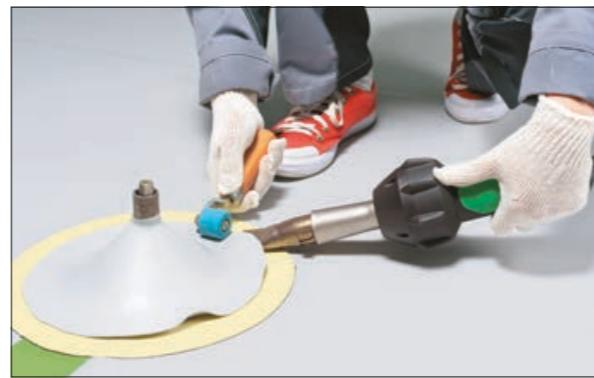
28. При этом давите латунным роликом «наружу», чтобы обеспечить необходимое натяжение мембранны.
