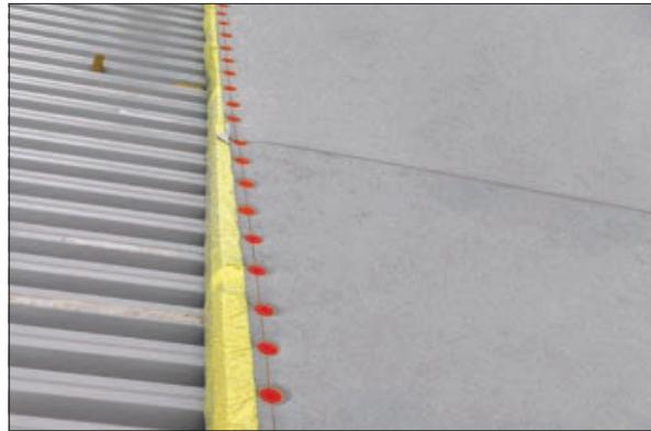
Рис. 3.1.7 Защита теплоизоляции от намокания
