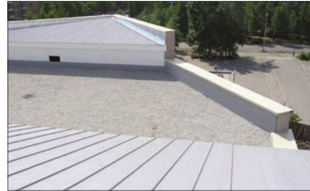
Рис. 2.7.1 Вид балластной кровли
