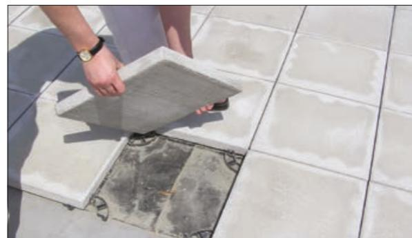
Рис. 2.7.3 Применение в качестве балласта тротуарной плитки
