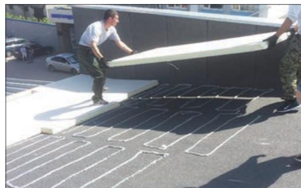
Рис. 2.9.4 Приклеивание плит LOGICPIR на Клей-пену LOGICPIR
