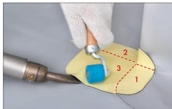
8. Приварите основную площадь заготовки к крольевному ковру.
