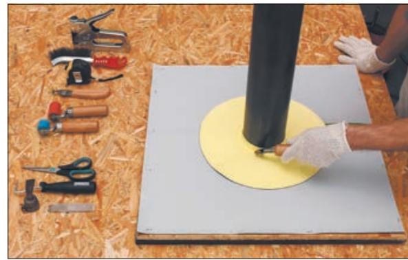
4. Не давая заготовке остывать, быстрым движением с силой наденьте ее на трубу и прикатайте основание «юбки» латунным роликом.
