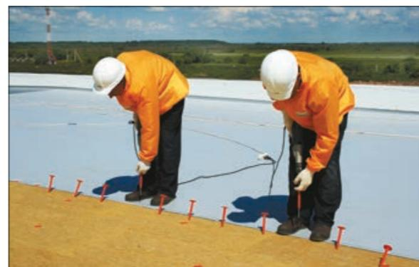
Рис. 5.4.4 Механическое крепление мембранны
