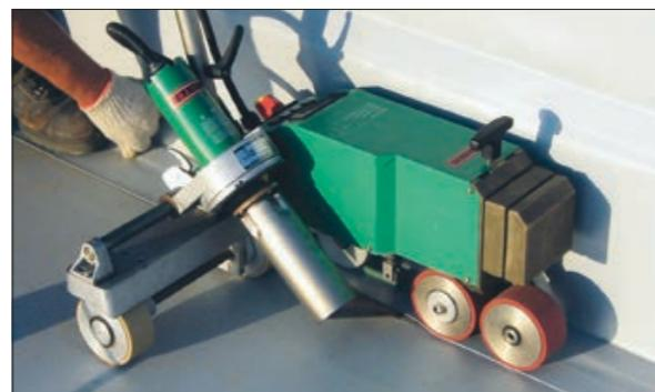
Основная инновация, связанная с полимерными мембранами, относится к технологии сварки горячим воздухом. В отличие от других методик, например, использования клея, растворителей, газовых горелок, эта технология гарантирует гомогенное соединение и полностью герметичную поверхность кровли. Полученный сварной шов более прочный, чем сама мембрана.
