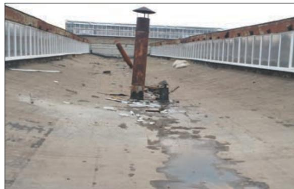
Рис. 2.10.3 а, б Старая битумная кровля
