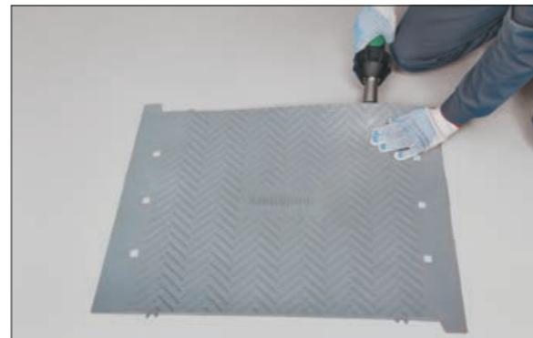
1. Зафиксируйте первый элемент дорожки с двух сторон к основному кровельному ковру с помощью ручного фена.
