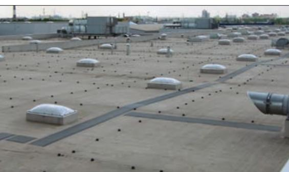
Рис. 3.6.4 Вид кровли с применением пешеходной дорожки ТЕХНОНИКОЛЬ
