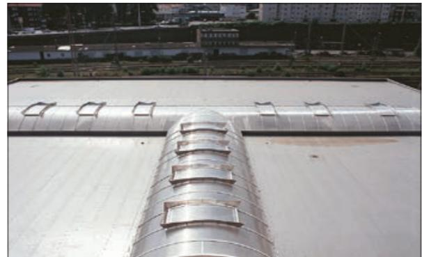
в действие устройства дымоудаления обеспечивают в случае пожара быстрый отвод дыма и тепла из здания. Это позволяет эффективно бороться с пожарами и максимально обезопасить людей, здания и ценное имущество (рис. 4.8.10).
