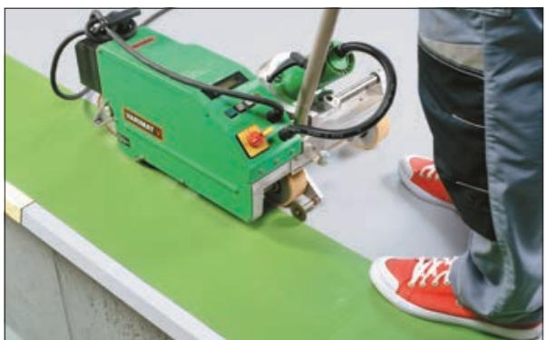
9. Со стороны кровли приварите полосу к основному кровельному ковру с помощью автоматического оборудования горячего воздуха.
