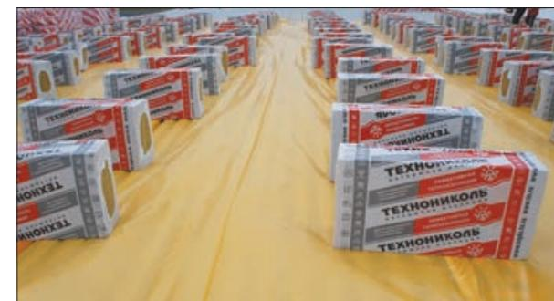
Рис. 3.1.4 Укладка пароизоляционной пленки ТЕХНОНИКОЛЬ
