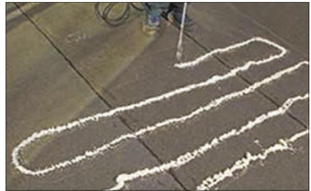
2. Наносите клей-пену полосами, оптимальное расстояние между полосами — 300 мм. Примерно через 10 минут после нанесения, когда закончится процесс поднятия и стабилизации пены, можно начинать укладку плит LOGICPIR.
