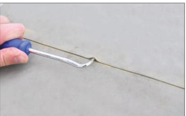
Рис. 5.2.9 Контроль при помощи специальной чертилки
