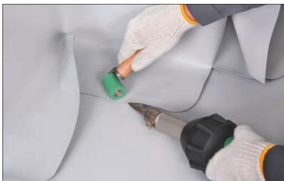
11. Далее приварите нахлест мембранны к основному кровельному ковру обычным образом с помощью силиконового ролика.
