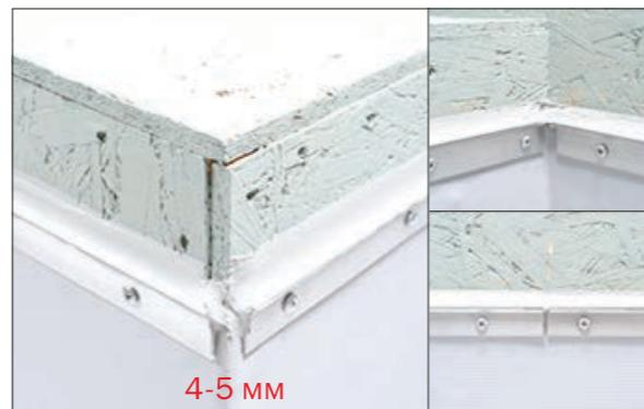
20. При креплении на наружном и внутреннем углах между краевыми рейками оставьте зазор в 4–5 мм. Края реек усильте дополнительным креплением.
