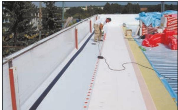
Рис. 3.5.17 Монтаж метровых рулонов ТЕХНОНИКОЛЬ
