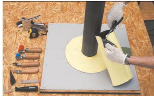
10. Снимите заготовку с трубы и закруглите ножницами нижний угол мембранны в нахлесте.
