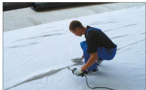
Рис. 3.3.1 Сварка полотнищ геотекстиля между собой
