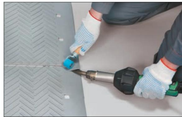
3. Следующий элемент достаточно зафиксировать только в одном месте. Приварите «ушки» элементов вручную с обеих сторон.
