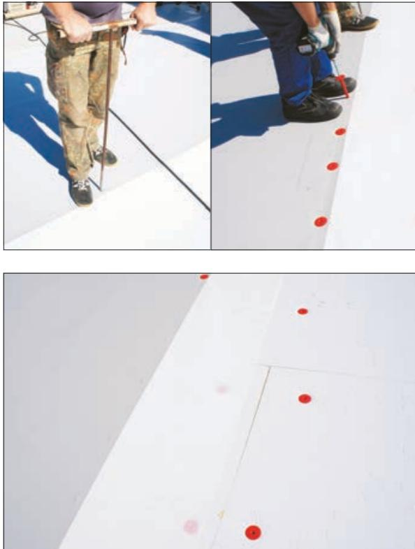
Рис. 3.2.1 Крепление мембранны и плит утепления с предварительным прокалыванием в случае использования жестких полимерных материалов (XPS, LOGICPIR)
