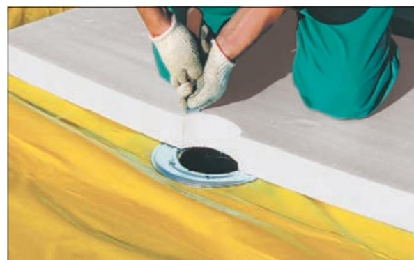
2. Для получения ровного твердого основания вокруг воронки, чтобы избежать проваливания воронки, используйте плиты XPS. Желательный размер такой площадки не менее — 1x1 м.
