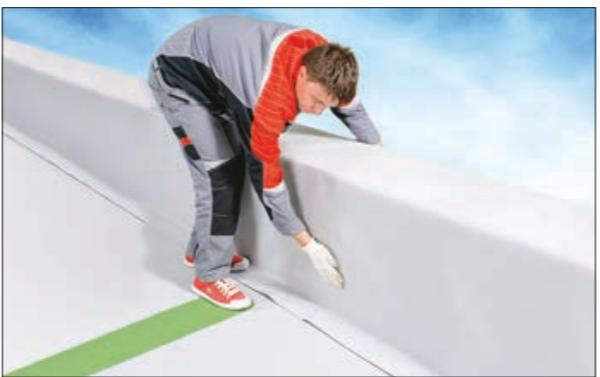
12. В случае низкого парапета (обычно высотой 350 мм) перекиньте мембрану через парапет и, натягивая наружу одной рукой, второй рукой выглаживайте мембрану вверх, чтобы избежать появления волны.
