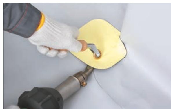
6. Приварите заготовку к основанию вдоль ребра латунным роликом.
