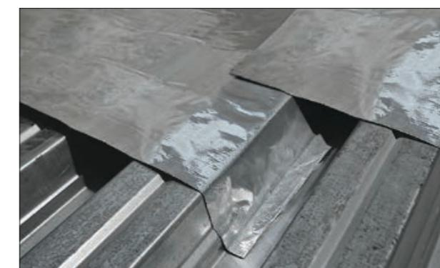
Рис. 3.1.12 Формирование продольного нахлеста пароизоляции на профлисте
