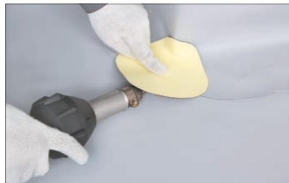
4. Примерьте полученную заготовку. Она должна плотно прилегать ко всем сторонам изолируемого угла. Зафиксируйте заготовку к основанию с помощью фена.
