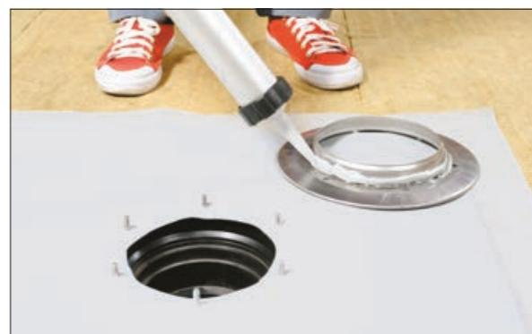
8. Для повышения надежности соединения нанесите ПУ герметик на внешний край воронки.
