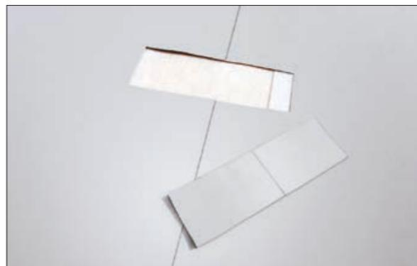
**5.2.19** При обнаружении дефекта сварки края шва дефект может быть устранен при помощи ручного сварочного аппарата. При обнаружении складок, пустот, нарушений целостности самой мембранны необходимо выполнить ремонт таких участков наложением заплат. Заплата должна перекрывать повреждение не менее чем на 50 мм по всем направлениям. Края заплаты скругляются.
