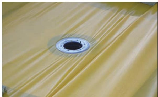
1. Желательно использовать двухуровневую воронку. Нижний фланец воронки позволяет надежно зажать пароизоляционную пленку для обеспечения сохранения пароизоляционной функции в месте проходки сквозь пленку.
