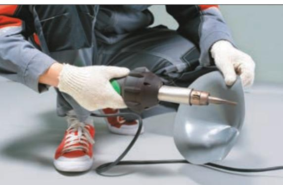
21. Затем прогревайте небольшой участок нижней части заготовки, двигая соплом фена вдоль него, до тех пока мембрана не станет пластичной.
