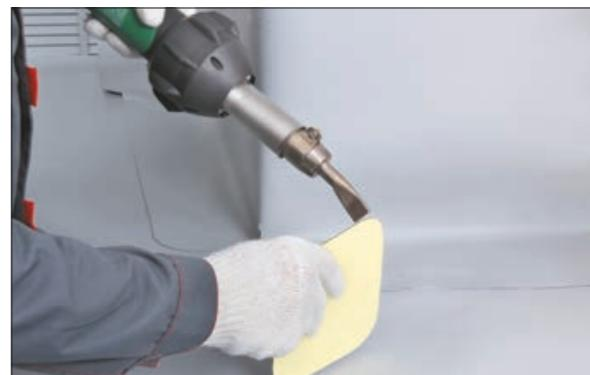
2. Примерьте заготовку по месту. С помощью ручного фена прогревайте один из углов
