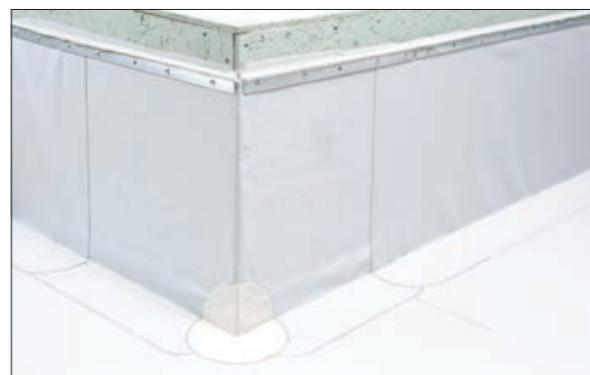
22. Проверьте качество сварных швов пробником. Швы, сделанные вручную, обработайте жидким ПВХ.
