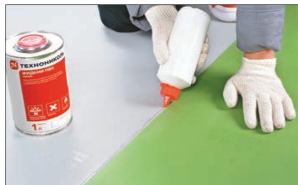
12. Нанесите жидкий ПВХ ТЕХНОНИКОЛЬ на все сварные швы примыкания к карнизу.
