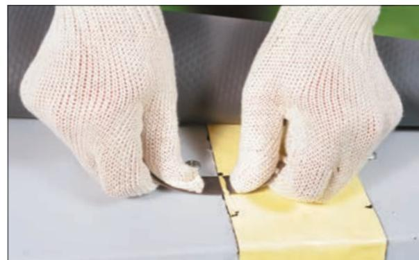
10. Снимите фаску по краям куска неармированной мембранны на величину сварного шва (не менее 30 мм).
