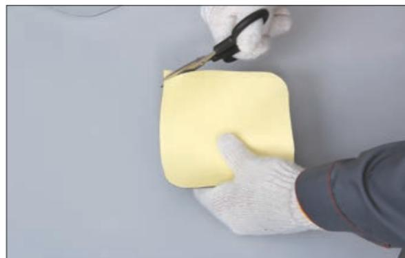
1. Вырежьте заготовку из неармированной мембранны V-SR (условно показана желтым цветом) таких размеров, чтобы она не менее чем на 30 мм перекрывала нахлест вертикальной и горизонтальной мембранны. Закруглите все углы заготовки с помощью ножниц.
