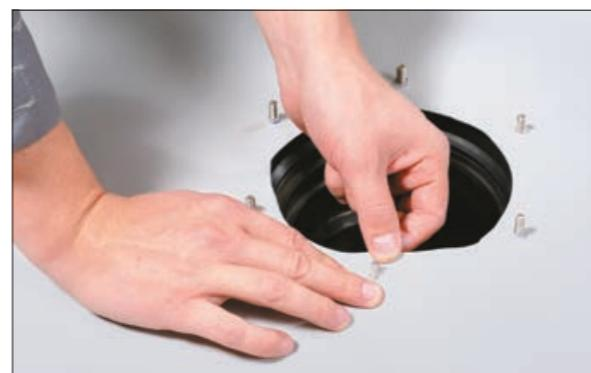
7. Возьмите кусок мембранны LOGICROOF V-RP размером 1x1 м, приложите к воронке и сделайте надрезы ножом в местах установки шпилек, а затем наденьте мембрану на шпильки. Для удобства работы можно использовать готовый фартук из мембранны.
