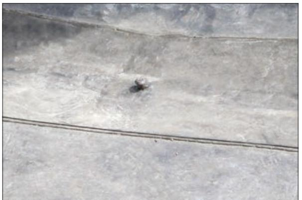
Рис. 3.5.10 Повреждение мембранны шляпкой самореза при применении тарельчатого металлического держателя по минераловатному утеплителю
