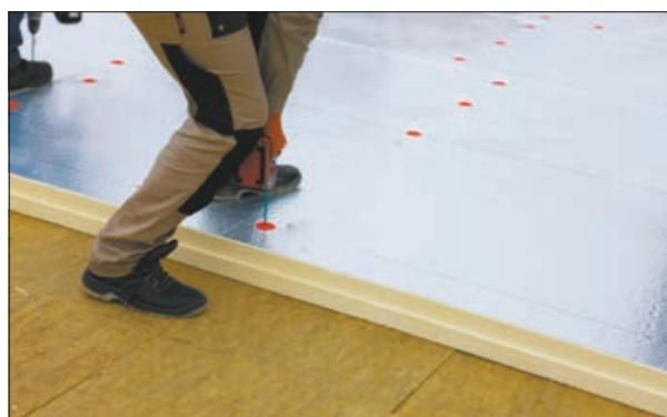
Рис. 2.4.1 Монтаж системы ТН-КРОВЛЯ Смарт PIR
