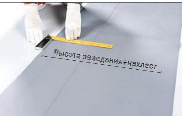
1. Ширина полосы = высоте заведения мембраны на парапет (либо длине мембранны, нужной для «оборачивания» парапета) + размеру нахлеста мембранны на горизонталь (не менее 150 мм). Подготовьте также узкую полосу армированной мембранны V-RP шириной 120 мм для изготовления «кармана».
