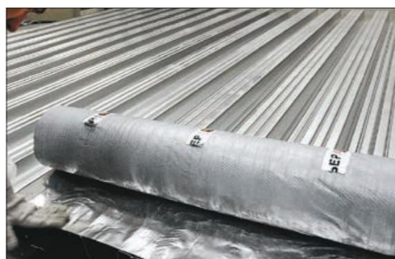
Рис. 3.1.11 Укладка пароизоляционного материала по профлисту
