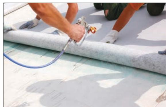
Рис. 2.9.7 Процесс нанесения kleя на основание и на мембранные
