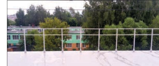
Рис. 4.8.20 Смонтированное кровельное ограждение ТЕХНОНИКОЛЬ
