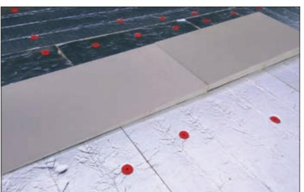
Рис. 3.3.12 Изображение LOGICPIR SLOPE с уклоном 1,7 %
