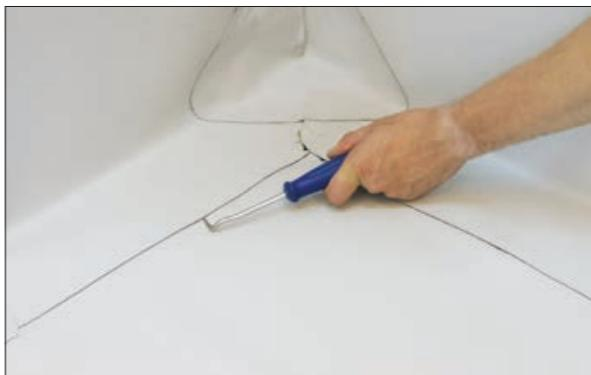
10. Проверяем качество швов при помощи чертилки.
