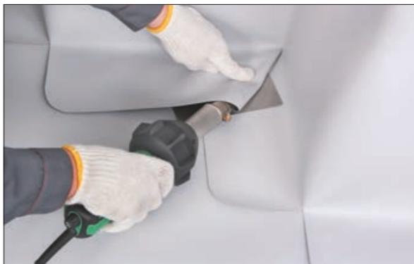
7. Для избежания повреждения нижних слоев материала подложите под петлю из мембраны металлическую пластину с обработанными краями толщиной 0,3-0,5 мм из оцинковки или нержавейки и сделайте прихватку.
