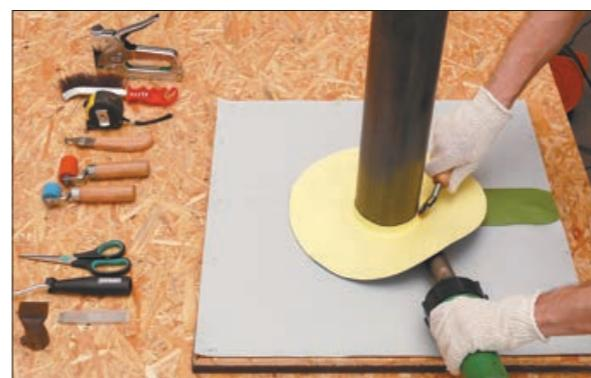
5. Приварите место перехода с вертикали на горизонталь с помощью фена, прикатывая латунным роликом. Снимите фаску с края заплатки на ширину сварного шва (не менее 30 мм).
