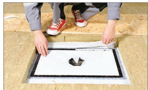
3. В случае использования одноуровневой воронки рекомендуется наклеить на пароизоляционную пленку бутил-каучуковую ленту по периметру листа усиления. Плиты XPS во время монтажа площадки плотно прижмите к ленте.
