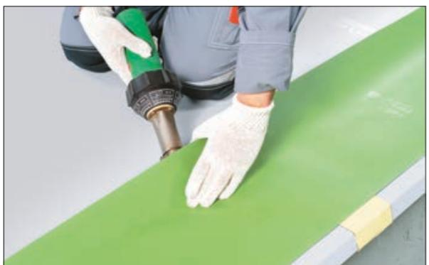
7. Вырежьте полосу армированной мембраны V-RP (условно показана зеленым цветом) шириной 300 мм и точно прихватите с помощью фена горячего воздуха к основному кровельному ковру.
