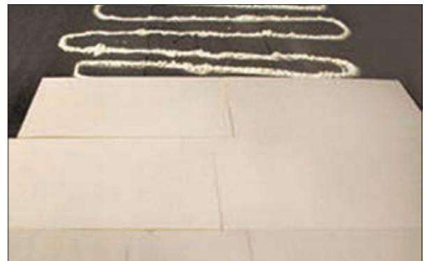
4. Оптимальный вариант — вести работу захватками, постепенно нанося пену и закрывая ее плитами LOGICPIR.
