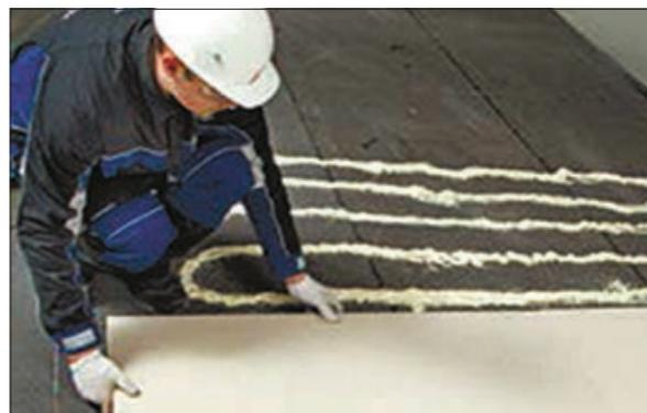
3. Укладывайте плиты LOGICPIR с легким прижимом. Страйтесь обеспечить максимальную ровность верхней плоскости плит для последующей приклейки к ним кровельной мембрани. Не наступайте на плиты сразу после приклейки к основанию!
