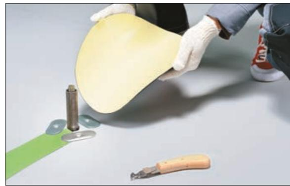
4. Вырежьте круглую заготовку из неармированной ПВХ мембранны V-SR (условно показана желтым цветом). Минимальный диаметр заготовки равен диаметру проходки плюс 150 мм. Для сохранения формы примыкания необходимо заполнить его утеплителем из каменной ваты.
