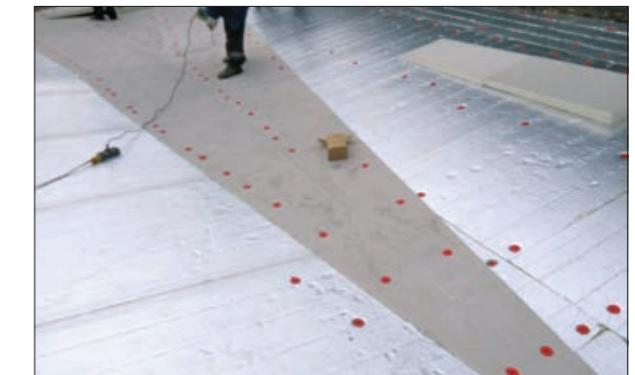
Рис. 3.3.16 Изображение разуклонки в ендove между воронками
