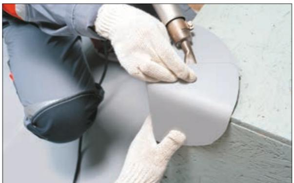
18. Соедините радиусы окружности, так чтобы получилась воронка с перехлестом на величину сварного шва (20 мм). Приложите деталь к углу и, притянув пальцами обе части окружности, точечно прихватите их друг к другу феном.
