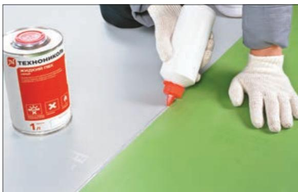
Рис. 3.4.2 Обработка стыка жидким ПВХ
