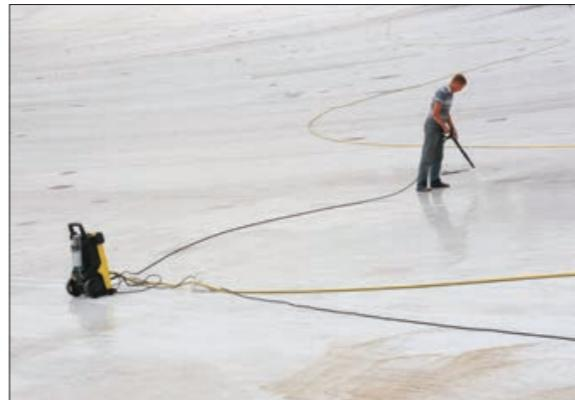
Рис. 2.9.5 – Рис. 2.9.6 Подготовьте старое основание: очистите, обеспыльте, просушите
