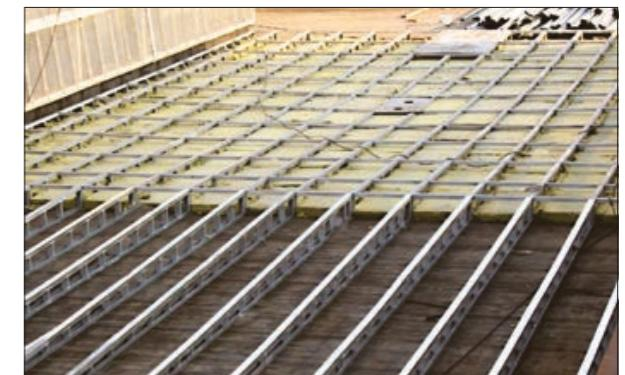
Рис. 3.3.3 Вариант устройства разуклонок
