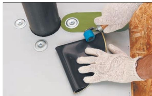
2. Сложите заготовку пополам и прикатайте место сгиба роликом. Затем сложите вчетверо и прикатайте место сгиба. Отрежьте вершину заготовки ножницами так, чтобы получилось внутреннее отверстие на 50 мм меньше диаметра трубы.
