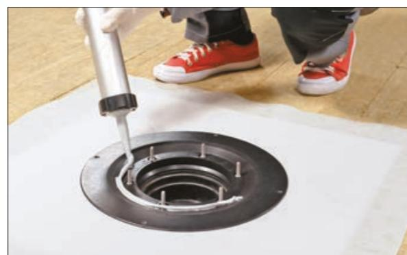
6. Для дополнительной герметизации нанесите ПУ герметик по внешнему контуру воронки и замажьте герметиком гайки.
