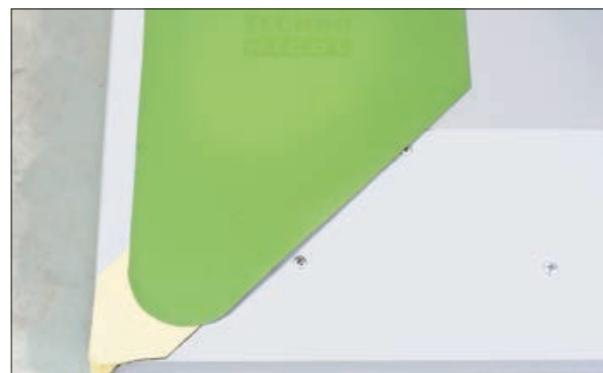
8. Закруглите угол полосы с помощью ножниц и подрежьте торец под углом 45°.
