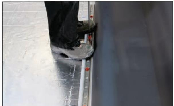
Стальная прижимная рейка применяется для крепления полимерной мембрани на кровлях с высокой ветровой нагрузкой. Рейка укладывается в шов между соседними рулонами мембрани либо поверх мембрани с установкой дополнительной заплатки шириной 20 см. Рейка крепится механически при помощи специальных полиамидных телескопов в сочетании с кровельными саморезами ТЕХНОНИКОЛЬ.
