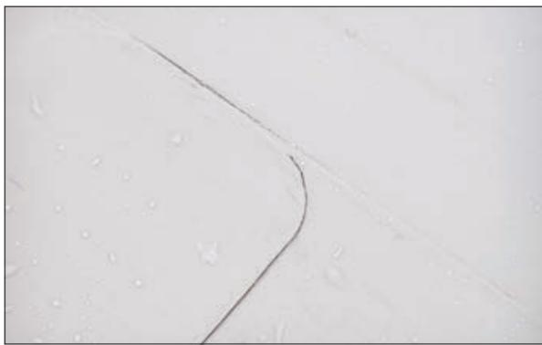
Рис. 5.4.1 Скругление углов мембранны
