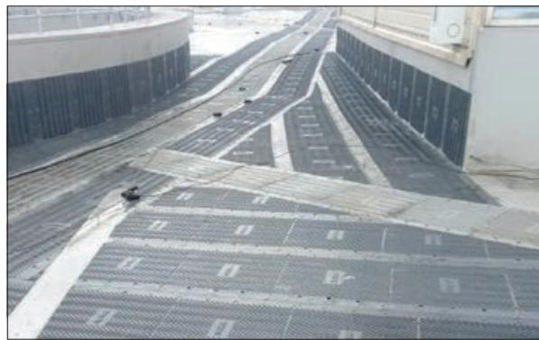
Рис. 4.8.19 Устройство защиты кровли с помощью дорожек LOGICROOF Walkway Puzzle
