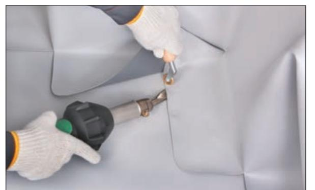
10. Приварите шов в месте перехода из «конверта» внахлест мембранны при помощи латунного ролика.
