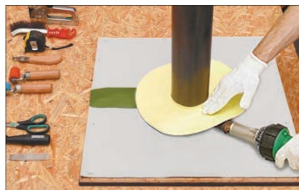
6. Приварите внутреннюю часть заготовки к основной мемbrane с помощью ручного фена.
