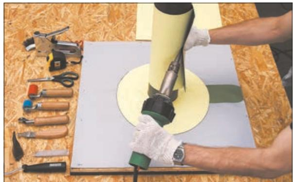
9. Оберните заготовку вокруг трубы, притяните ее пальцами и прихватите в нескольких местах внутри нахлеста с помощью ручного фена. Используйте узкую насадку шириной 20 мм. Для облегчения снятия заготовки с трубы предварительно вложите между ними полосу мембранны.
