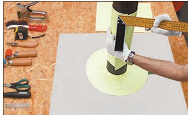
8. Вырежьте из неармированной мембранны V-SR полосу шириной 30–40 см. Длина полосы должна быть больше длины окружности трубы на 4 см, чтобы обеспечить нахлест для получения сварочного шва.
