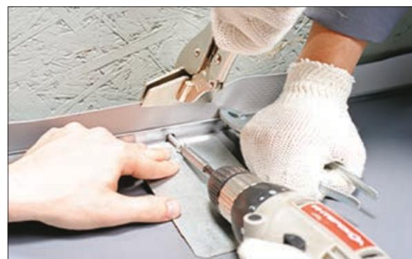
6. Вставьте прижимную рейку в «скрытый карман» и натяните мембрану «кармана» с помощью «зажима кровельщика», одновременно давя на рейку плоскогубцами. При креплении подкладывайте под крепеж металлическую пластину, чтобы избежать повреждения мембрани.
