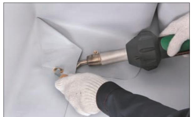
12. С помощью узкого латунного ролика приварите место перехода с нахлеста мембранны в «конверт».
