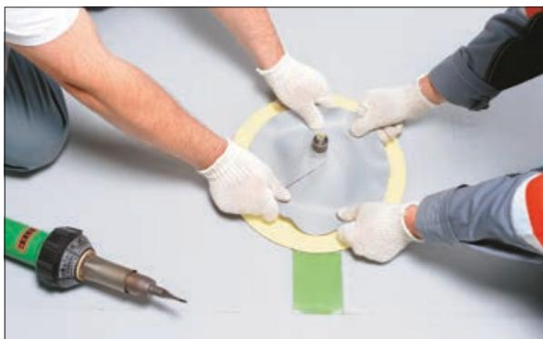
25. Быстрым движением, не допуская остывания мембранны, наденьте конус на элемент малого диаметра.
