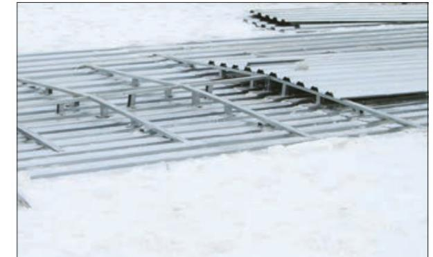
Рис. 3.3.4 Вариант устройства разуклонок
