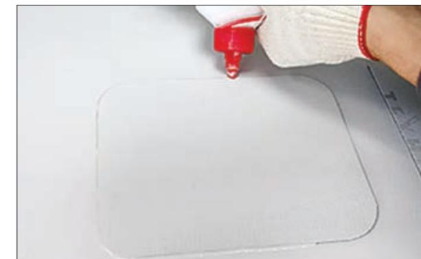
4. Для обеспечения дополнительной надежности от механических воздействий нанесите жидкий ПВХ ТЕХНОНИКОЛЬ по контуру заплатки.
