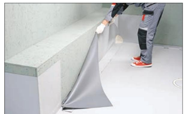
9. Поднимите свободный край заготовки на парапет.
