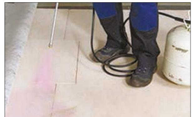
5. Через 3–5 часов после того, как пена наберет начальную прочность, приступайте к приклейке мембранны LOGICROOF FB к плитам LOGCPIR. Нанесите контактный клей на поверхность плит LOGCPIR.
