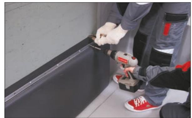
11. Поместите дополнительную рейку в карман. При закреплении крайнего крепежа тяните мембрану за угол по диагонали, чтобы избежать образования волны.
