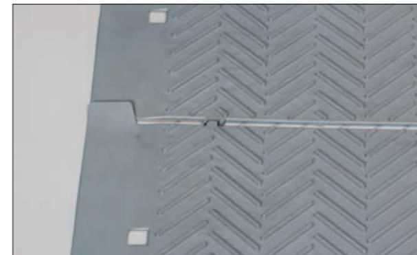
2. Следующий элемент укладывайте «шип-в-шип» с предыдущим. «Ушки» элементов располагайте таким образом, чтобы они не препятствовали прохождению автоматического сварочного аппарата.
