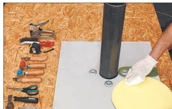
1. Вырежьте круглую заготовку из неармированной мембранны V-SR (условно показана желтым цветом) таким диаметром, чтобы на 40 мм перекрывать установленный крепеж.
