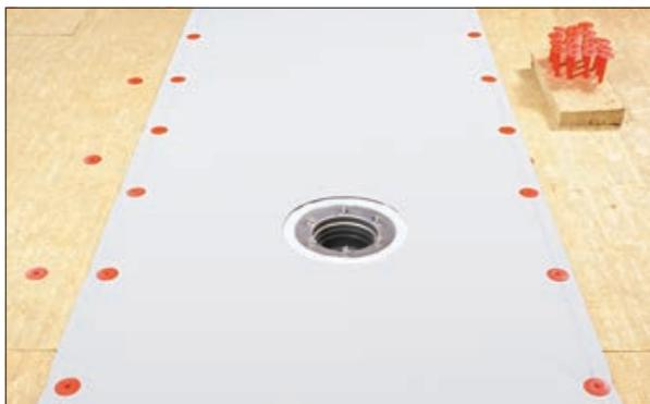
13. Разметку отверстия в мемbrane легко выполнить при помощи полоски мембранны и маркера. Используя приспособление как циркуль, нарисуйте окружность радиусом на 6 см больше радиуса фланца. Аккуратно вырежьте мембрану по линии при помощи ножниц, не допуская повреждения фартука.
