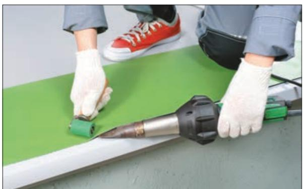
11. Приварите полосу к готовому элементу с помощью ручного фена. Проверьте пробником все швы, особенно тщательно — место нахлеста армированной мембранны к неармированной мембрани.
