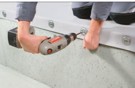
1. Закрепите основной кровельный ковер механически, заведя его за карниз. Для крепления используйте металлические шайбы.
