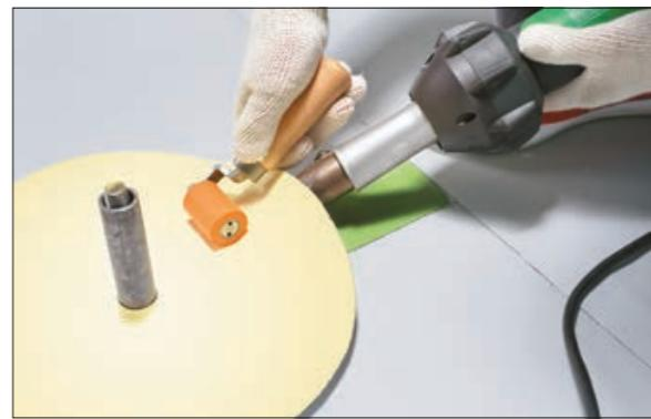
10. Приварите заготовку к основной мембрани, обращайте особое внимание на места сварки с заплаткой. Проверьте качество сварки пробником.
