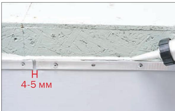
19. Срежьте мембрану над краевой рейкой острый ножом и нанесите герметик на отгиб краевой рейки.
