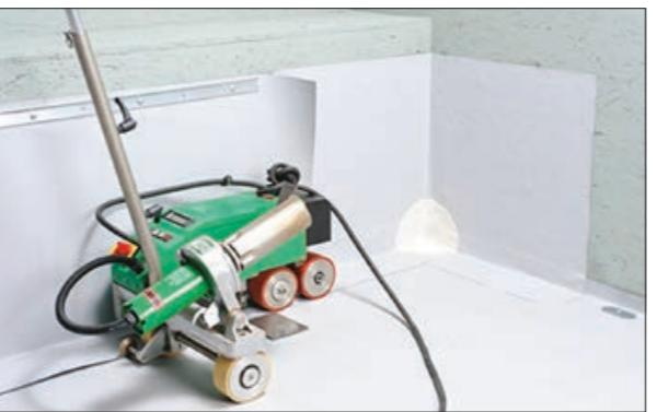
17. Закруглите все углы. Приварите полосу к основному кровельному ковру при помощи автоматического оборудования.
