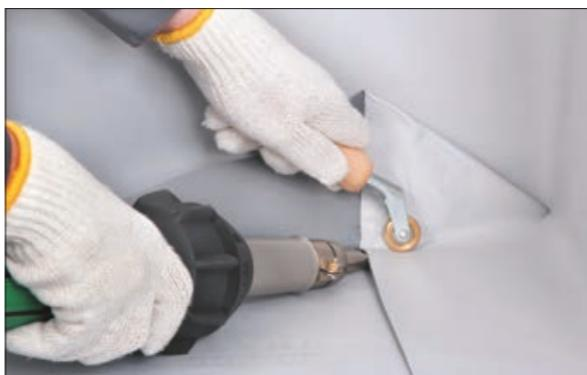
9. Приварите место примыкания полученного «конверта» к основному кровельному ковру с помощью узкого латунного ролика.
