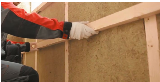
Рис. 3. Установка горизонтального каркаса под теплоизоляцию
