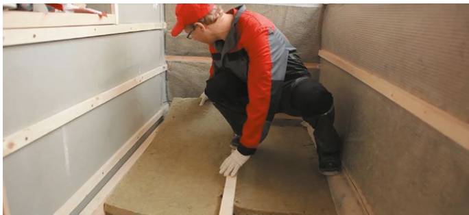
Рис. 9 Укладка теплоизоляционных плит
