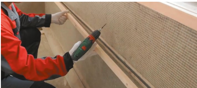
Рис. 6. Монтаж контррейки
