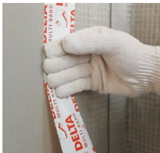
Рис. 12. Проклейка примыканий пароизоляции к стенам и окну
