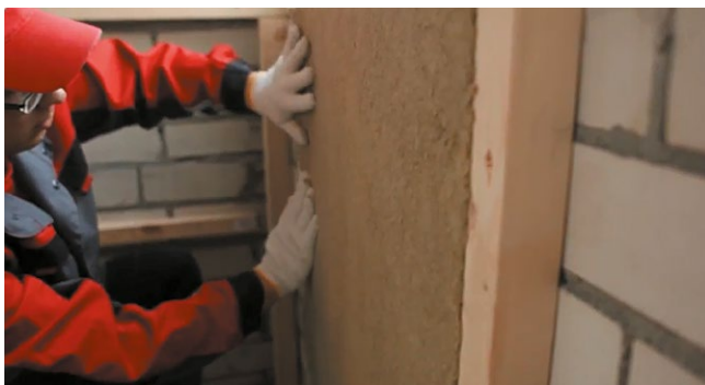
Рис. 2. Укладка плит теплоизоляции первого слоя
