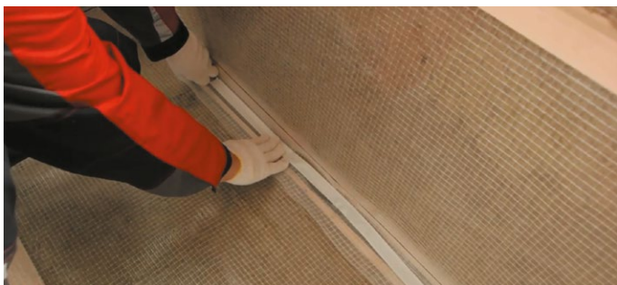
Рис.11. Проклейка нахлестов пароизоляции
