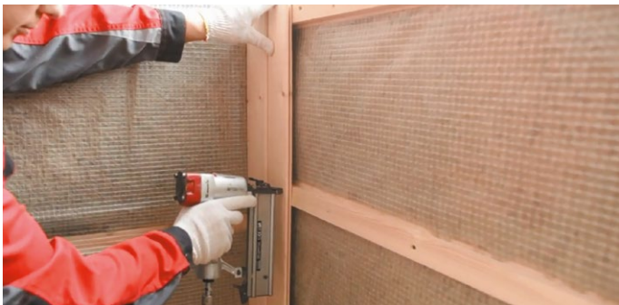
Рис. 7. Устройство внутренней обшивки
