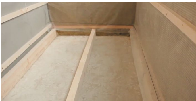
Рис. 8. Монтаж деревянных лаг на пол
