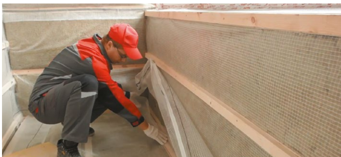
Рис. 10. Монтаж пароизоляционной пленки
