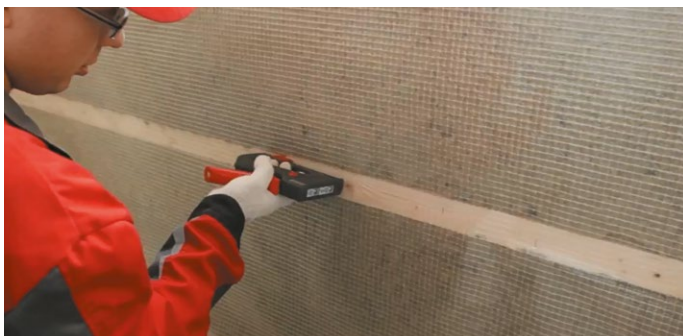
Рис.5. Монтаж пароизоляции
