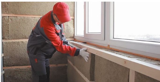
Рис. 4. Укладка плит теплоизоляции второго слоя
