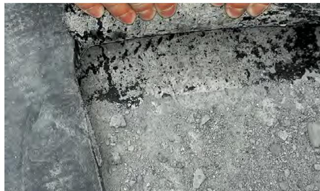
Рис. 3.6. Отсутствие адгезии материала к основанию из-за нанесения праймера на пыльную поверхность
