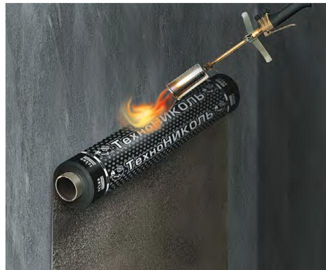
Рис. 4.18. Наплавление битумно-полимерного рулонного материала на вертикальную поверхность
