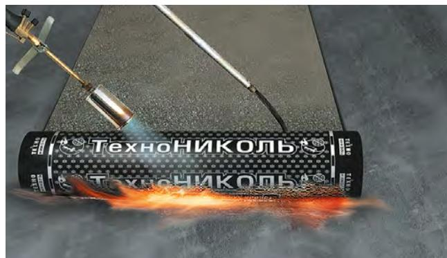
Рис. 4.8. Наплавление рулона
