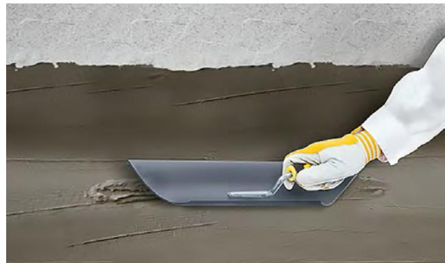
Рис. 3.3. Устройство выкружки
