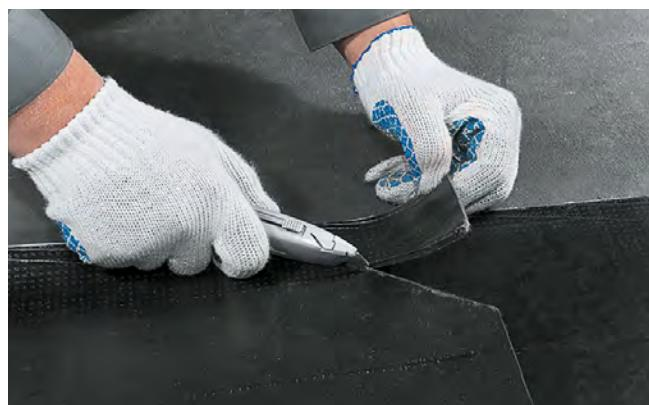
Рис. 4.5. Подрезка угла рулона в Т-образном шве
