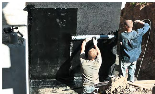
Рис. 4.17. Ручная и механическая подача рулона
