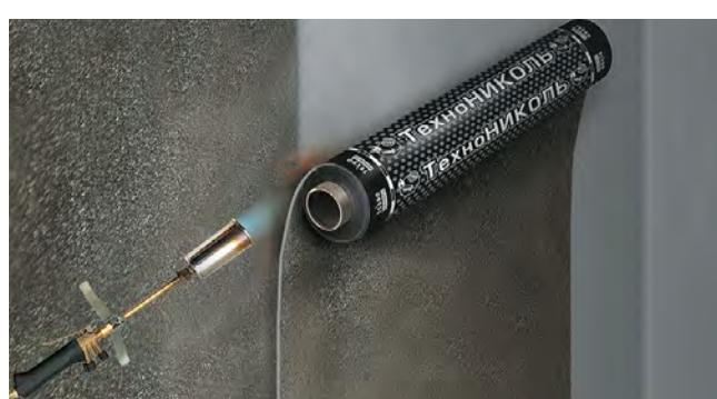
Рис. 5.6. Сварка нахлестов с последующей механической фиксацией рулона
