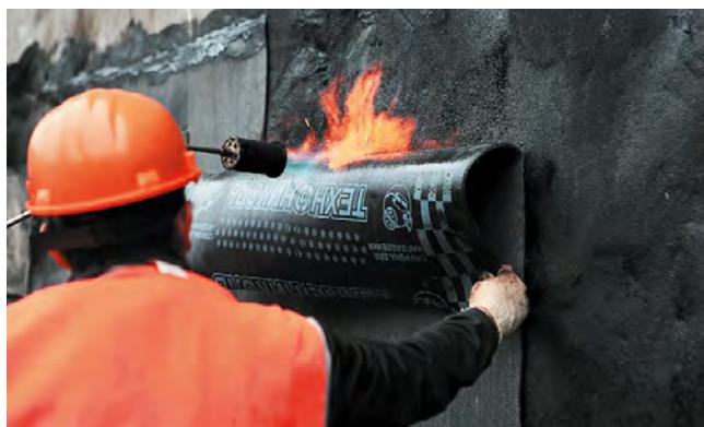
Рис. 2.3. Метод сплошного наплавления
