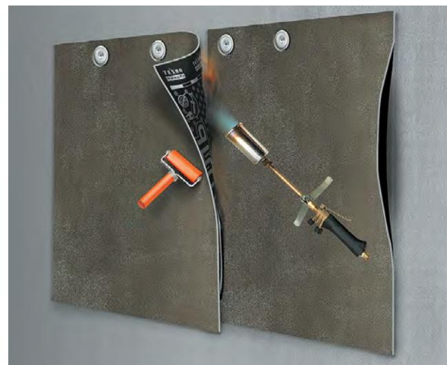
Рис. 5.5. Механическая фиксация рулона с последующей сваркой нахлестов
