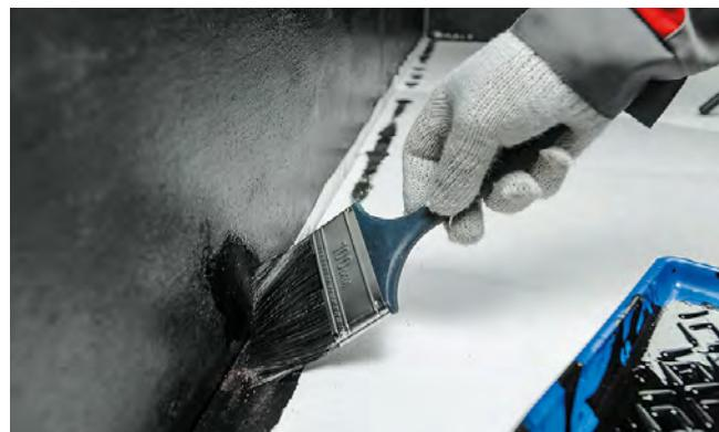
Рис. 3.7. Нанесение праймера кистью в зоне угла
