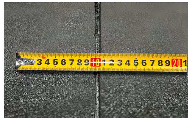
Рис. 4.10. Вытек битумного вяжущего из-под кромки материала
