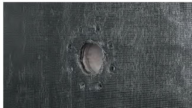
Рис. 6.12. Раскладка рулона первого и второго слоя Техноэласт Фундамент в зоне трубной проходки
