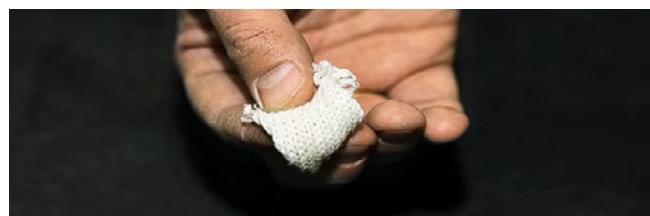
Рис. 3.8. Определение высыхания праймера
