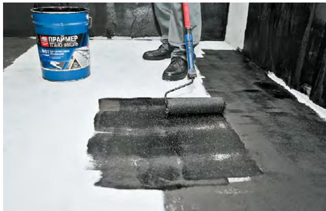
Рис. 3.5. Нанесение праймера
