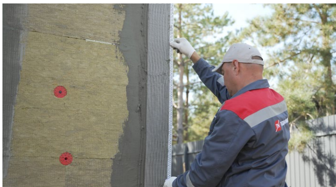
Рис. 15. Установка усиливающих профилей на углах здания
