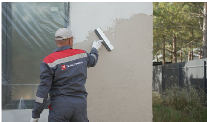
Рис. 19. Нанесение декоративного слоя штукатурки
