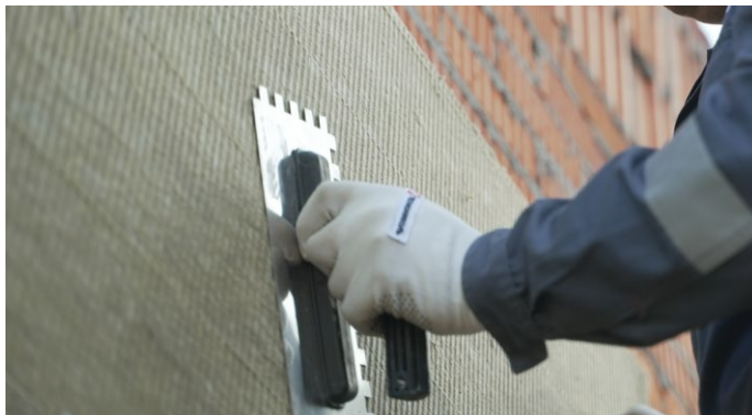
Рис. 12. Шлифовка стыков плит теплоизоляции
