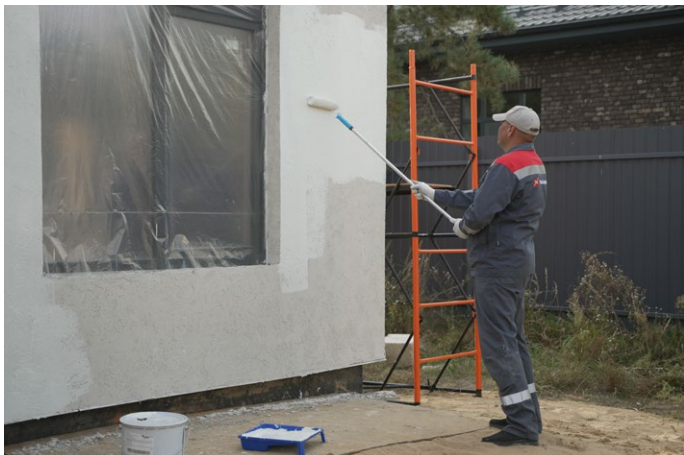
Рис. 20. Нанесение краски на поверхность фасада
