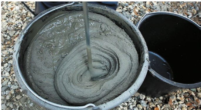
Рис. 3. Замешивание клея для приклейки теплоизоляции
