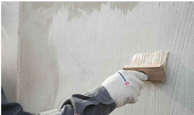
Рис. 18. Нанесение кварцевой грунтовки на поверхность базового штукатурного слоя
