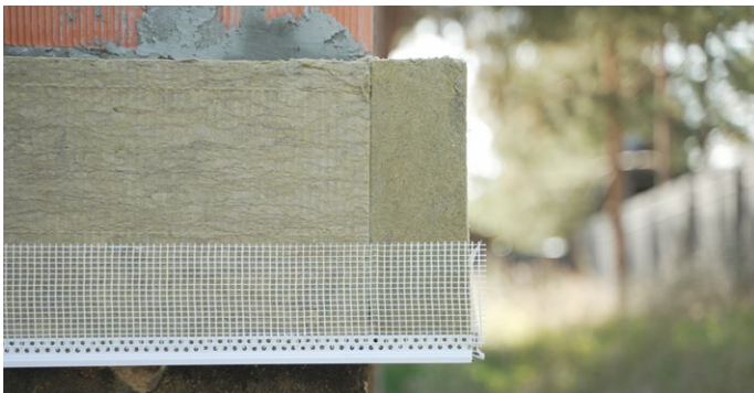
Рис. 8. Приклейка плиты теплоизоляции к стене
