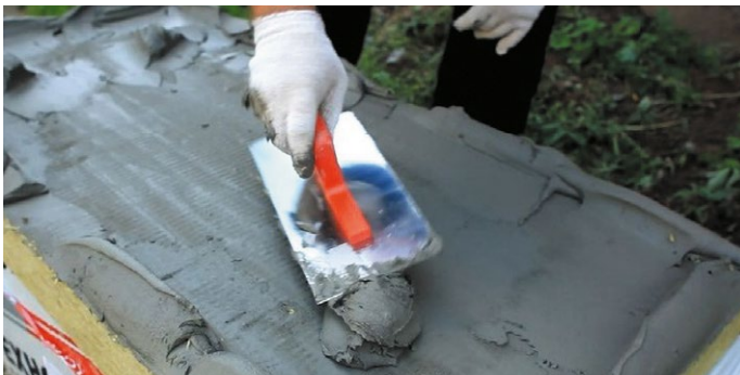
Рис. 6. Нанесение клея на плиту контурно-маячковым методом приклейки
