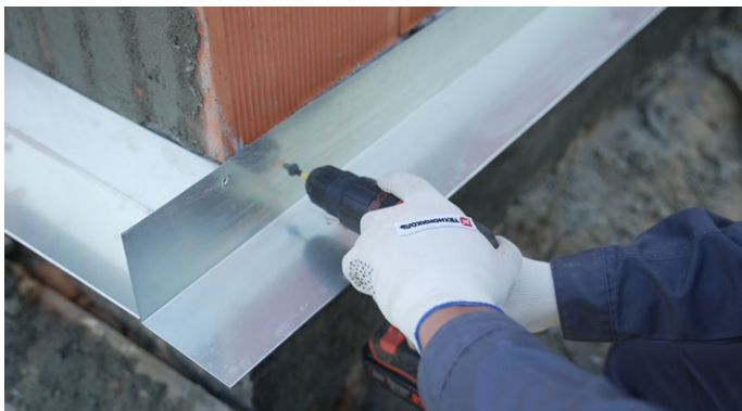
Рис. 2 а. Установка опорного профиля для первого ряда теплоизоляции с применением алюминиевого стартового профиля
