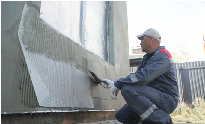
Рис. 16. Монтаж базового штукатурного слоя, армированного стеклосеткой
