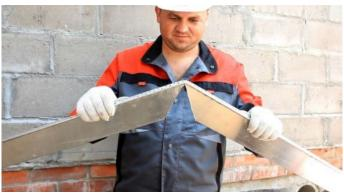
Рис. 2. Установка опорного профиля для первого ряда теплоизоляции а) с применением алюминиевого стартового профиля
