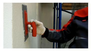
Рис. 18. Нанесение декоративного слоя штукатурки
