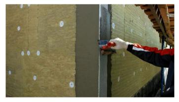
Рис. 15. Установка усиливающих профилей на углах здания
