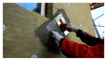
Рис. 14 б. Установка усиливающих элементов из армирующей сетки вокруг дверных и оконных проемов
