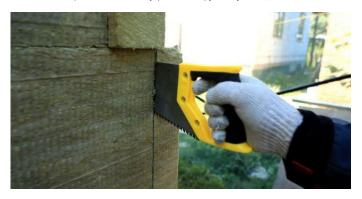
Рис. 10. Зубчатая перевязка плит на наружных углах здания
