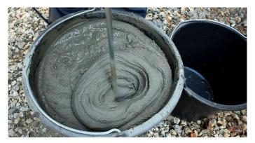
Рис. 3. Замешивание клея для приклейки теплоизоляции
