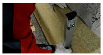
Рис. 8. Приклейка плиты тепло-, звукоизоляции к стене
