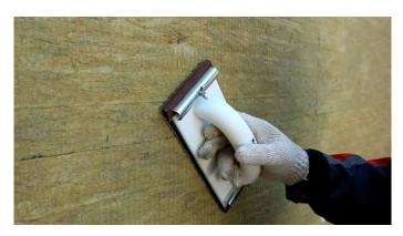
Рис. 12. Шлифовка стыков плит теплоизоляции наждачной бумагой
