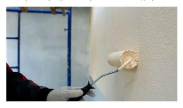
Рис. 19. Нанесение краски на поверхность фасада
