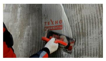
Рис. 16. Монтаж базового штукатурного слоя, армированного стеклосеткой
