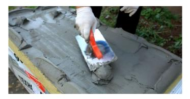
Рис. 6. Нанесение клея на плиту контурно-маячковым методом приклейки
