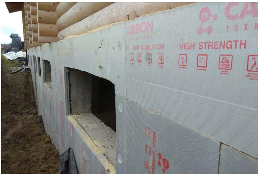
ются в гидроизоляционных системах: элементы утепления фундамента, дренажные элементы и элементы защиты гидроизоляционной мембраны от повреждения.
