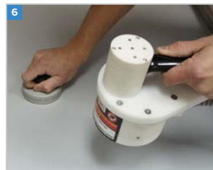
На время остывания мембрана прижимается к металлической тарелке специальным магнитом. Количество крепежей и схема их установки определяется согласно ветровому расчёту.
