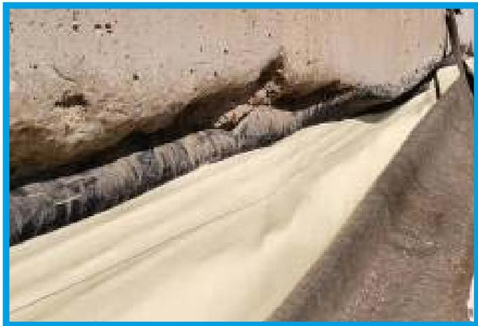
Рис. 10.4. Пример выполненного скругления монолитного бетона на участке примыкания гидрошпонки ЕС 320-4 и полимерной мембраны (с реального строительного объекта в Москве).
