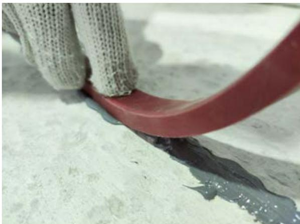
Уложите полимерный профиль поверх нанесенного в середине шва герметика. Зафиксируйте его плавным прижатием в свеженанесенный герметик. Минимальное расстояние от края шва до профиля должно быть не менее 8 см со всех сторон
