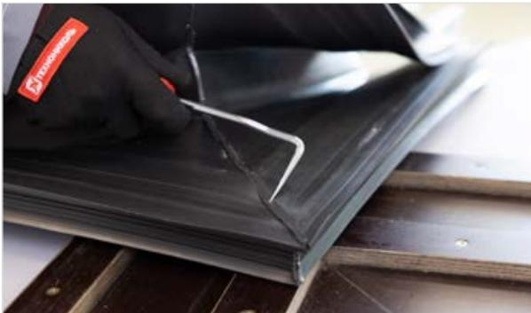
— Проверьте сварной стык пробником для шва.
