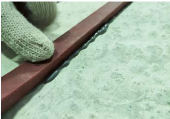
**Внимание!** Укладку бетона производить не ранее чем через 2-3 часа после нанесения герметика. Во избежание преждевременного запуска процесса набухания профиля LOGICBASE IC-SP 20x10 следует защитить его от попадания влаги.
