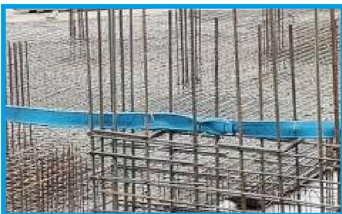
Рис. 10.3. Пример недопустимого соединения гидрошпонки встык без сварки (с реального строительного объекта в Москве).
