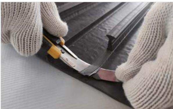
**ВАЖНО!** Обязательно снимите фаску с торца гидрошпонки на поверхности которой удалили ребра.
