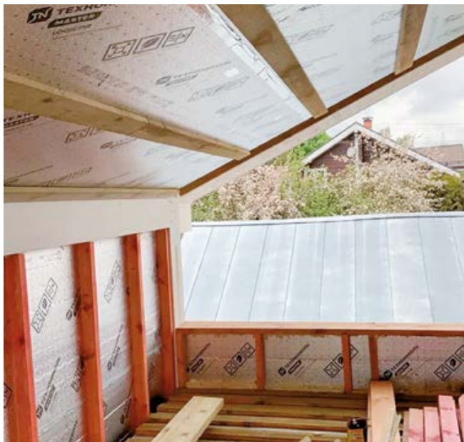
Контрутепление скатной кровли
