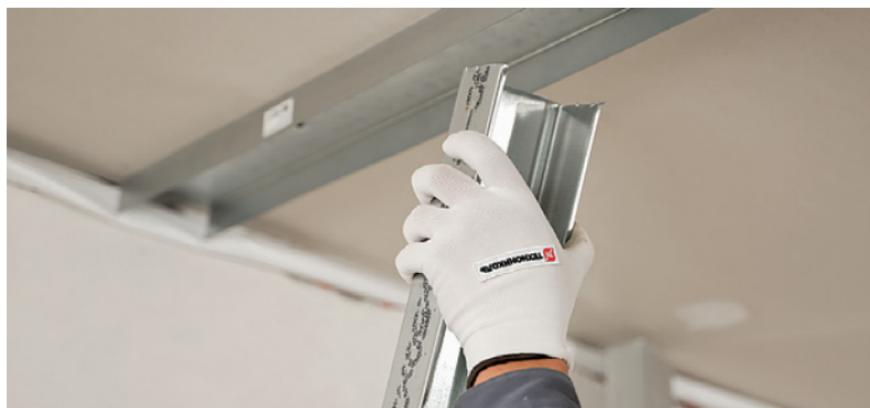
Стойный профиль устанавливается в строго вертикальном положении. Сначала вставляем его в нижний направляющий профиль, затем в верхний. Фиксируем профиль при помощи саморезов, заклепок или просекателя. Рекомендуемое расстояние между стойками профиля в свету 600 мм. Стоечный вертикальный профиль устанавливается на 10 мм ниже потолка помещения.
