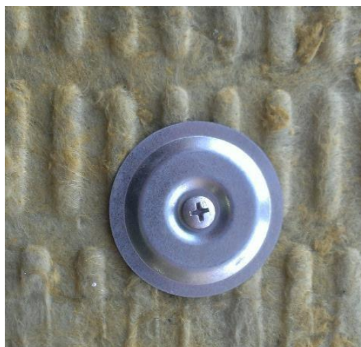
Рис. 4. Внешний вид крепления огнезащитного покрытия
