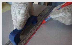
Произвести разметку поверхности листового материала (ЦСП, OSB, фанера) и теплоизоляционных плит ТЕХНОНИКОЛЬ CARBON в местах установки универсальной стяжки.
