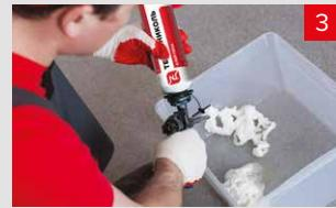
Отвернуть регулировочный винт пистолета, нажать на спусковой крючок, сливив некоторое количество пены.
