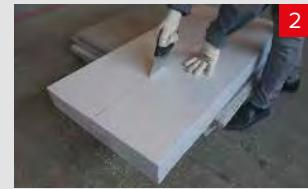
Произвести подготовку торцевых элементов несъемной опалубки фундамента, подрезав плиты в размер.
