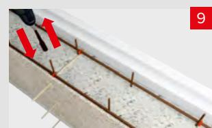
Произвести заливку бетонной смеси с виброплотением.
