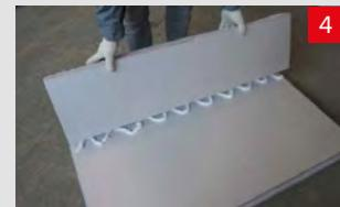
Нанести КЛЕЙ-ПЕНУ ТЕХНОНИКОЛЬ для пенополистирола на плиту теплоизоляции, установить торцевую плиту. Для надежного крепления необходимо соединить плиты друг с другом через 5–7 минут после нанесения клея.
