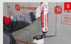
Для предотвращения образования мостиков холода зазоры шириной от 2 до 5 мм допускается заполнять КЛЕЙ-ПЕНОЙ ТЕХНОНИКОЛЬ для пенополистирола. Зазоры шириной более 5 мм необходимо заполнять фрагментами из материала теплоизоляционного слоя.
