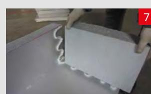
Приклеить теплоизоляционные плиты на другом торце. Нанести КЛЕЙ-ПЕНУ ТЕХНОНИКОЛЬ для пенополистирола на плиту, выждать 5–7 минут после нанесения клея и установить торцевую плиту.
