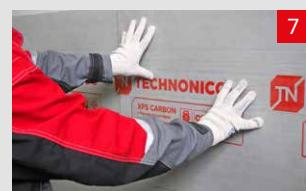
Приложить плиту с КЛЕЙ-ПЕНОЙ ТЕХНОНИКОЛЬ к стене и слегка надавить. Зафиксировать плиту до момента схватывания клея. Плиты следует крепить вплотную одна к другой.
