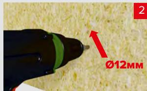
В листовом материале (ЦСП, фанера, OSB) просверлить отверстие Ø12 мм.
