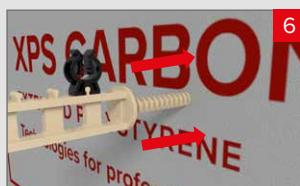
Закрепить универсальную стяжку на плите XPS ТЕХНОНИКОЛЬ CARBON, проходя через плиту стержнем. С обратной стороны плиты теплоизоляции установить замок (см. шаг 4).
