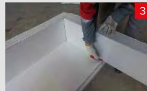
Произвести предварительную установку и подрезку торцевых плит теплоизоляции.
