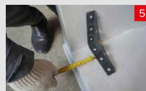
Произвести разметку мест для установки уголков. Отступ от края 50–100 см. Расстояние между уголками 300–400 мм.
