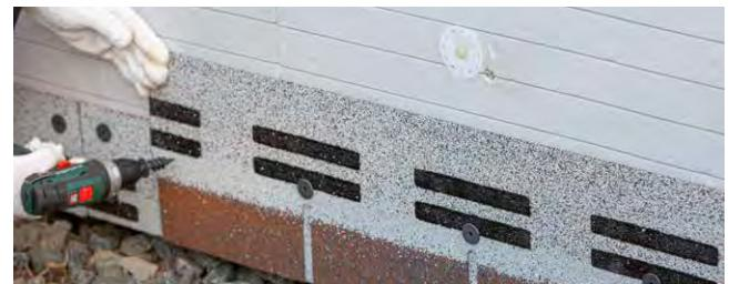
В зависимости от вида материала стены подбирается метод крепления и сам крепеж. Например, в стене из полнотелого кирпича необходимо выполнить штробу глубиной 10 мм, завести в нее верхний край планки и зафиксировать к верхней части цоколя, предварительно нанеся монтажную пену с низким вторичным расширением на верхнюю часть XPS под цокольную планку.
