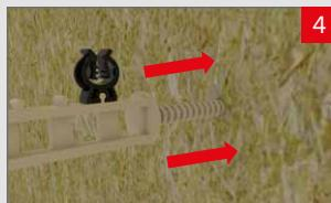
Установить универсальную стяжку в просверленное отверстие таким образом, чтобы закладная деталь под арматуру была сверху.
