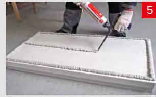
Нанести КЛЕЙ-ПЕНУ ТЕХНОНИКОЛЬ для пенополистирола по периметру плиты и одной полосой по центру.
