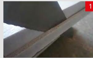
При необходимости, при помощи ножовки для теплоизоляции удалить L-кромку у плит XPS ТЕХНОНИКОЛЬ CARBON.
