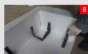
Зафиксировать плиты теплоизоляции угловым крепежом.
