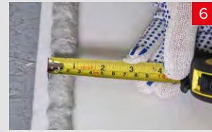
По периметру КЛЕЙ-ПЕНУ ТЕХНОНИКОЛЬ для пенополистирола следует наносить с отступом примерно 2 см от края. Ширина полос около 3 см.
