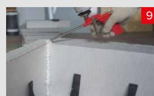
Зазоры между плитами заполнить КЛЕЙ-ПЕНОЙ ТЕХНОНИКОЛЬ для пенополистирола.
