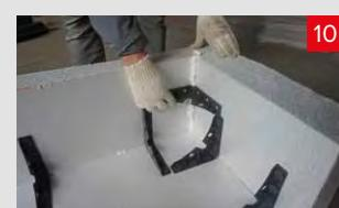
Соединить торцевые плиты теплоизоляции друг с другом при помощи углового крепежа.
