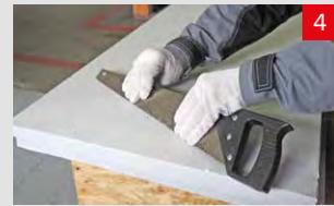
Перед началом монтажа плит XPS поверхность необходимо отфрезеровать. Фрезеровка может выполняться ножковкой по дереву или щеткой с металлическим ворсом. При использовании плит XPS ТЕХНОНИКОЛЬ CARBON ECO FAS фрезеровка не требуется.
