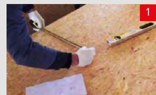
Установить закладную деталь под арматуру на универсальную стяжку на необходимом расстоянии (30, 50 или 70 мм) для обеспечения защитного слоя.
