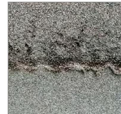
Материал с недостаточной теплостойкостью начинает течь с вертикальных и наклонных поверхностей в период летнего зноя, открывая водозащитный барьер.
