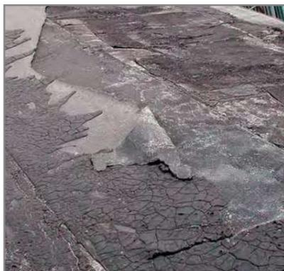
Тонкий материал спустя 15 лет. С течением времени легкие фракции битума «испаряются» с поверхности под воздействием ультрафиолетового излучения и теплового воздействия.
