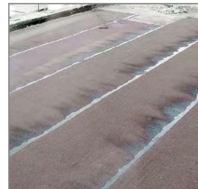
Тонкий материал легко пережечь. В течение короткого срока в местах пережога гидроизоляция разрушается и начинаются протечки.
