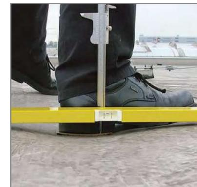
Под тонкой кровлей теплоизоляционные плиты подвержены вытаптыванию в процессе эксплуатации. Это сказывается на прочности теплоизоляционных плит, что в свою очередь приводит к появлению застойных зон.
